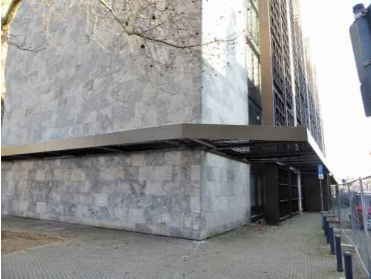
Aufgehängtes Schutzdach rings um das Gebäude, mit Netzen gegen Steinabsturz
