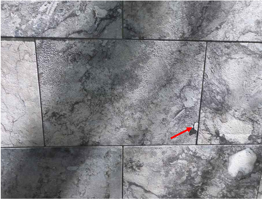
Typischer Natursteinbekleidung mit Ankerdornausbruch und Verformung
