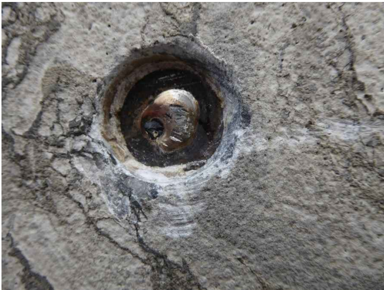
Stufenbohrung für die Nachverankerung mit eingeklebtem Injektionsanker
