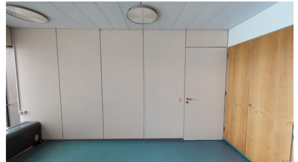
Abb. 26: Trennwand zwischen Büroraum 20-285 und 20-281b
