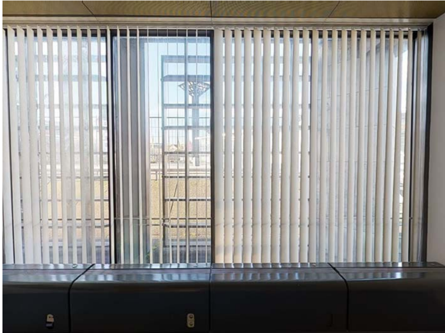
Abb. 9: Ansicht Wand West
