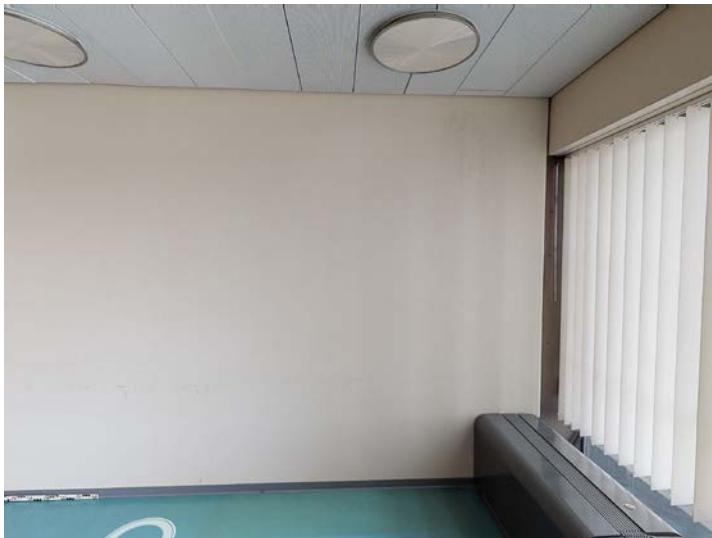
Abb. 20: Ansicht Wand Nord
