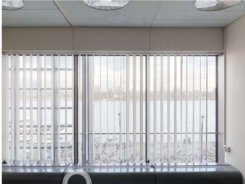
Abb. 22: Ansicht Wand Ost
