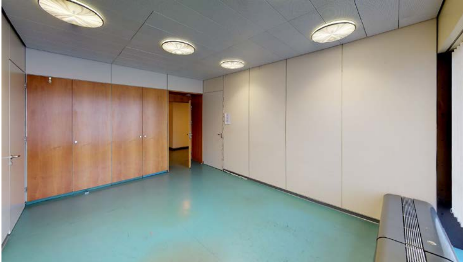
Abb. 14: Ansicht Wand West
