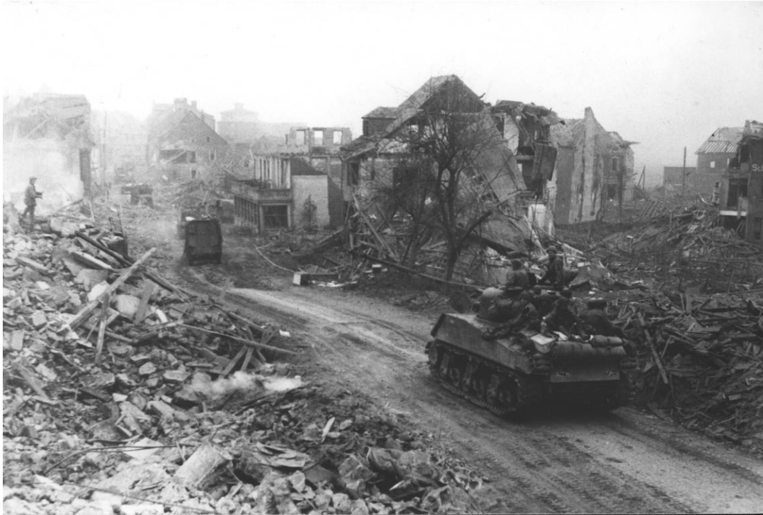
Panzer und Transportfahrzeuge der 3. US-Panzerdivision und der 104. US-Infanterie- Division passieren im Verband der 1. US-Armee am 27. März 1945 von der Kölner – Strasse aus kommend in Richtung Wilhelmstrasse das zerstörte Altenkirchen. Foto: Hollander (US-Army) Kreisarchiv Altenkirchen.
