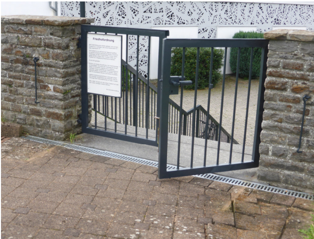
Das renovierte Eingangstor Friedhof
