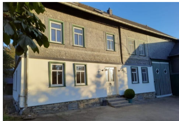
oben: Bauernhaus August Petry 1955 unten: Wohnhaus nach der gelungenen Sanierung
