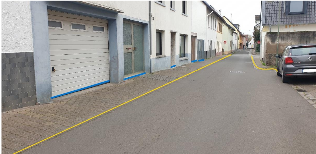
Abbildung 23: Notfließweg „Osterbergstraße“ mit Objektschutzmaßnahmen (blau) und Bordanlagen (gelb)
