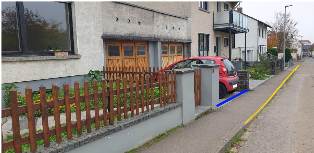
Abbildung 7: Notfließweg „Osterbergstraße“ mit Objektschutzmaßnahmen (blau) und Bordanlagen (gelb)
