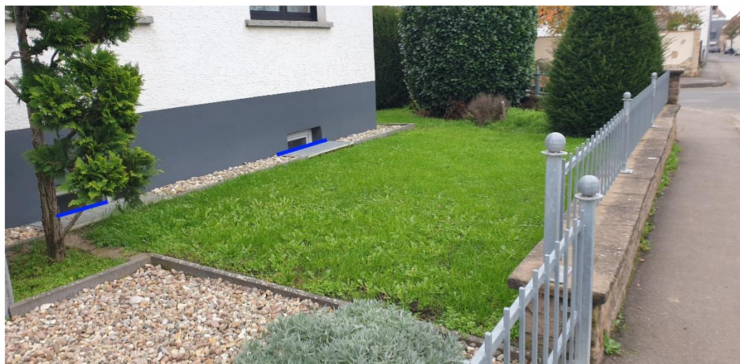
Abbildung 9: Notfließweg „Osterbergstraße“ mit Objektschutzmaßnahmen (blau) und Bordanlagen (gelb)
