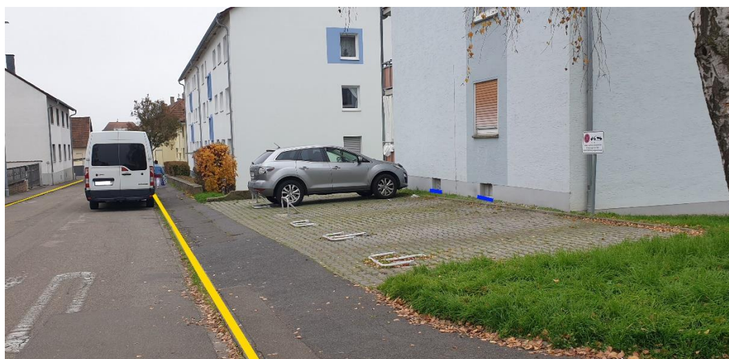
Abbildung 10: Notfließweg „Osterbergstraße“ mit Objektschutzmaßnahmen (blau) und Bordanlagen (gelb)
