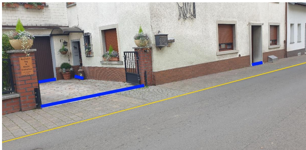
Abbildung 17: Notfließweg „Osterbergstraße“ mit Objektschutzmaßnahmen (blau) und Bordanlagen (gelb)
