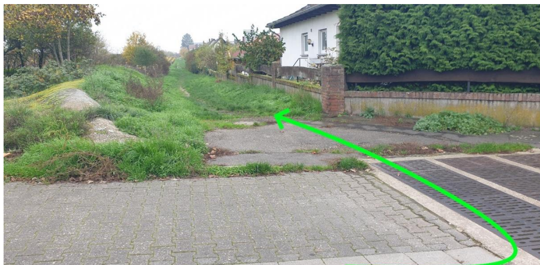
Abbildung 39: Notfließweg „Helmstraße“ mit Entwässerungsgraben (grün)
