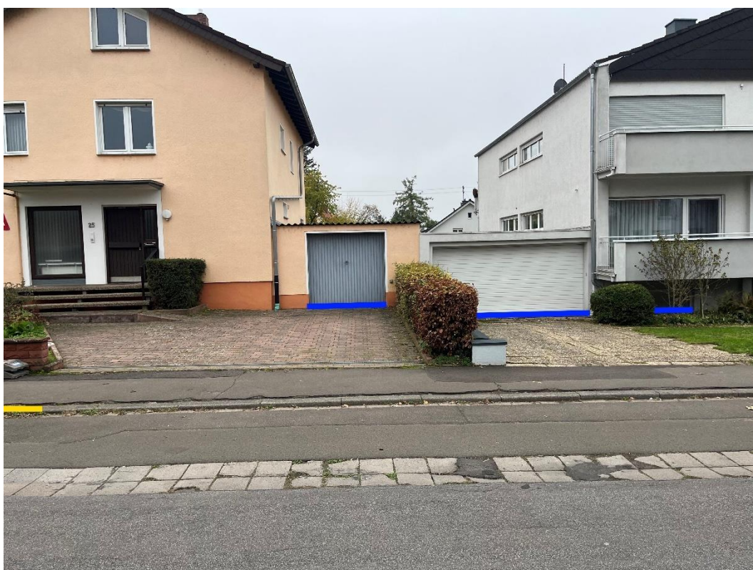
Abbildung 102: Notfließweg „Berlinstraße“ mit Objektschutzmaßnahmen (blau) und Bordanlagen (gelb)
