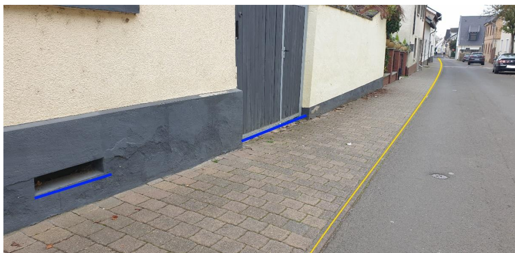
Abbildung 16: Notfließweg „Osterbergstraße“ mit Objektschutzmaßnahmen (blau) und Bordanlagen (gelb)
