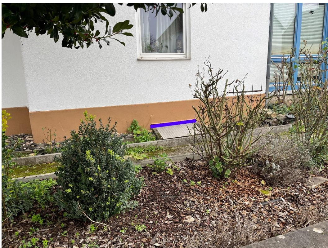
Abbildung 119: Notfließweg „Jakob-Ebermann-Straße“ mit Objektschutzmaßnahmen (blau)
