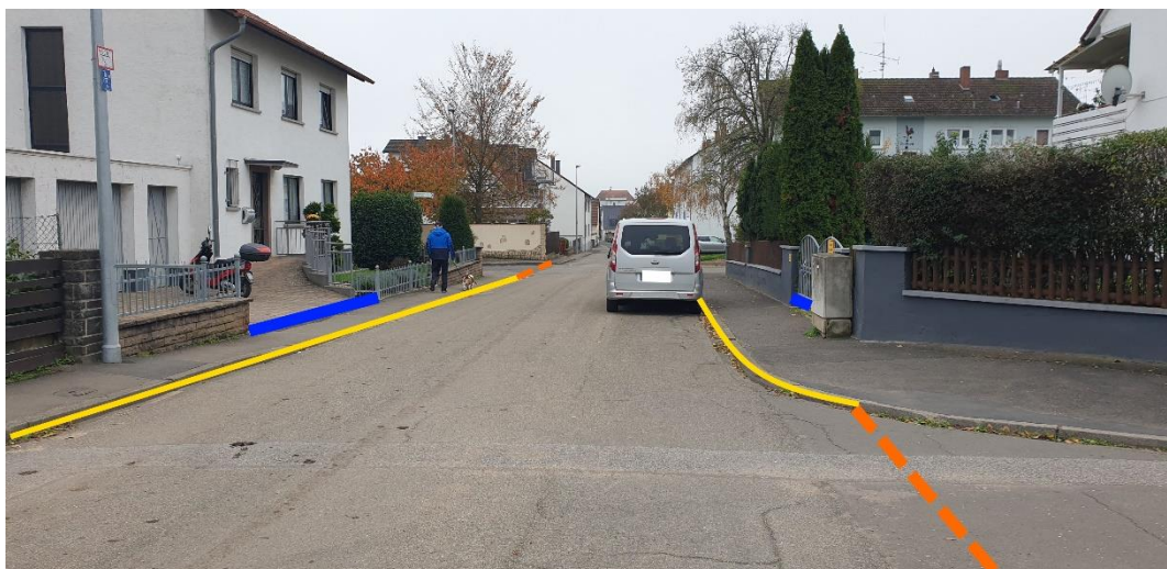
Abbildung 8: Notfließweg „Osterbergstraße“ mit Objektschutzmaßnahmen (blau) und Bordanlagen (gelb)
