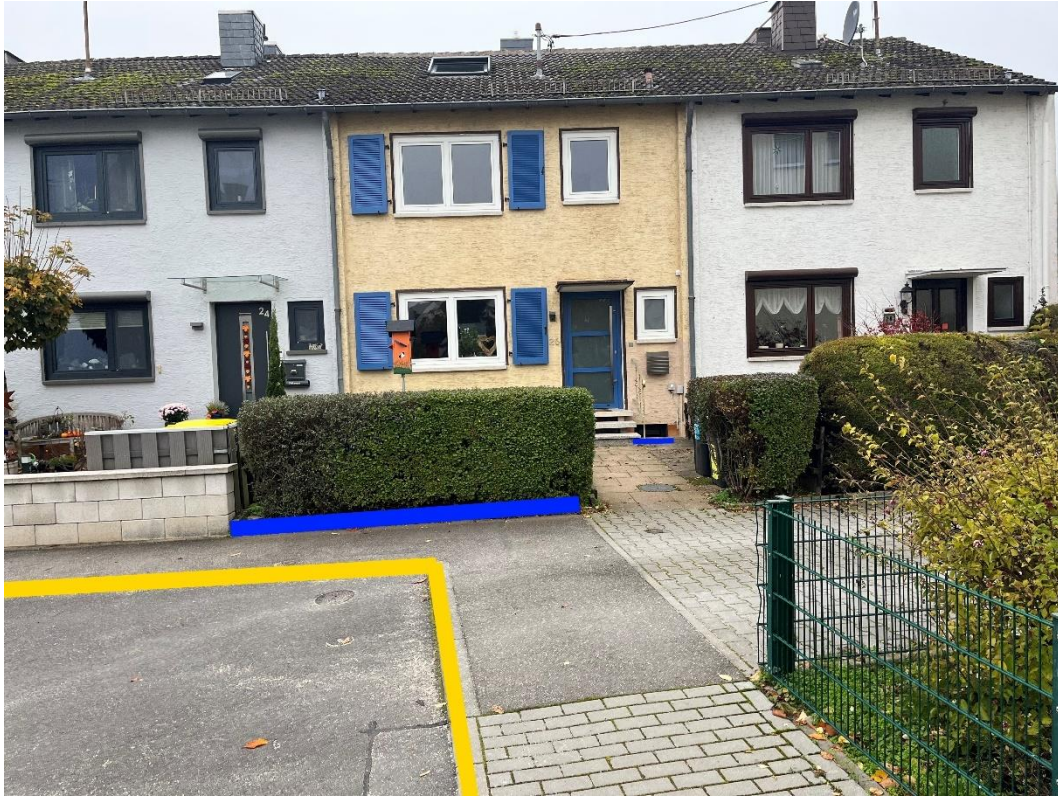
Abbildung 116: Notfließweg „Jakob-Ebermann-Straße“ mit Objektschutzmaßnahmen (blau) und Bordanlagen (gelb)
