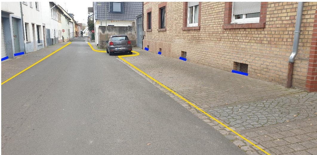
Abbildung 22: Notfließweg „Osterbergstraße“ mit Objektschutzmaßnahmen (blau) und Bordanlagen (gelb)
