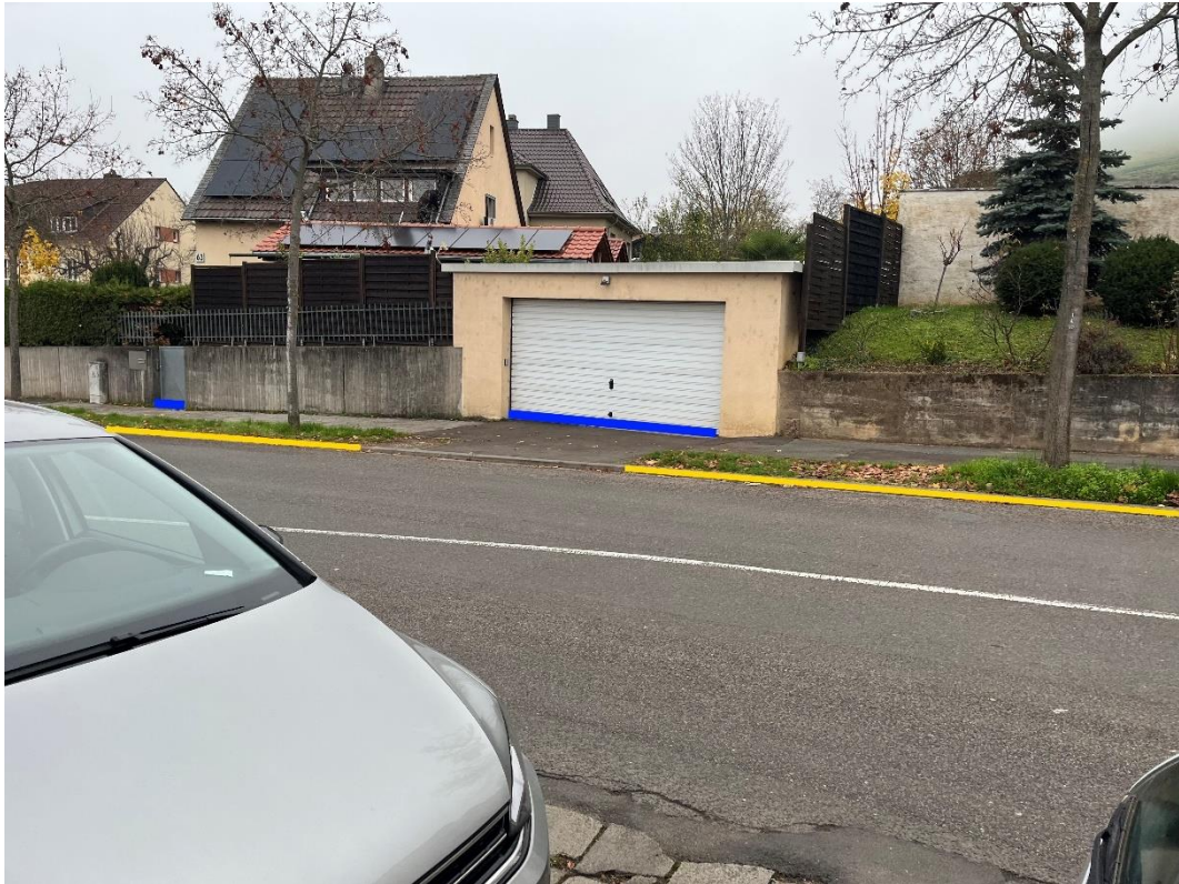
Abbildung 109: Notfließweg „Berlinstraße“ mit Objektschutzmaßnahmen (blau) und Bordanlagen (gelb)
