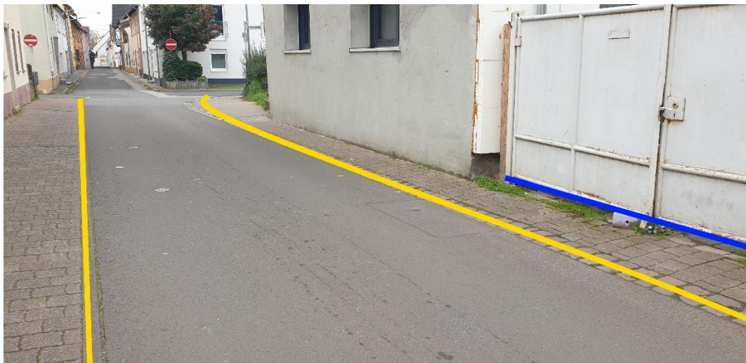
Abbildung 24: Notfließweg „Osterbergstraße“ mit Objektschutzmaßnahmen (blau) und Bordanlagen (gelb)
