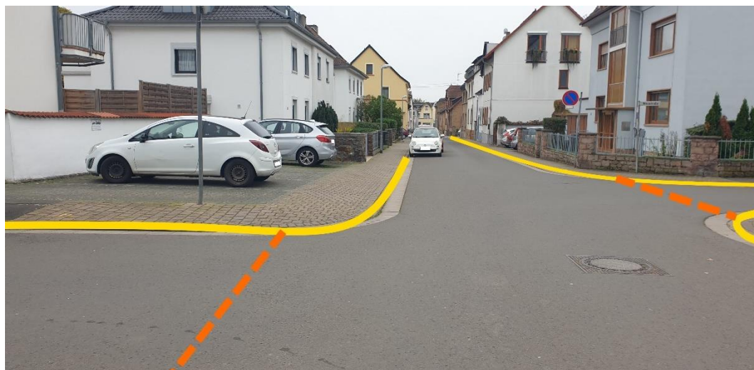
Abbildung 49: Notfließweg „Helmstraße“ mit Objektschutzmaßnahmen (blau), Aufwallung (orange) und Bordanlagen (gelb)
