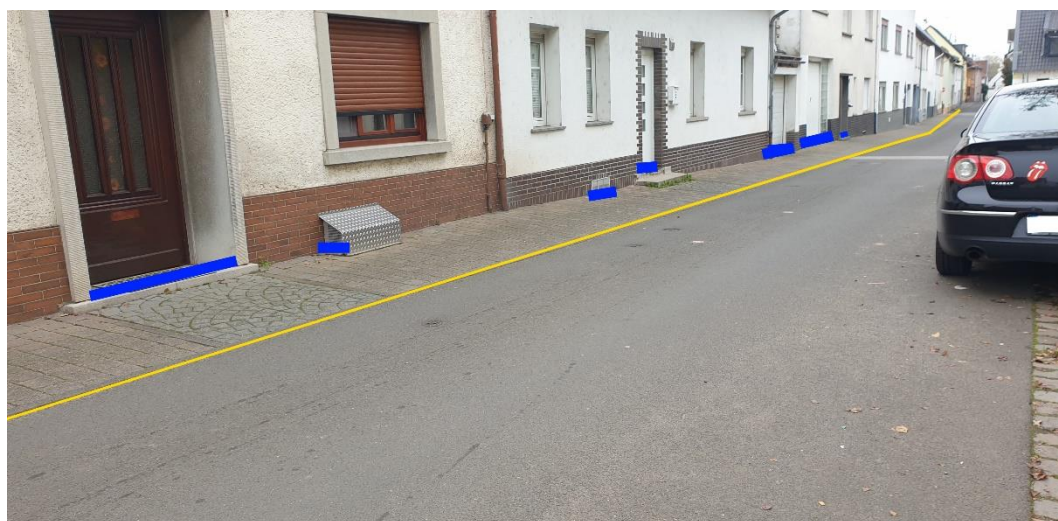
Abbildung 18: Notfließweg „Osterbergstraße“ mit Objektschutzmaßnahmen (blau) und Bordanlagen (gelb)
