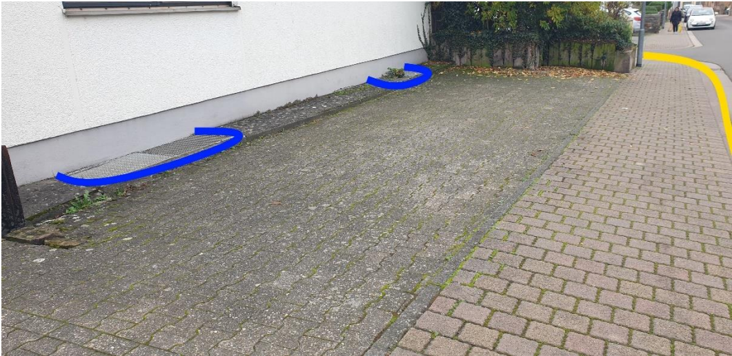
Abbildung 48: Notfließweg „Helmstraße“ mit Objektschutzmaßnahmen (blau) Bordanlagen (gelb)
