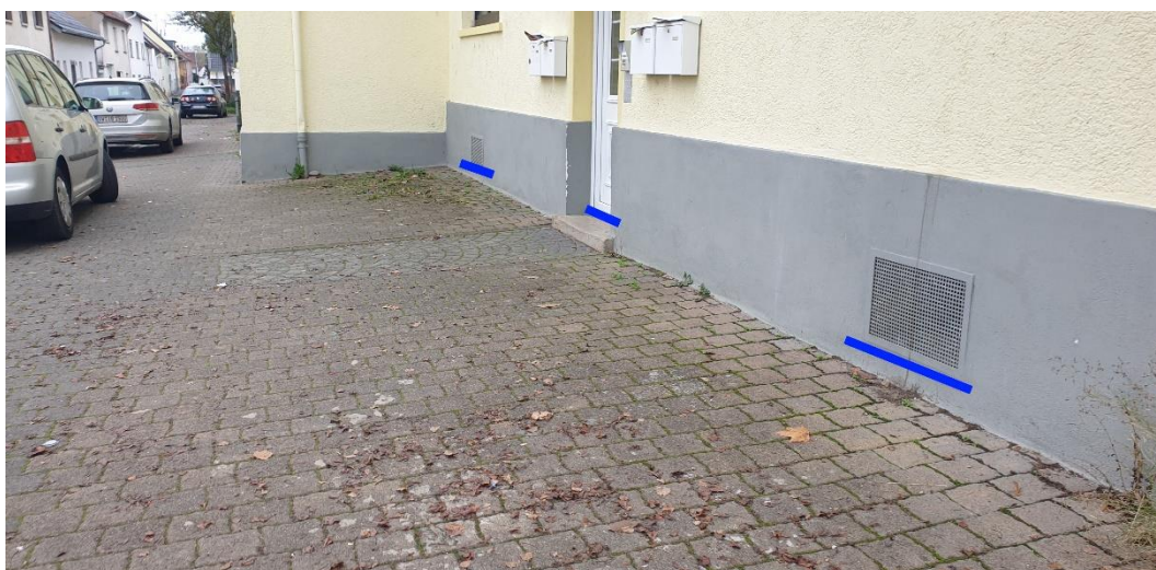
Abbildung 14: Notfließweg „Osterbergstraße“ mit Objektschutzmaßnahmen (blau) und Bordanlagen (gelb)
