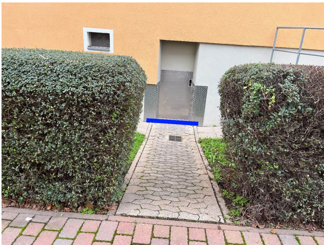
Abbildung 61: Notfließweg „Matthias-Erzberger-Straße“ mit Objektschutzmaßnahmen (blau)
