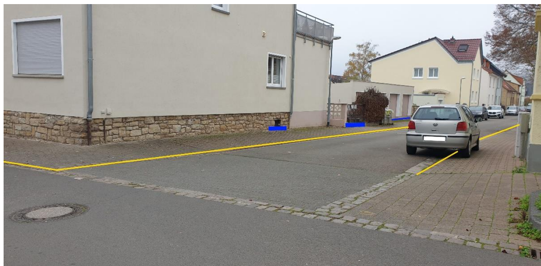
Abbildung 19: Notfließweg „Osterbergstraße“ mit Objektschutzmaßnahmen (blau) und Bordanlagen (gelb)
