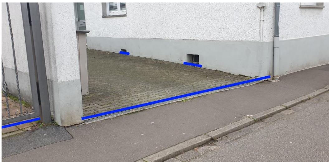
Abbildung 13: Notfließweg „Osterbergstraße“ mit Objektschutzmaßnahmen (blau) und Bordanlagen (gelb)
