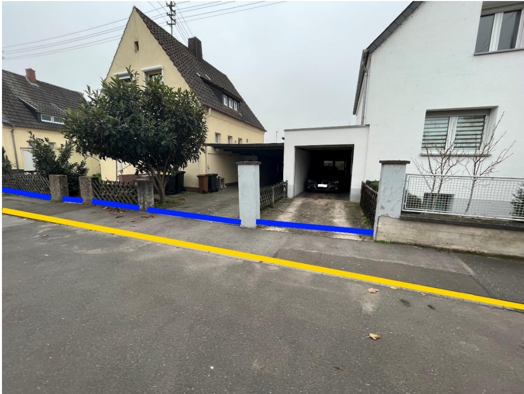
Abbildung 122: Notfließweg „Jakob-Ebermann-Straße“ mit Objektschutzmaßnahmen (blau) und Bordanlagen (gelb)
