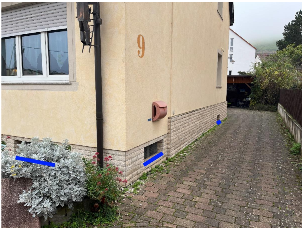
Abbildung 64: Notfließweg „Matthias-Erzberger-Straße“ mit Objektschutzmaßnahmen (blau)
