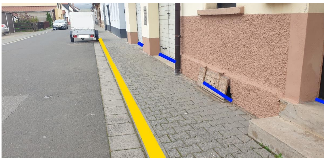
Abbildung 82: Notfließweg „Wilhelmstraße“ mit Objektschutzmaßnahmen (blau) und Bordanlagen (gelb)
