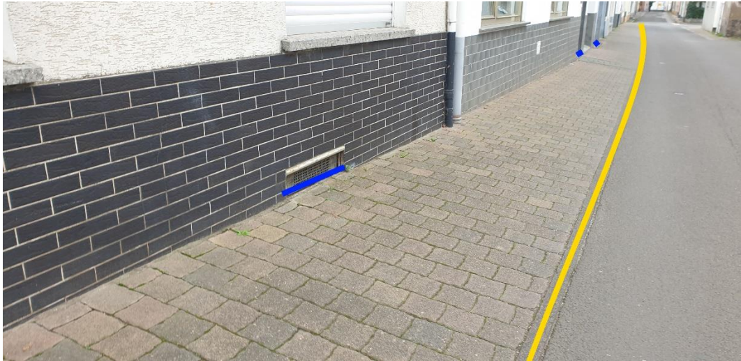
Abbildung 21: Notfließweg „Osterbergstraße“ mit Objektschutzmaßnahmen (blau) und Bordanlagen (gelb)
