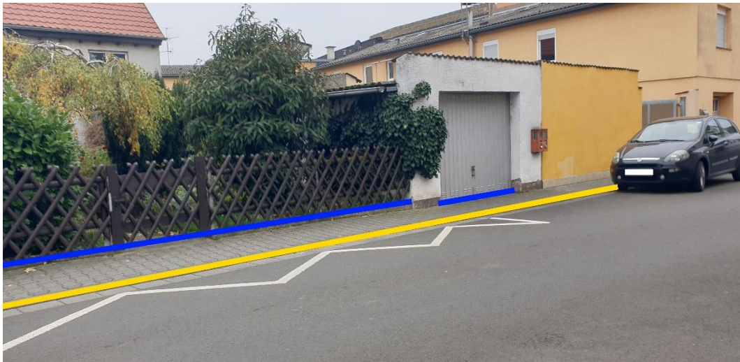
Abbildung 93: Nottfließweg „Wilhelmstraße“ mit Objektschutzmaßnahmen (blau) und Bordanlagen (gelb)
