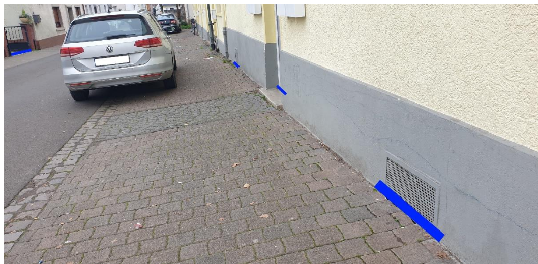
Abbildung 15: Notfließweg „Osterbergstraße“ mit Objektschutzmaßnahmen (blau) und Bordanlagen (gelb)
