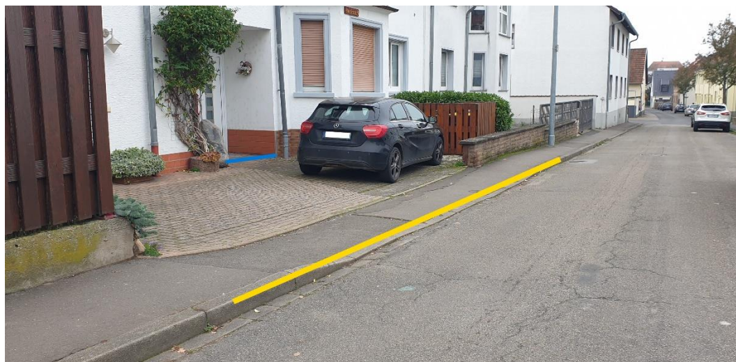
Abbildung 11: Notfließweg „Osterbergstraße“ mit Objektschutzmaßnahmen (blau) und Bordanlagen (gelb)
