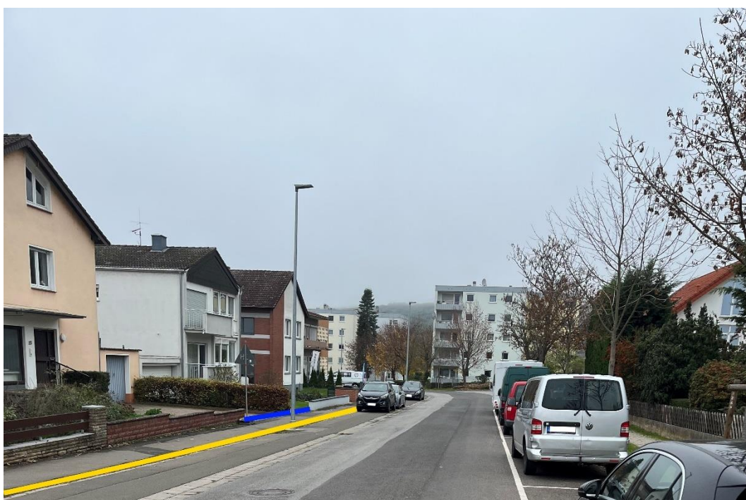
Abbildung 100: Notfließweg „Berlinstraße“ mit Objektschutzmaßnahmen (blau) und Bordanlagen (gelb)
