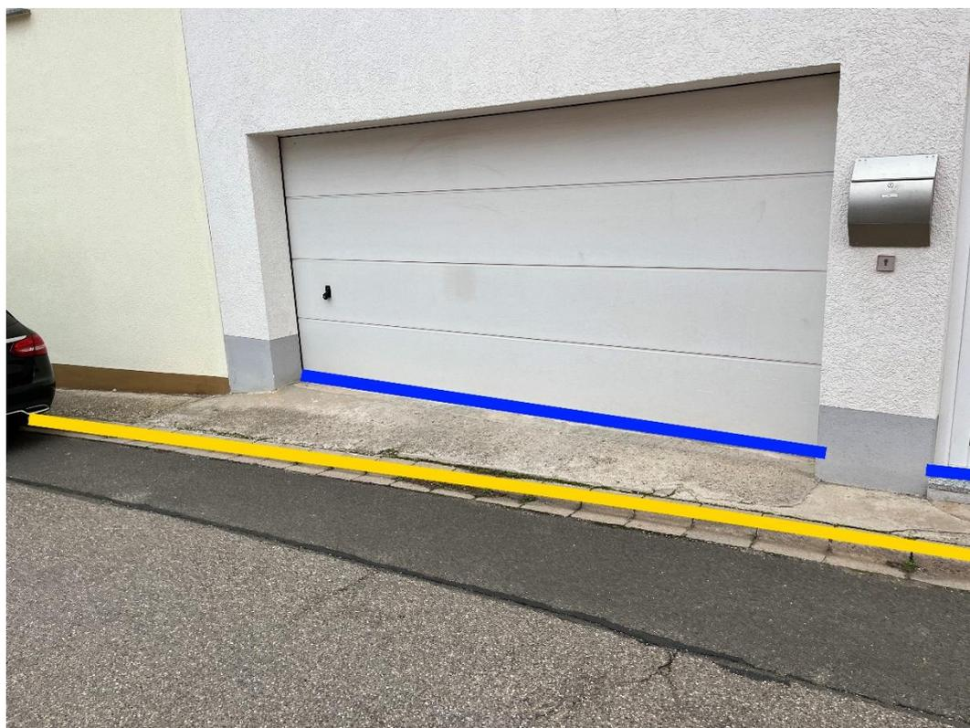
Abbildung 23: Notfließweg "Römerstraße" mit Objektschutzmaßnahme (blau) und Bordanlagen (gelb)
