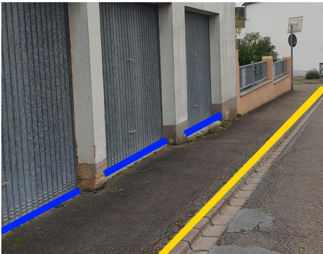
Abbildung 14: Notfließweg "Römerstraße" mit Objektschutzmaßnahme (blau) und Bordanlagen (gelb)
