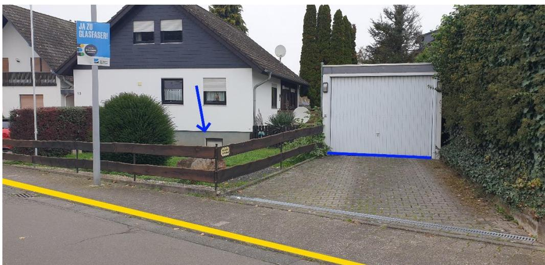
Abbildung 36: Notfließweg "Römerstraße" mit Objektschutzmaßnahme (blau) und Bordanlagen (gelb)
