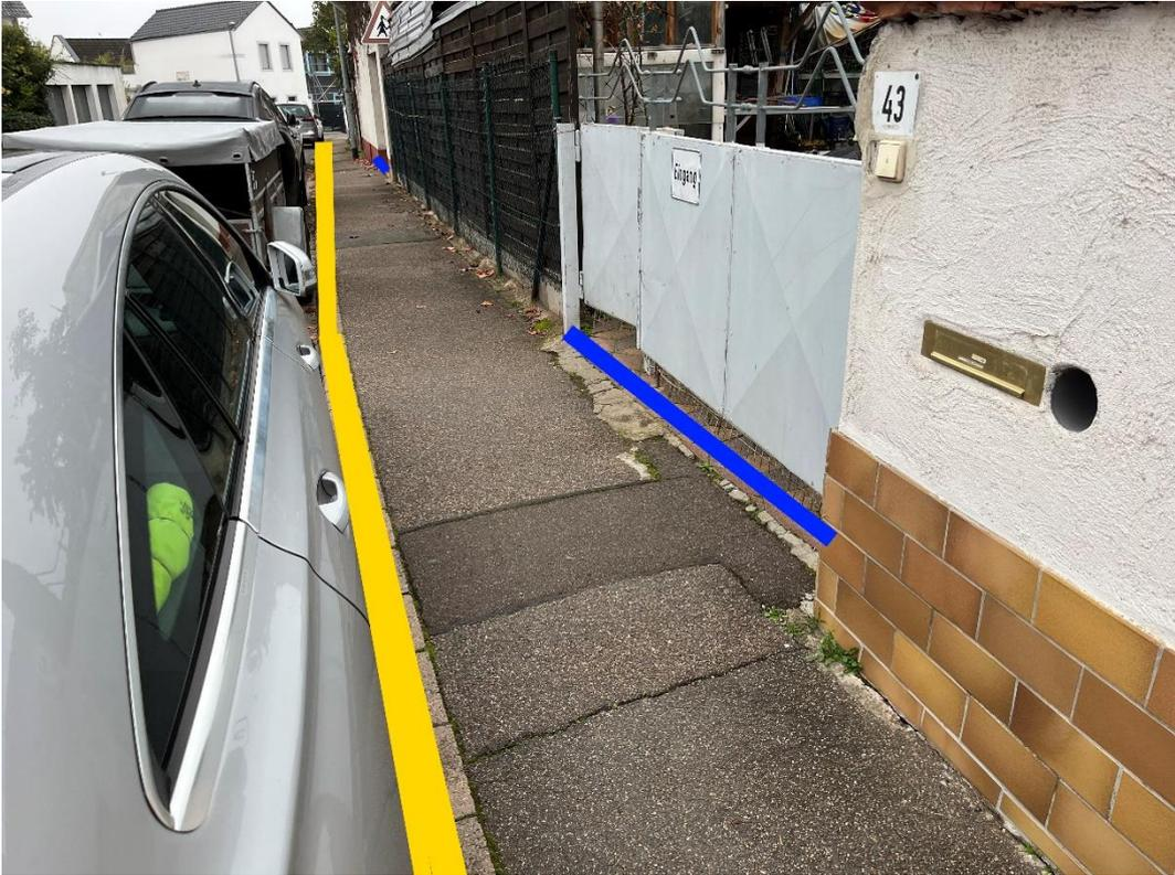
Abbildung 11: Notfließweg "Römerstraße" mit Objektschutzmaßnahme (blau) und Bordanlagen (gelb)
