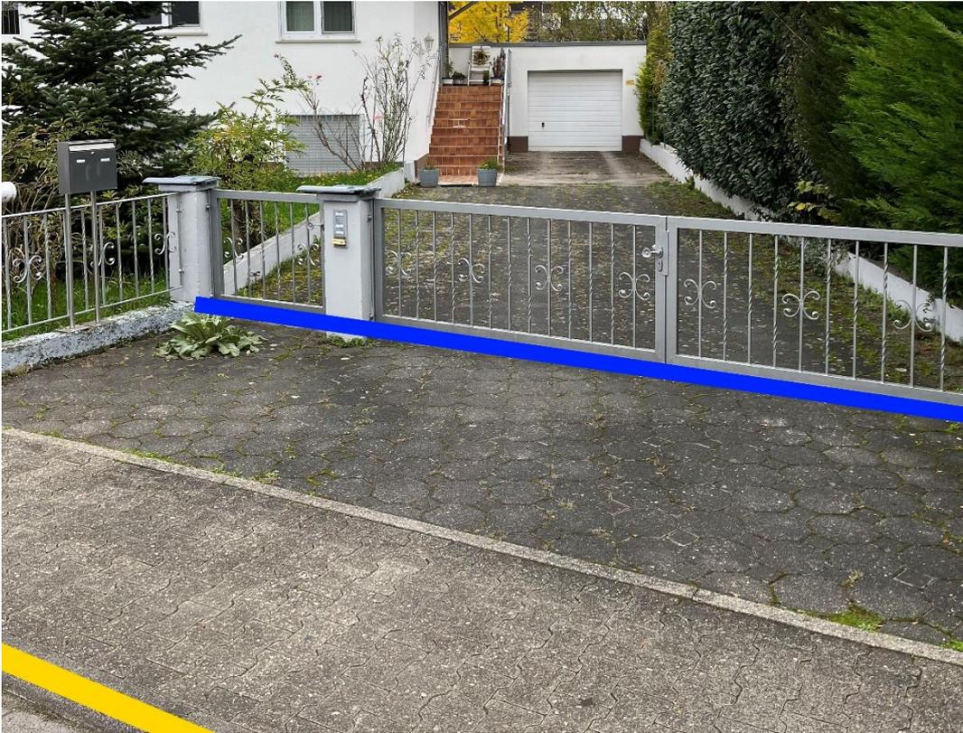
Abbildung 45: Notfließweg "Römerstraße" mit Objektschutzmaßnahme (blau) und Bordanlagen (gelb)
