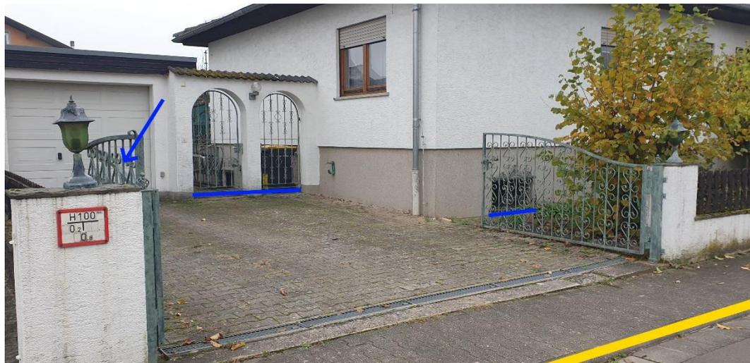
Abbildung 56: Notfließweg "Römerstraße" mit Objektschutzmaßnahme (blau) und Bordanlagen (gelb)
