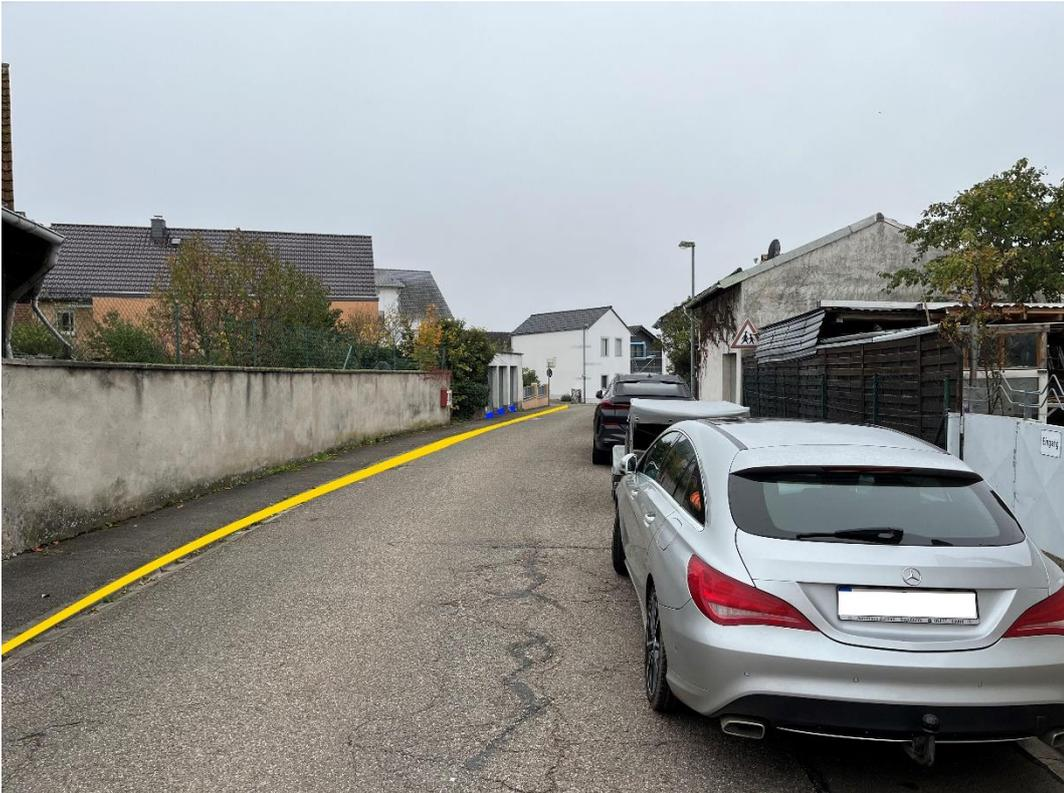
Abbildung 10: Notfließweg "Römerstraße" mit Objektschutzmaßnahme (blau) und Bordanlagen (gelb)
