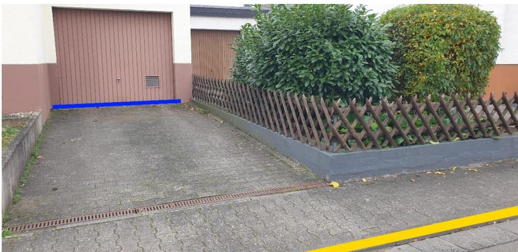
Abbildung 53: Notfließweg "Römerstraße" mit Objektschutzmaßnahme (blau) und Bordanlagen (gelb)
