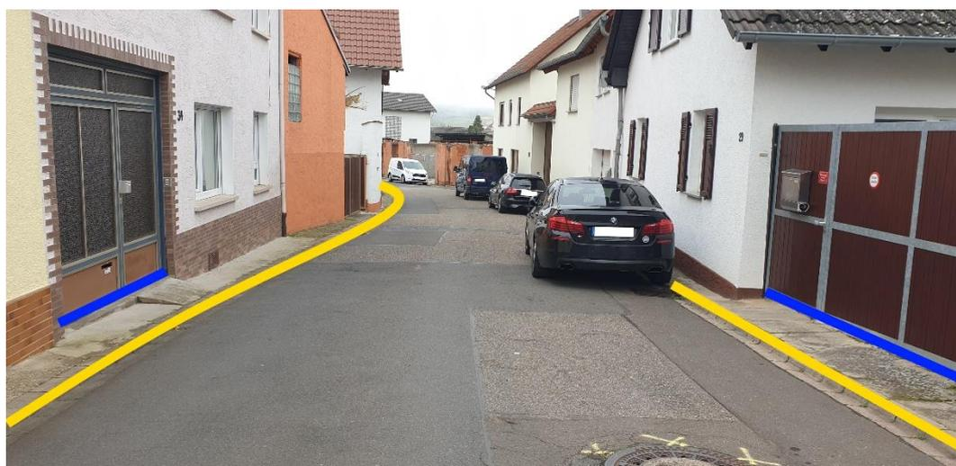
Abbildung 21: Notfließweg "Römerstraße" mit Objektschutzmaßnahme (blau) und Bordanlagen (gelb)
