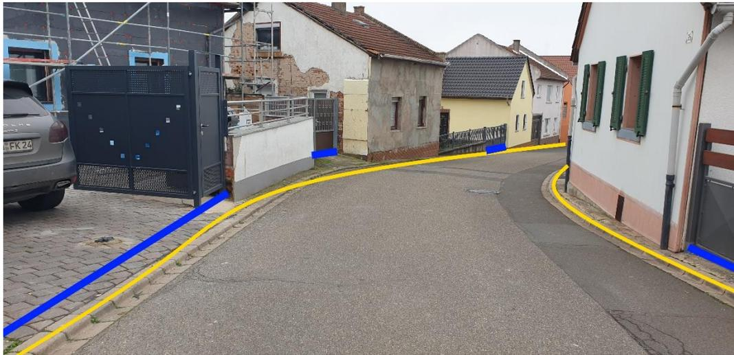
Abbildung 18: Notfließweg "Römerstraße" mit Objektschutzmaßnahme (blau) und Bordanlagen (gelb)
