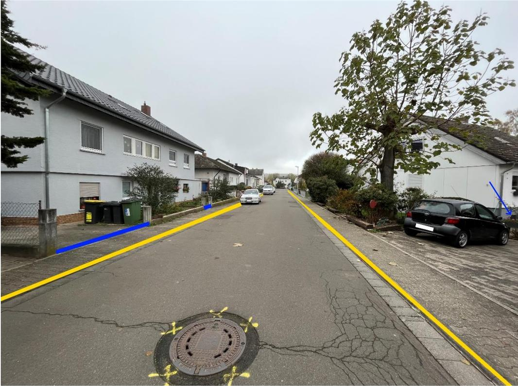
Abbildung 40: Notfließweg "Römerstraße" mit Objektschutzmaßnahme (blau) und Bordanlagen (gelb)
