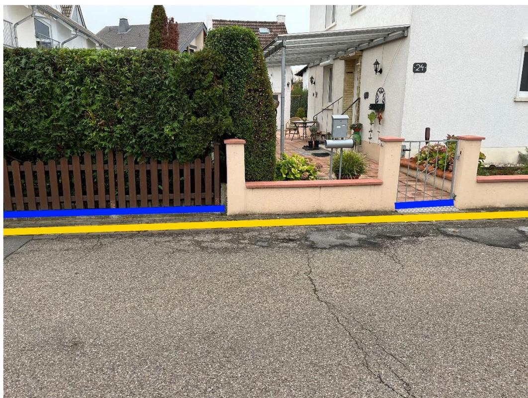
Abbildung 32: Notfließweg "Römerstraße" mit Objektschutzmaßnahme (blau) und Bordanlagen (gelb)
