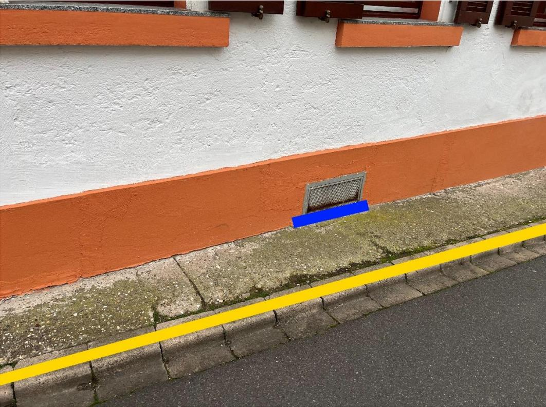
Abbildung 25: Notfließweg "Römerstraße" mit Objektschutzmaßnahme (blau) und Bordanlagen (gelb)
