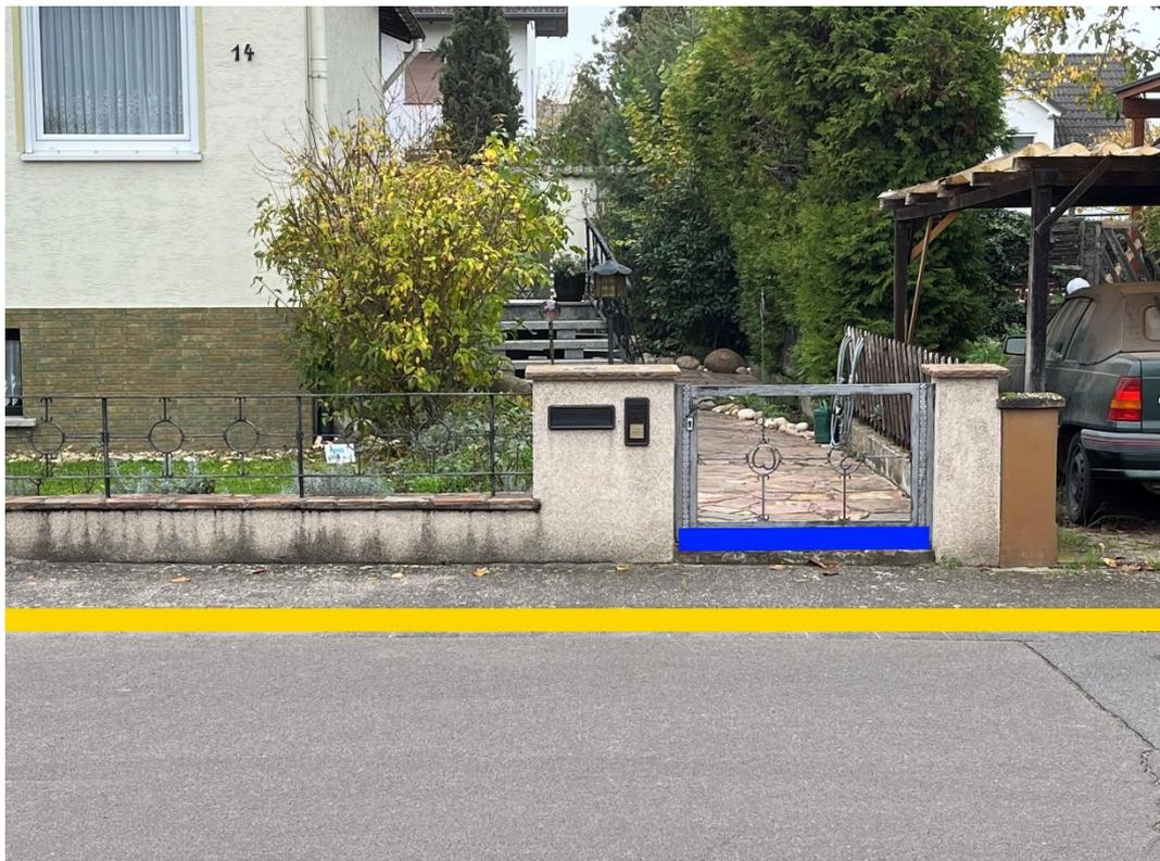
Abbildung 59: Notfließweg "Römerstraße" mit Objektschutzmaßnahme (blau) und Bordanlagen (gelb)
