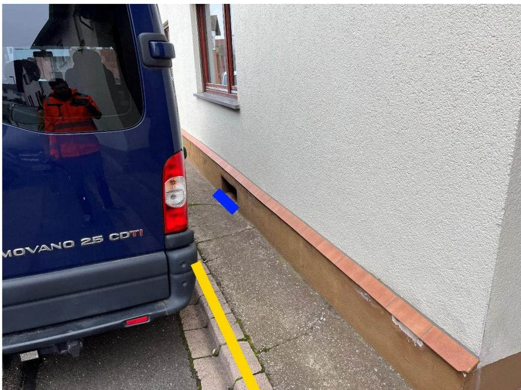
Abbildung 27: Notfließweg "Römerstraße" mit Objektschutzmaßnahme (blau) und Bordanlagen (gelb)
