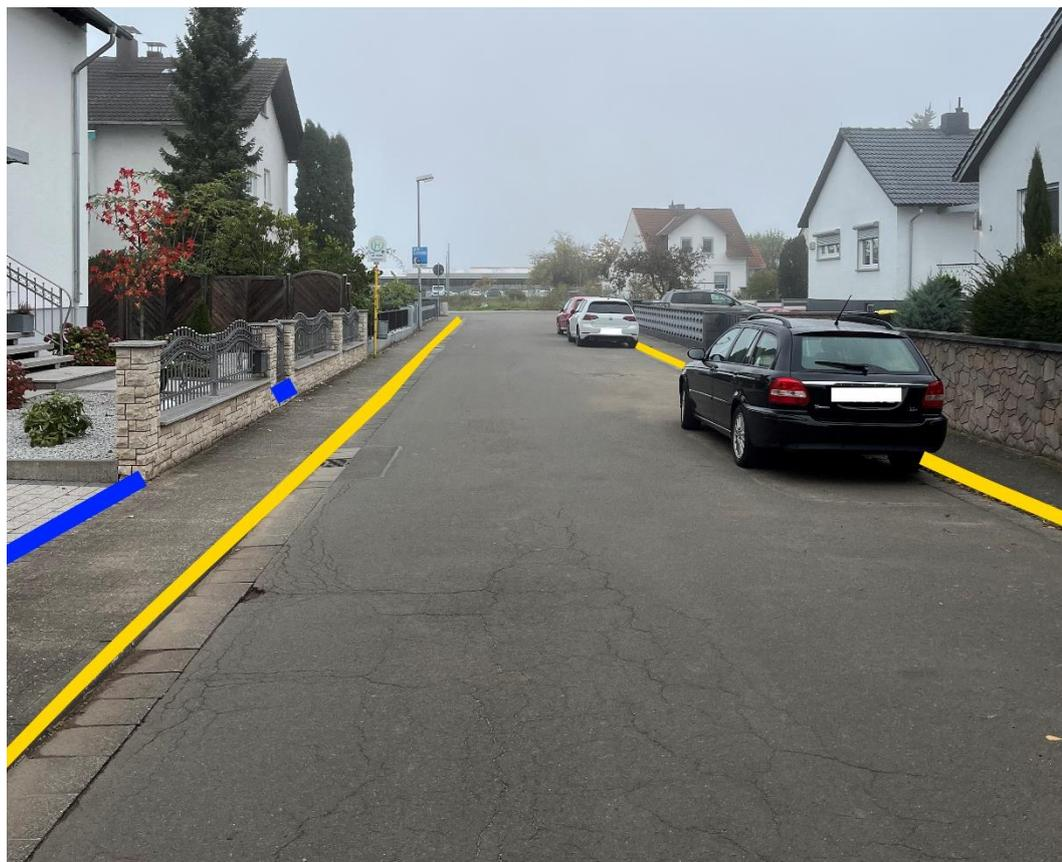
Abbildung 68: Notfließweg "Römerstraße" mit Objektschutzmaßnahme (blau) und Bordanlagen (gelb)
