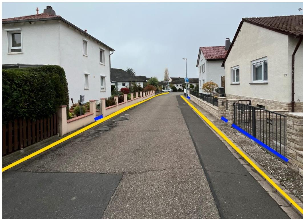
Abbildung 31: Notfließweg "Römerstraße" mit Objektschutzmaßnahme (blau) und Bordanlagen (gelb)
