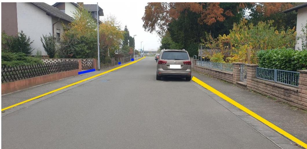
Abbildung 61: Notfließweg "Römerstraße" mit Objektschutzmaßnahme (blau) und Bordanlagen (gelb)
