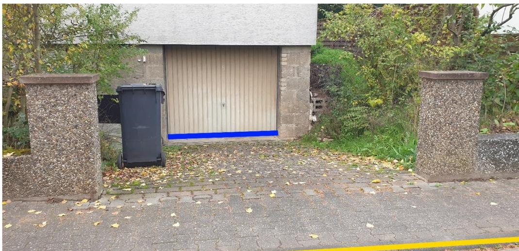
Abbildung 67: Notfließweg "Römerstraße" mit Objektschutzmaßnahme (blau) und Bordanlagen (gelb)
