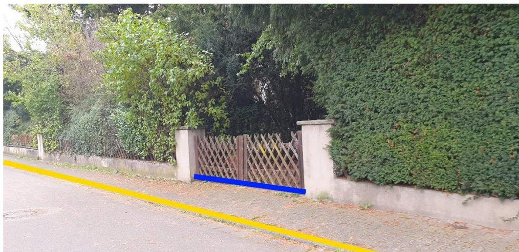
Abbildung 65: Notfließweg "Römerstraße" mit Objektschutzmaßnahme (blau) und Bordanlagen (gelb)
