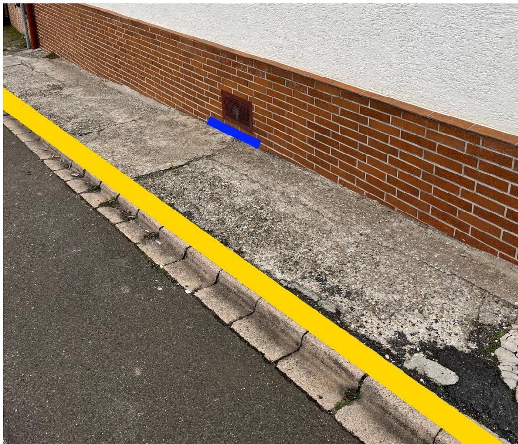
Abbildung 20: Notfließweg "Römerstraße" mit Objektschutzmaßnahme (blau) und Bordanlagen (gelb)
