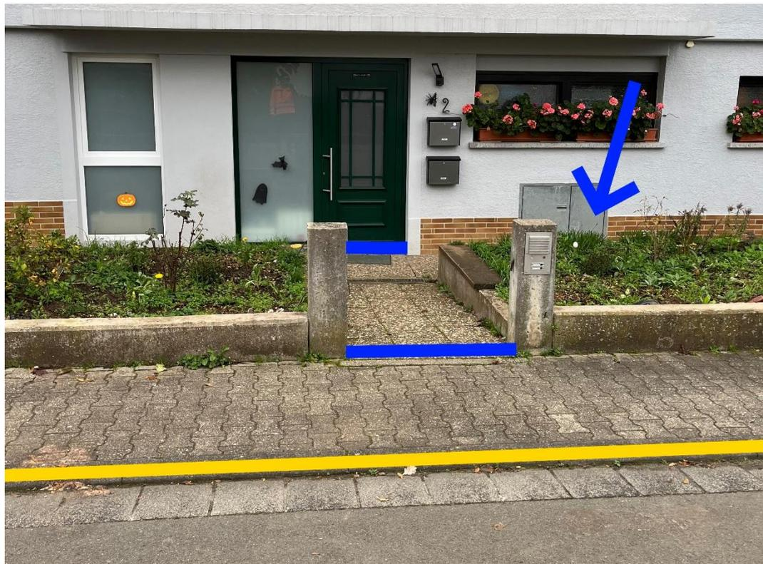
Abbildung 43: Notfließweg "Römerstraße" mit Objektschutzmaßnahme (blau) und Bordanlagen (gelb)
