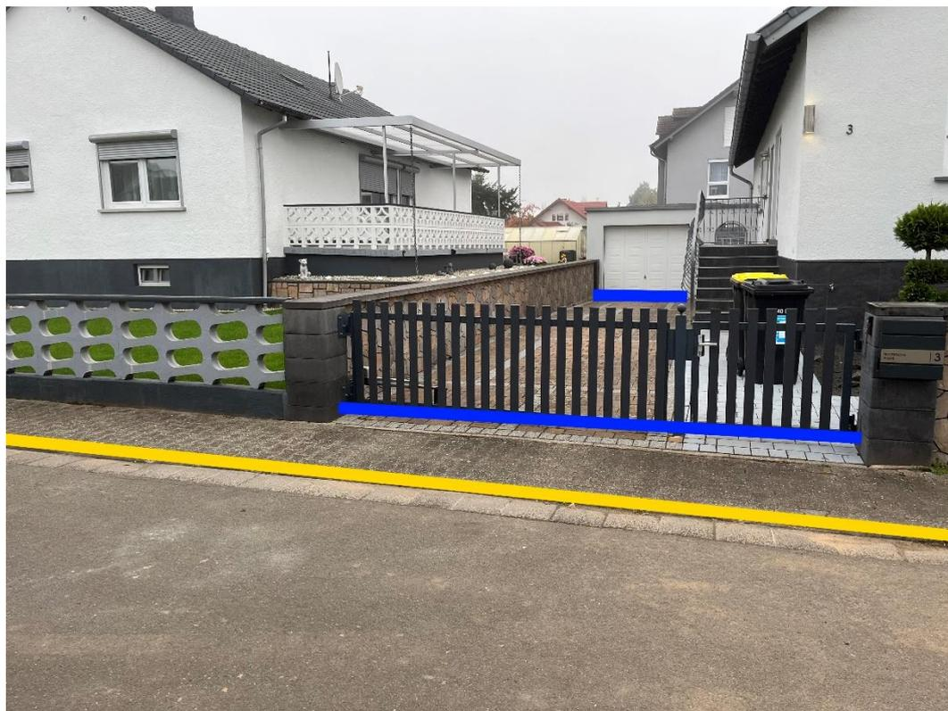
Abbildung 71: Notfließweg "Römerstraße" mit Objektschutzmaßnahme (blau) und Bordanlagen (gelb)
