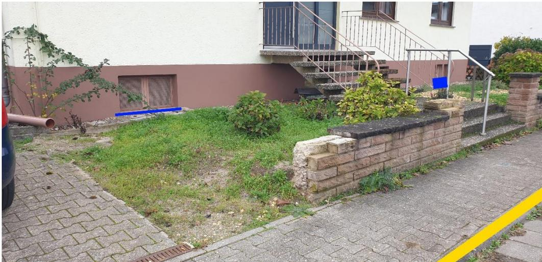
Abbildung 51: Notfließweg "Römerstraße" mit Objektschutzmaßnahme (blau) und Bordanlagen (gelb)
