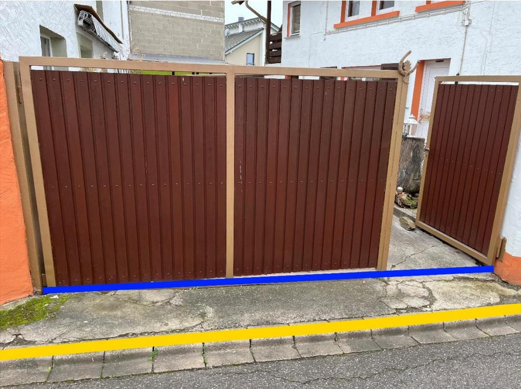
Abbildung 24: Notfließweg "Römerstraße" mit Objektschutzmaßnahme (blau) und Bordanlagen (gelb)
