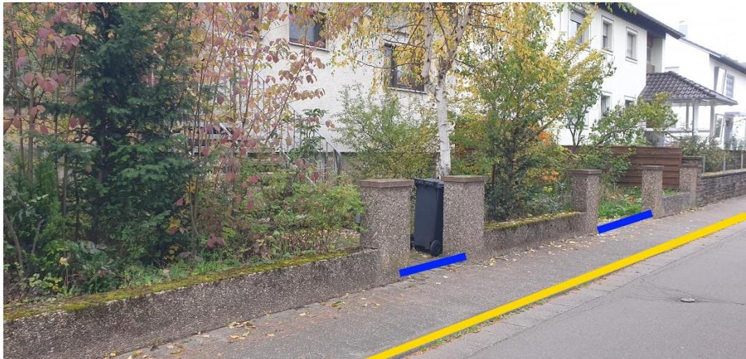
Abbildung 66: Notfließweg "Römerstraße" mit Objektschutzmaßnahme (blau) und Bordanlagen (gelb)
