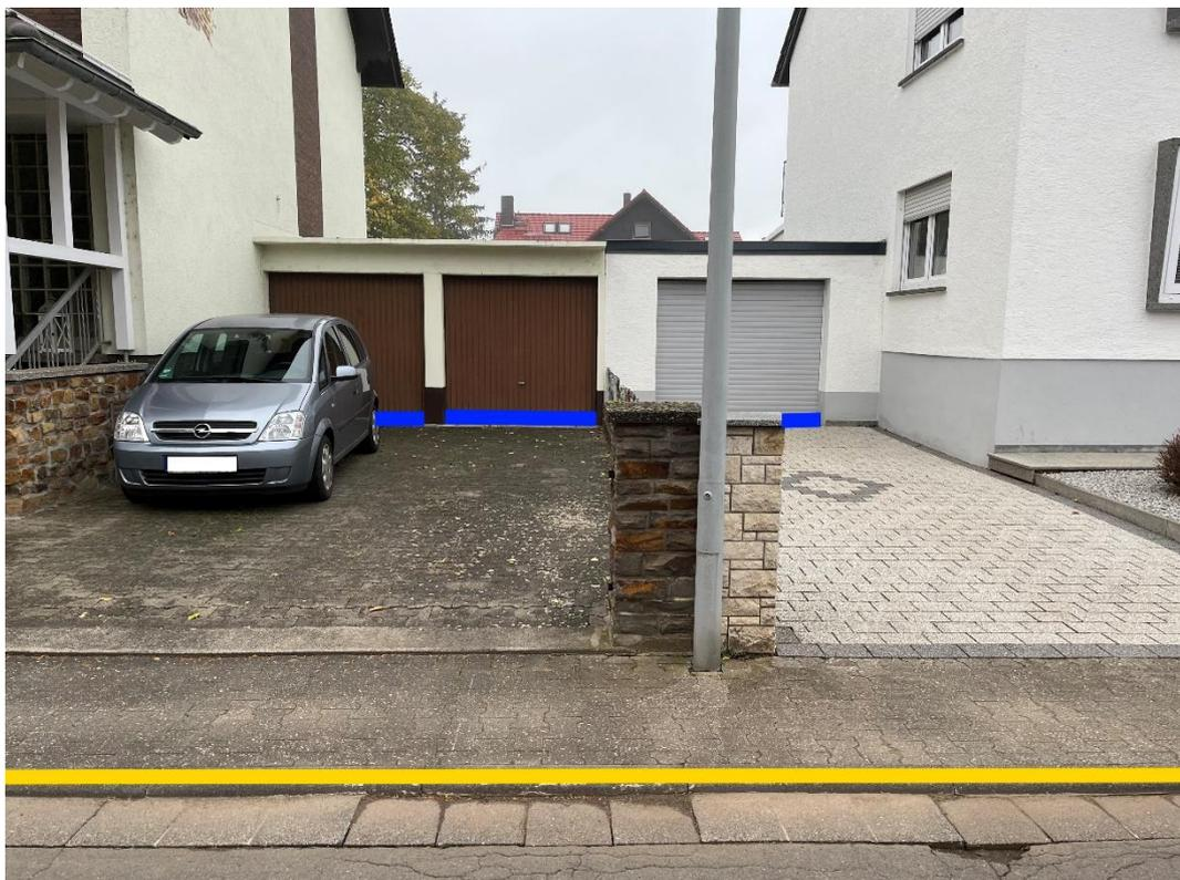
Abbildung 70: Notfließweg "Römerstraße" mit Objektschutzmaßnahme (blau) und Bordanlagen (gelb)
