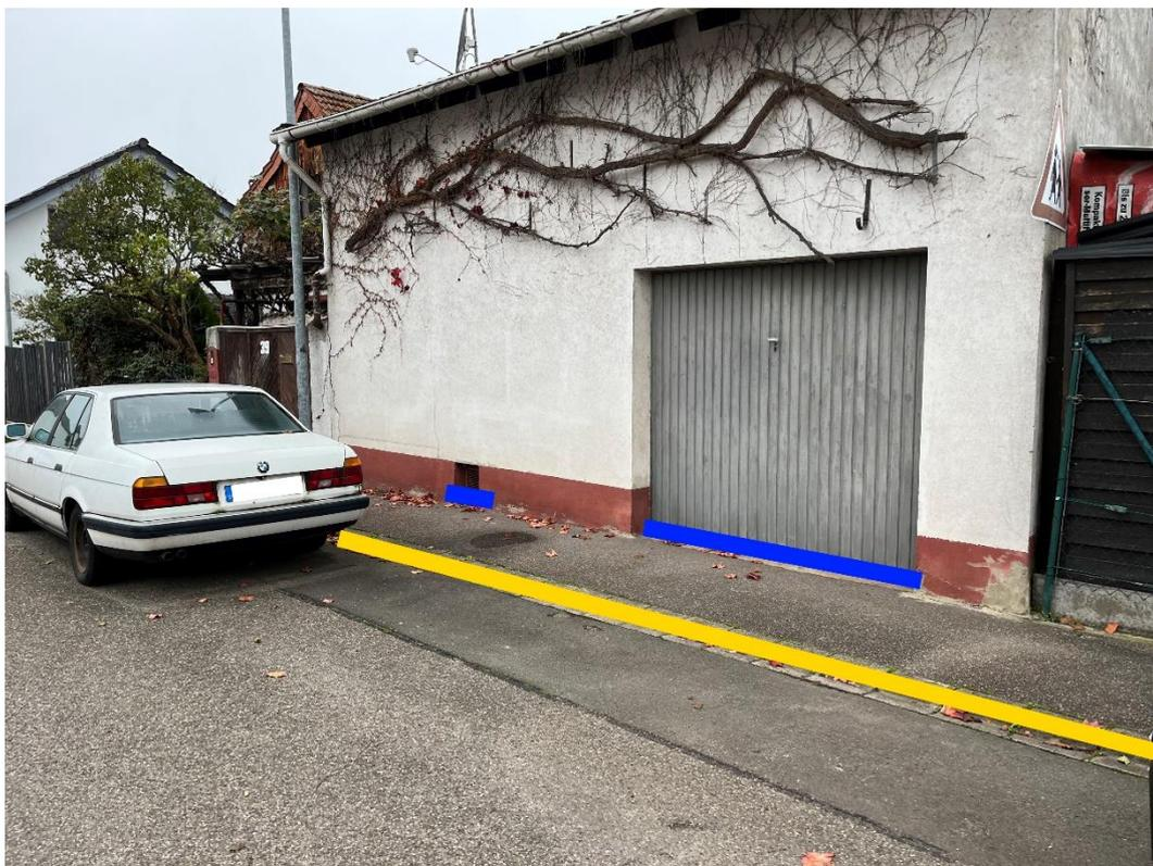
Abbildung 12: Notfließweg "Römerstraße" mit Objektschutzmaßnahme (blau) und Bordanlagen (gelb)
