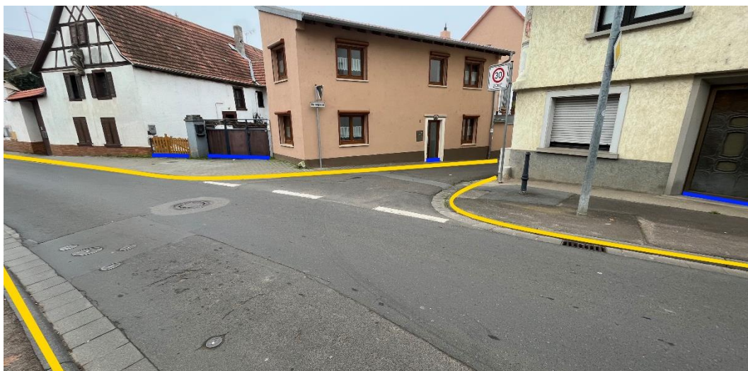
Abbildung 21: Notfließweg "Rhein Hessenstraße" mit Objektschutzmaßnahmen (blau) und Bordanlage (gelb)
