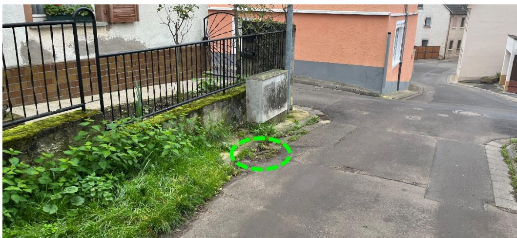
Abbildung 8: Notfließweg "Dalbusgasse" mit Verbesserung der Abflussanlagen (grün)
