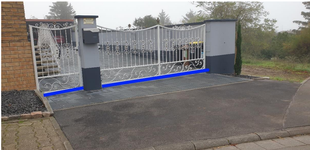
Abbildung 69: Notfließweg "Untergasse" mit Objektschutzmaßnahmen (blau)
