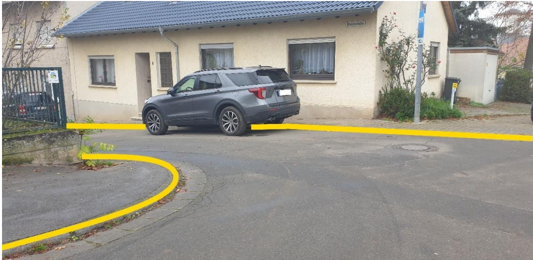
Abbildung 74: Notfließweg "Untergasse" mit Bordanlage (gelb)
