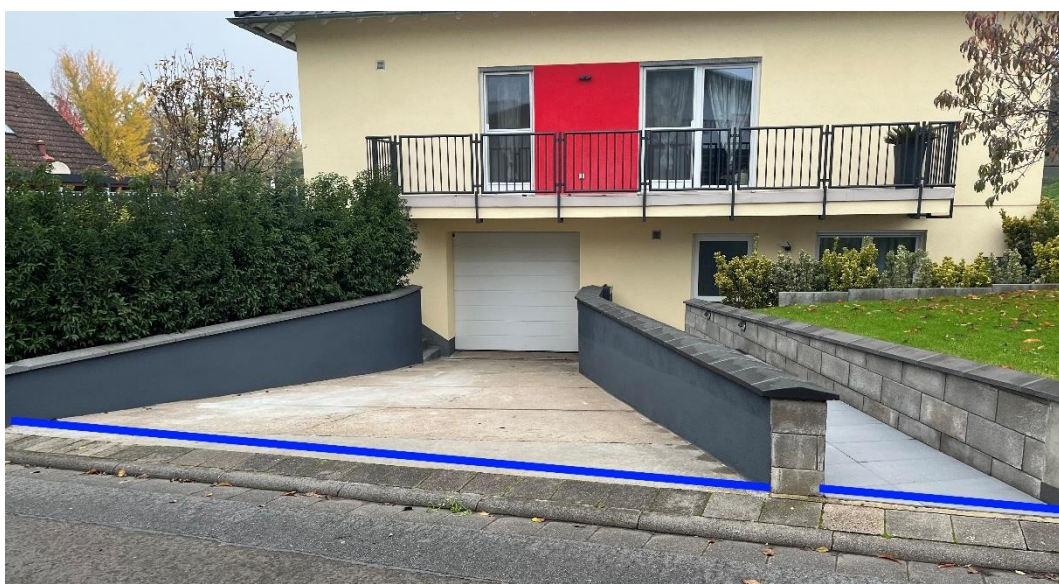
Abbildung 47: Nottließweg "Marienstraße" mit Objektschutzmaßnahmen (blau)
