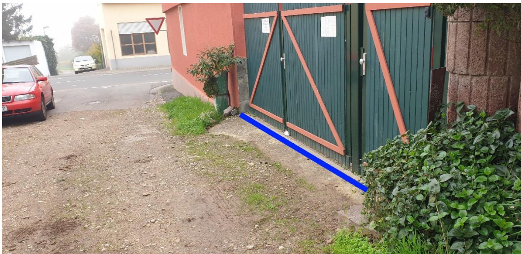
Abbildung 84: Notfließweg "Im Stauch" mit Objektschutzmaßnahmen (blau)
