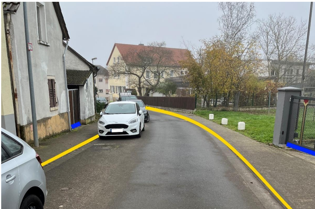
Abbildung 101: Nottfließweg „Klosterweg“ mit Objektschutzmaßnahmen (blau) und Bordanlagen (gelb)
