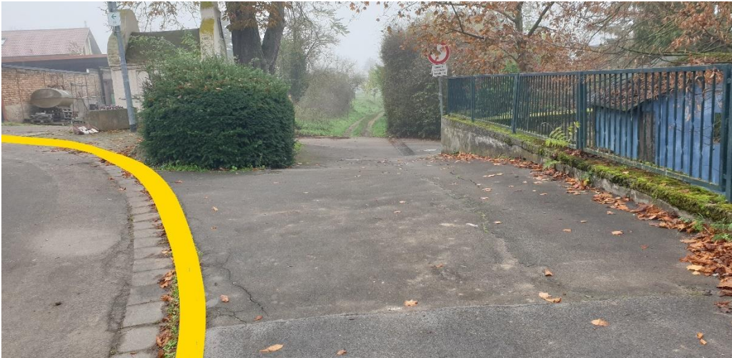
Abbildung 71: Nottfließweg "Untergasse" mit Bordanlage (gelb)
