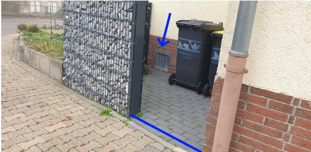
Abbildung 68: Notfließweg "Untergasse" mit Objektschutzmaßnahmen (blau)
