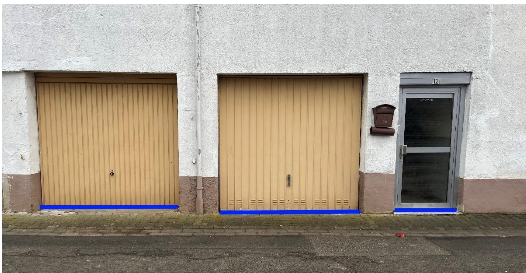
Abbildung 36: Notfließweg "Dietengasse" mit Objektschutzmaßnahmen (blau)
