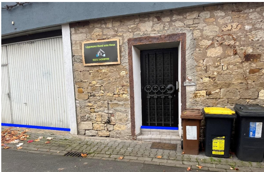
Abbildung 27: Notfließweg "Dietengasse" mit Objektschutzmaßnahmen (blau)
