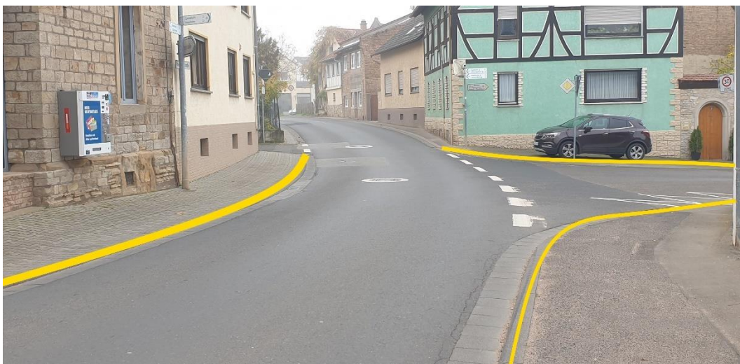
Abbildung 64: Notfließweg "Untergasse" mit Bordanlage (gelb)
