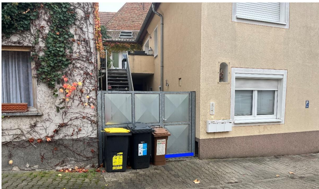
Abbildung 30: Notfließweg "Dietengasse" mit Objektschutzmaßnahmen (blau)
