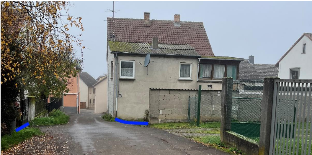
Abbildung 5: Notfließweg "Dalbusgasse" mit Objektschutzmaßnahmen (blau)
