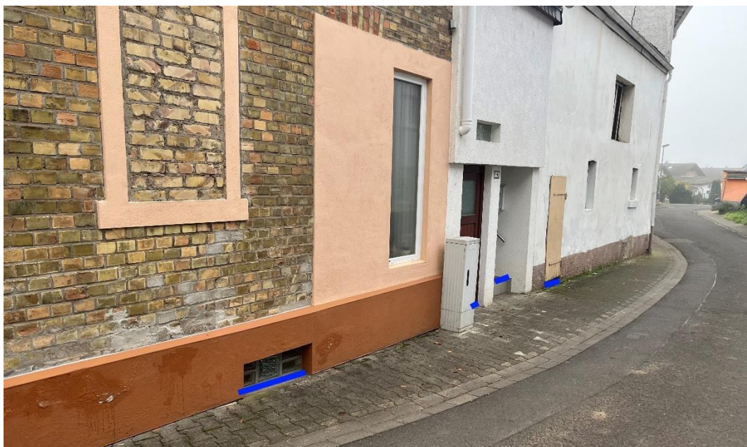
Abbildung 33: Notfließweg "Dietengasse" mit Objektschutzmaßnahmen (blau)
