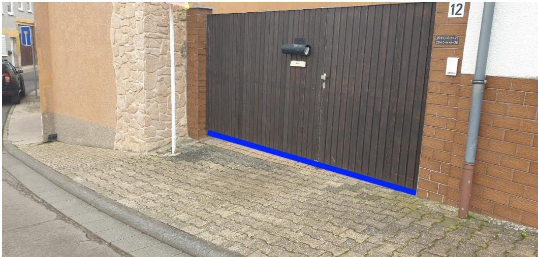
Abbildung 80: Nottfließweg "Untergasse" mit Objektschutzmaßnahmen (blau)
