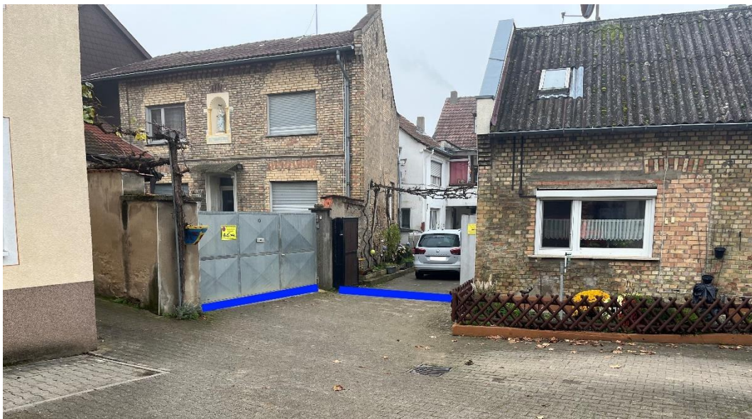
Abbildung 31: Notfließweg "Dietengasse" mit Objektschutzmaßnahmen (blau)
