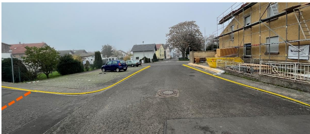
Abbildung 39: Notfließweg "Dietengasse" mit Aufwallung (orange) und Bordanlage (gelb)
