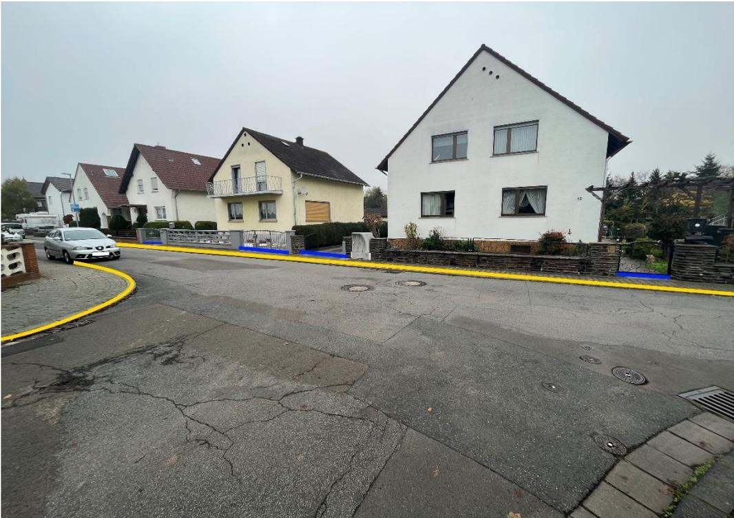
Abbildung 73: Notfließweg "Kasparstraße" mit Objektschutzmaßnahmen (blau) und Bordanlagen (gelb)
