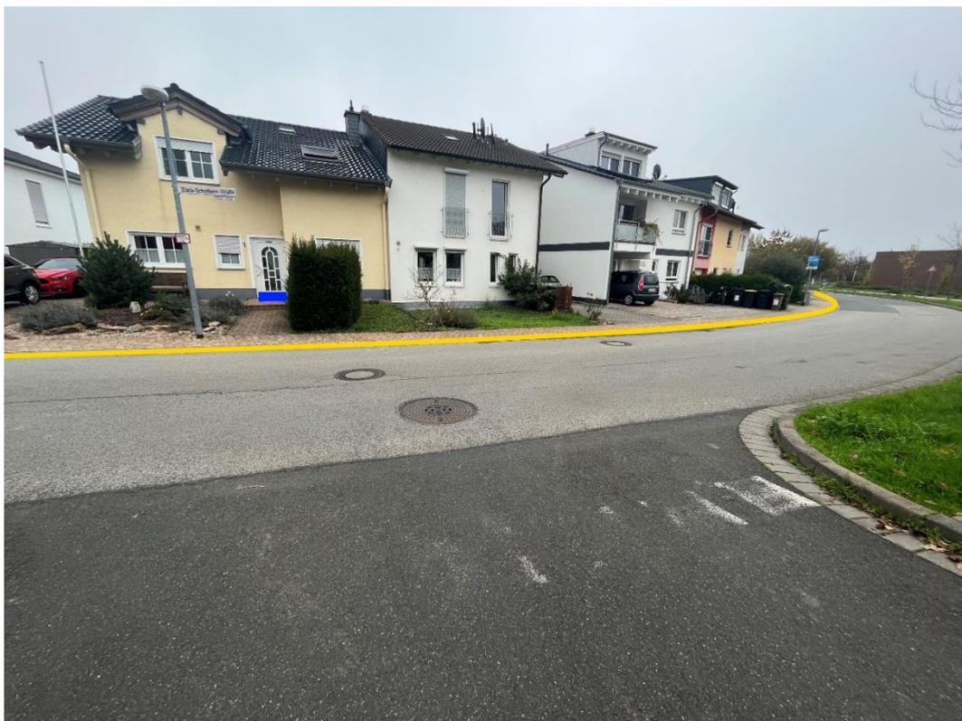
Abbildung 34: Notfließweg "Clara-Schuhmann-Straße" mit Objektschutzmaßnahmen (blau) und Bordanlage (gelb)
