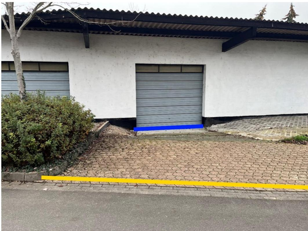
Abbildung 49: Notfließweg "Ida-Dehmel-Coblenz-Straße" mit Objektschutzmaßnahmen (blau) und Bordanlagen (gelb)
