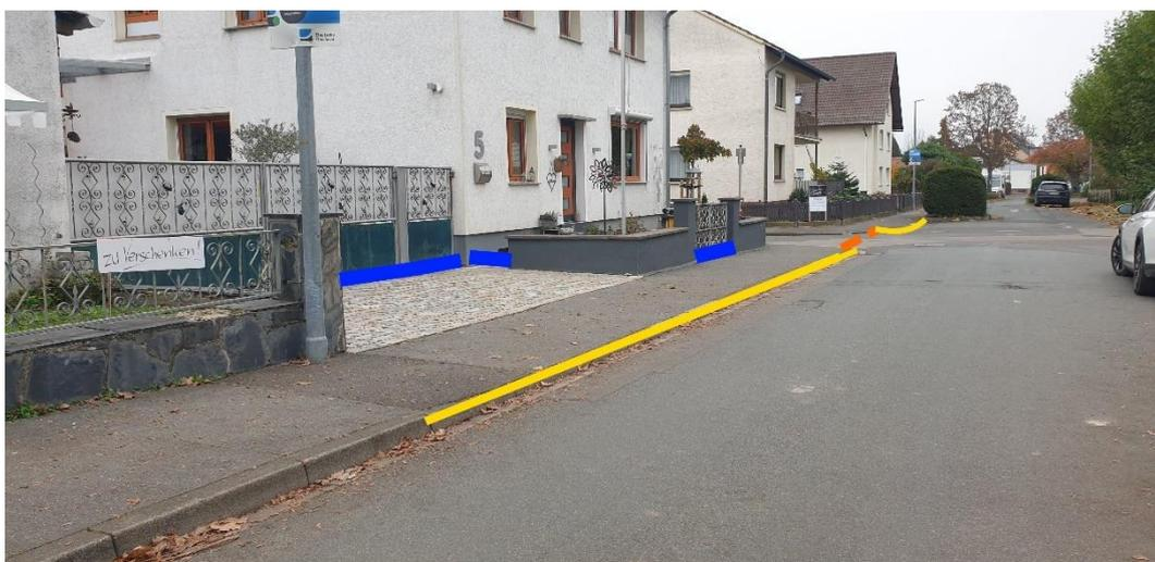
Abbildung 25: Notfließweg "Gaulsheimer Weg" mit Objektschutzmaßnahmen (blau), Aufwallung (orange) und Bordanlage (gelb)
