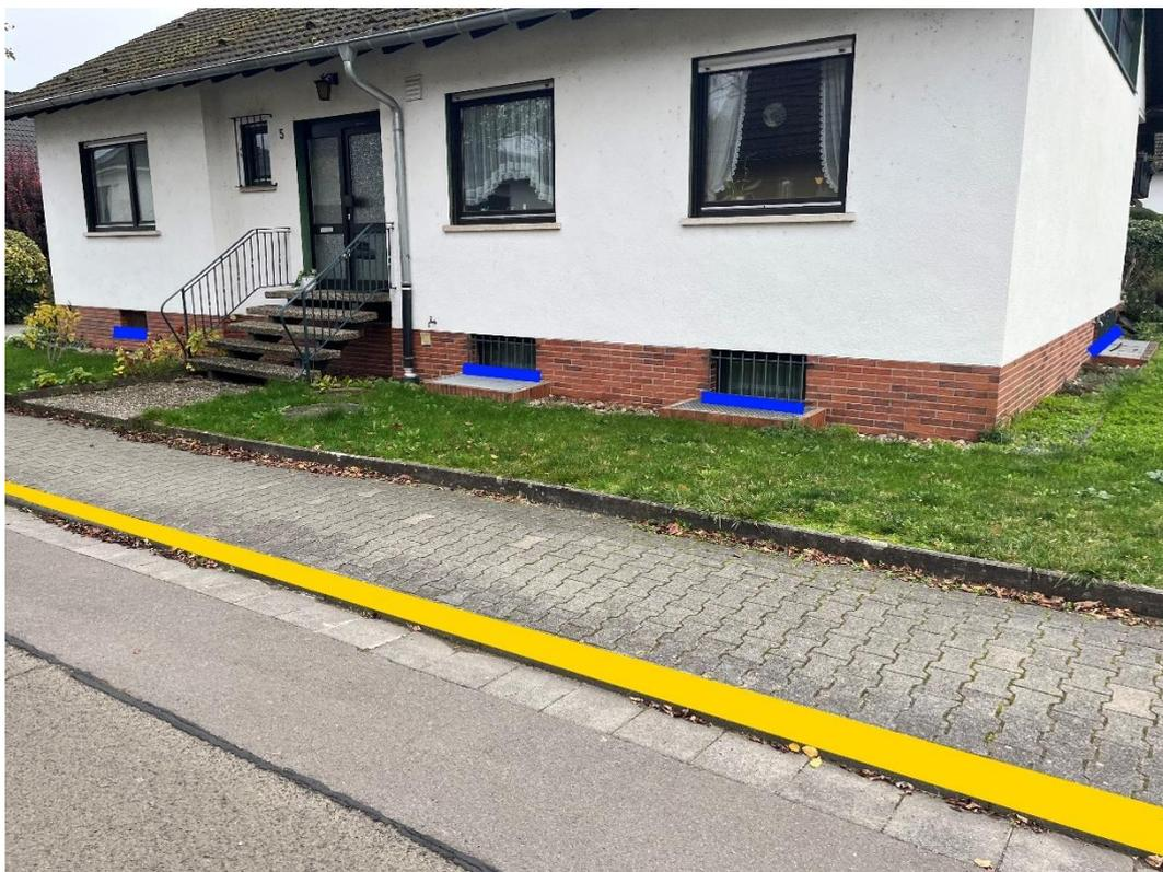
Abbildung 62: Notfließweg "Balthasarstraße" mit Objektschutzmaßnahmen (blau) und Bordanlagen (gelb)
