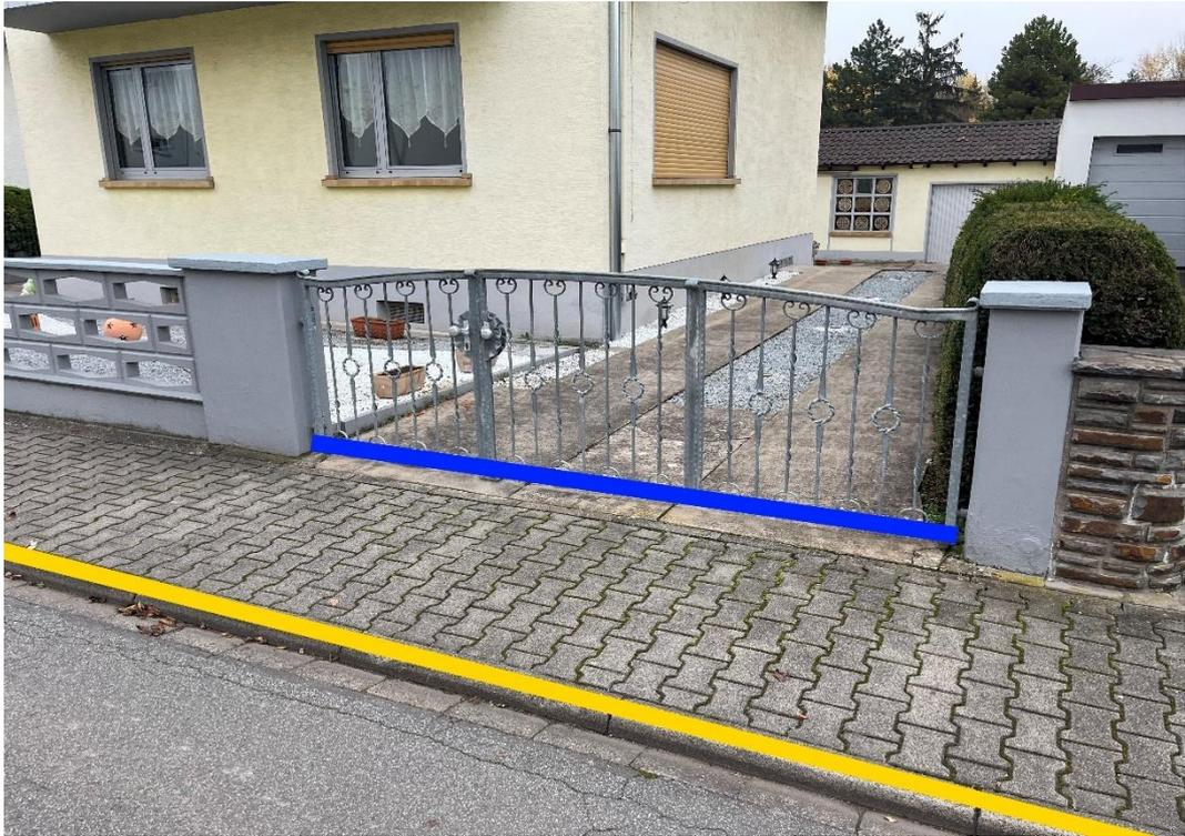
Abbildung 74: Notfließweg "Kasparstraße" mit Objektschutzmaßnahmen (blau) und Bordanlagen (gelb)
