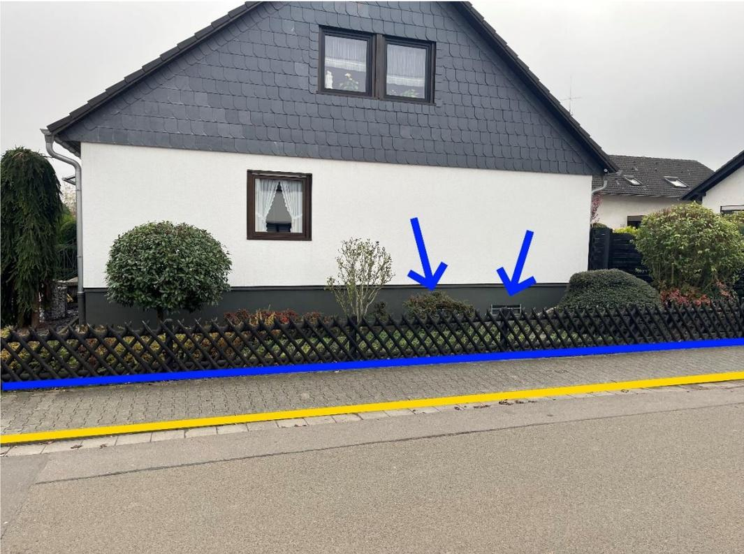
Abbildung 67: Notfließweg "Balthasarstraße" mit Objektschutzmaßnahmen (blau) und Bordanlagen (gelb)
