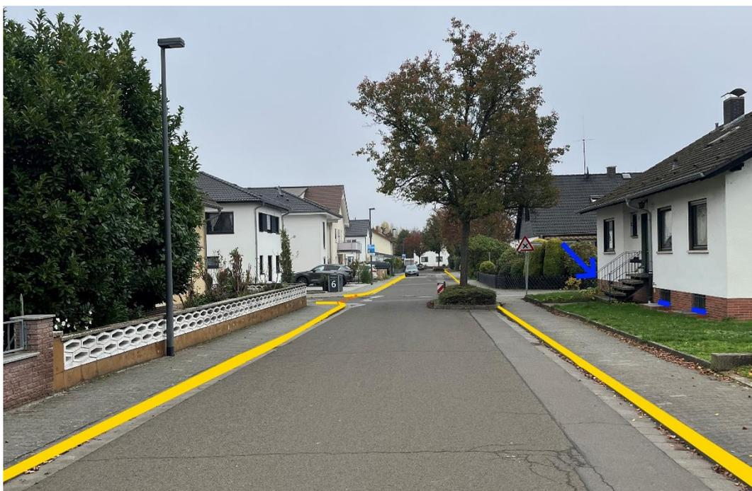
Abbildung 61: Notfließweg "Balthasarstraße" mit Objektschutzmaßnahmen (blau) und Bordanlagen (gelb)
