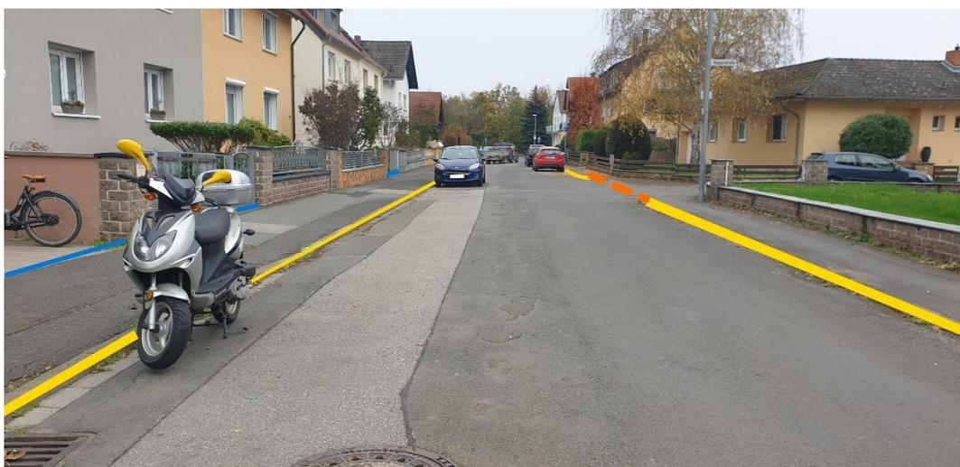
Abbildung 17: Nottfließweg "Gaulsheimer Weg" mit Objektschutzmaßnahmen (blau), Aufwallung (orange) und Bordanlage (gelb)
