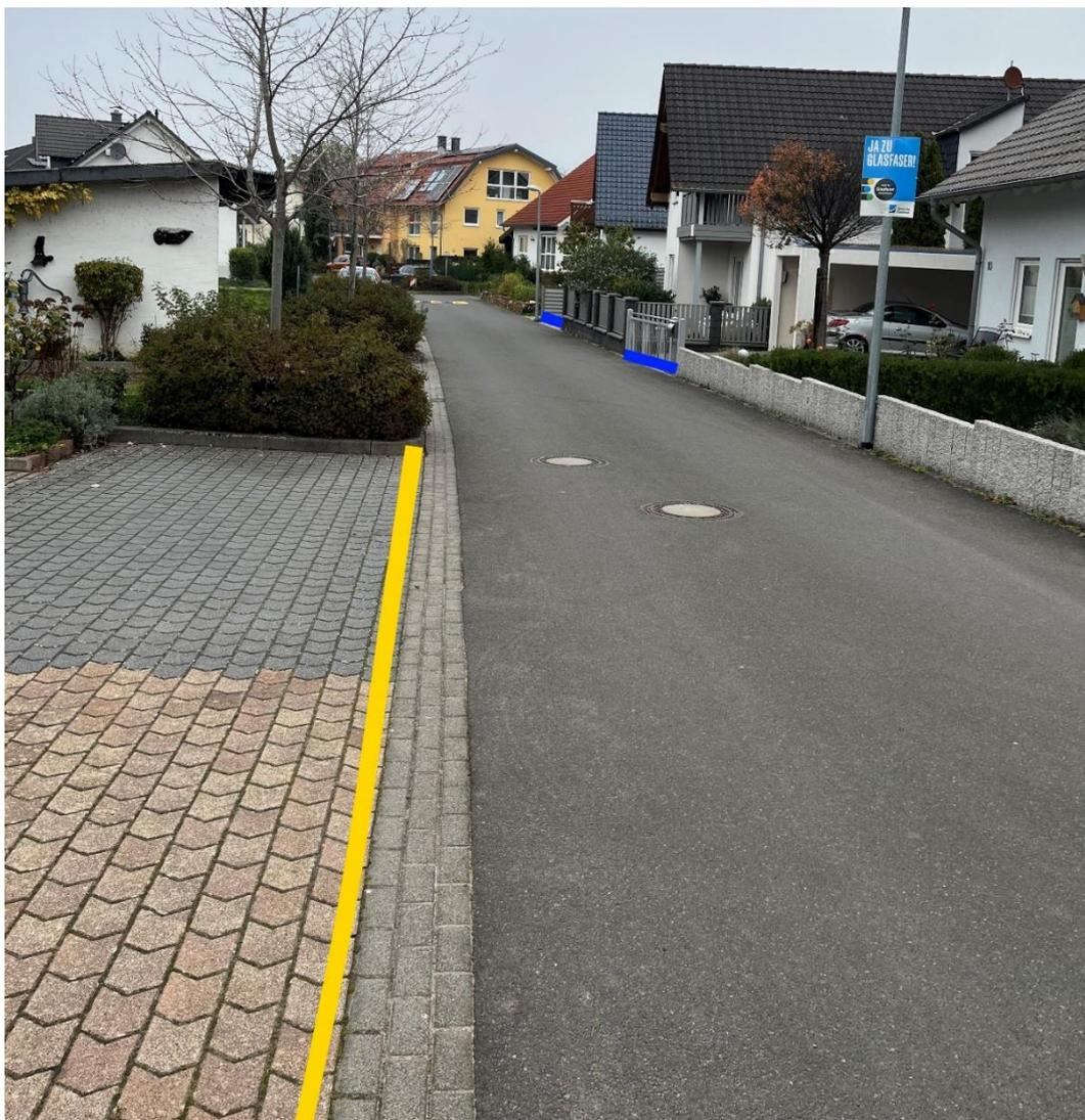
Abbildung 48: Notfließweg "Ida-Dehmel-Coblenz-Straße" mit Objektschutzmaßnahmen (blau) und Bordanlagen (gelb)
