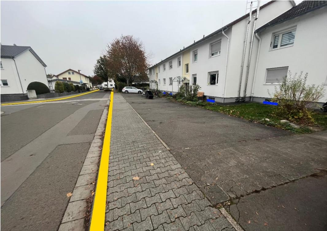
Abbildung 70: Notfließweg "Balthasarstraße" mit Objektschutzmaßnahmen (blau) und Bordanlagen (gelb)
