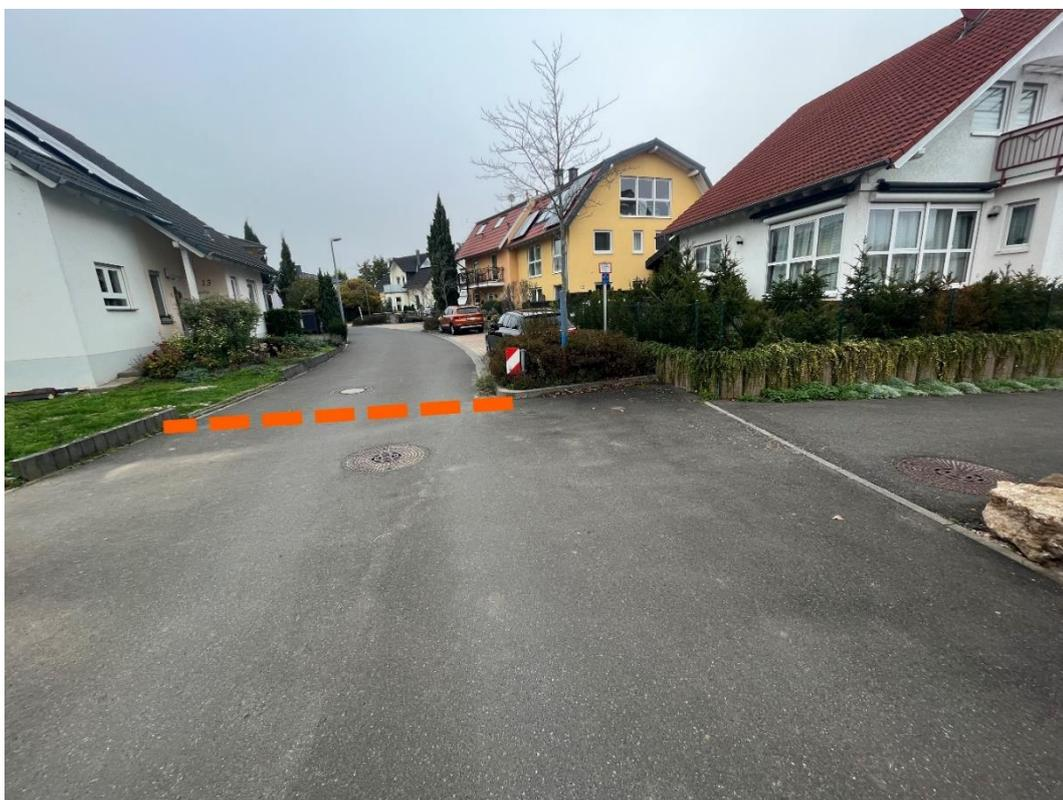
Abbildung 50: Notfließweg "Ida-Dehmel-Coblenz-Straße" mit Aufwallung (orange)
