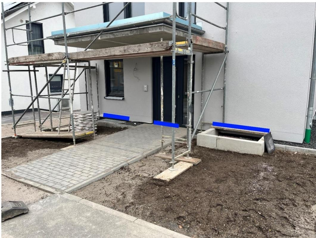
Abbildung 46: Notfließweg "Ida-Dehmel-Coblenz-Straße" mit Objektschutzmaßnahmen (blau)
