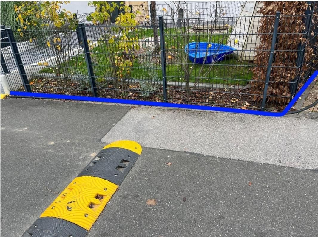
Abbildung 45: Notfließweg "Ida-Dehmel-Coblenz-Straße" mit Objektschutzmaßnahmen (blau) und Bordanlagen (gelb)
