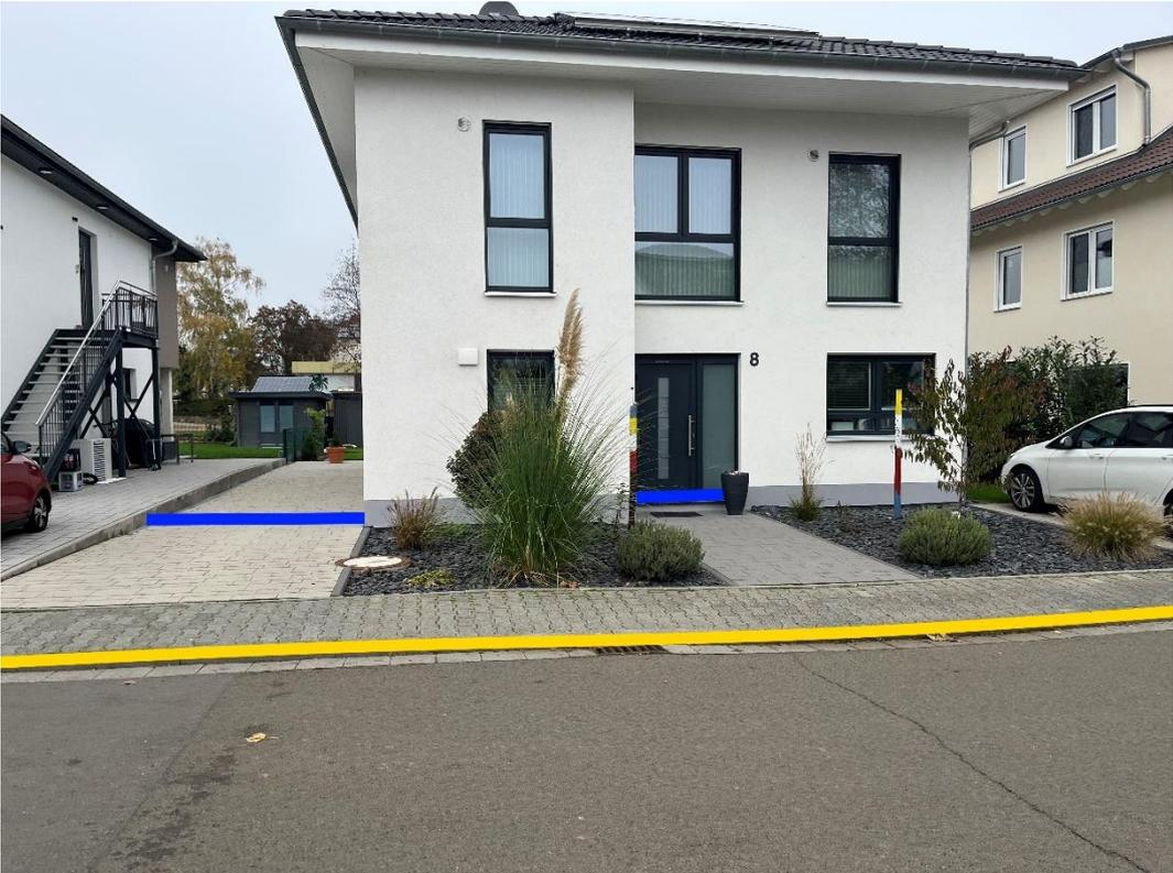
Abbildung 66: Notfließweg "Balthasarstraße" mit Objektschutzmaßnahmen (blau) und Bordanlagen (gelb)
