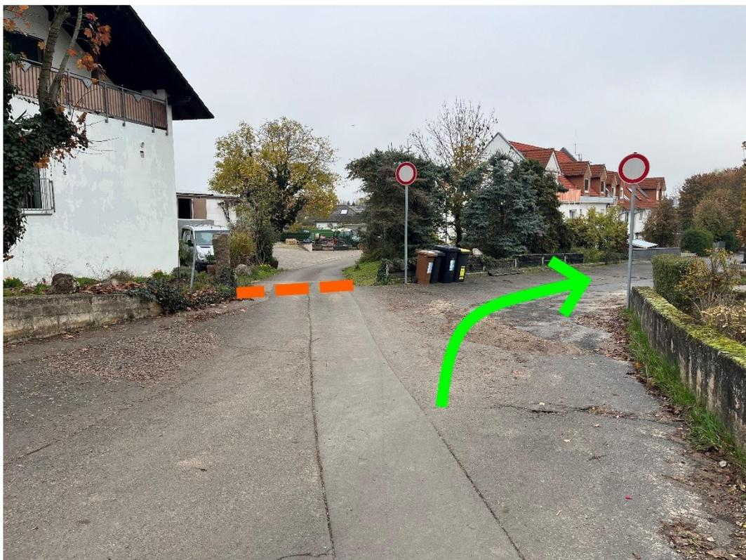
Abbildung 52: Notfließweg "Große Hohl" mit Aufwallung (orange) und Entwässerung in Richtung RRB (grün)
