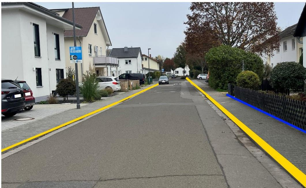
Abbildung 64: Notfließweg "Balthasarstraße" mit Objektschutzmaßnahmen (blau) und Bordanlagen (gelb)
