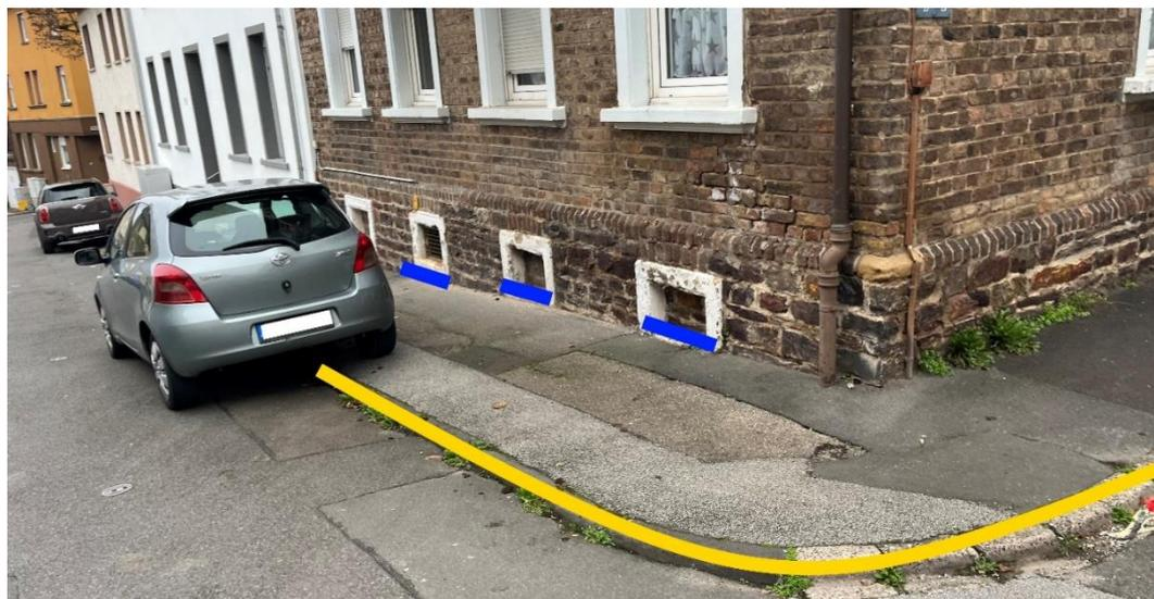
Abbildung 74 - Notfließweg „Schlossstraße“ mit Objektschutzmaßnahmen (blau) und Bordanlagen (gelb)
