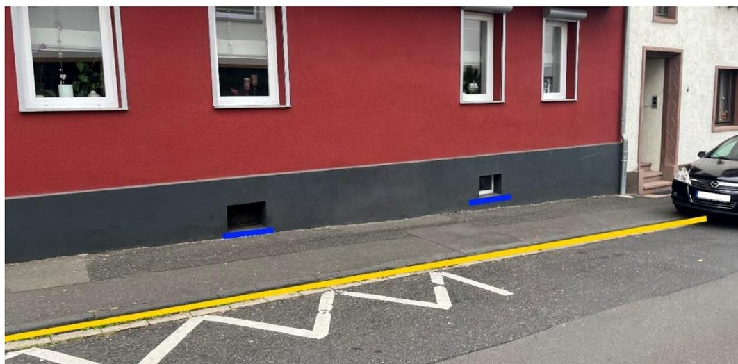
Abbildung 87 - Notfließweg „Schlossstraße“ mit Objektschutzmaßnahmen (blau) und Bordanlagen (gelb)
