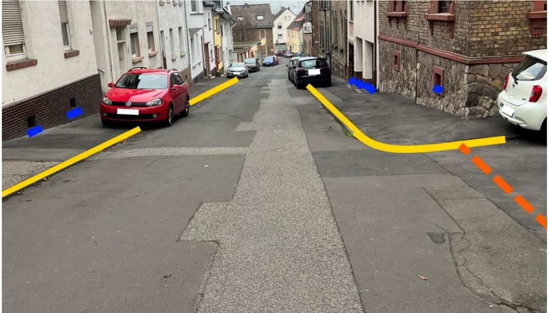
Abbildung 66 - Notfließweg „Schlossstraße“ mit Objektschutzmaßnahmen (blau), Aufwallung (orange) und Bordanlagen (gelb)
