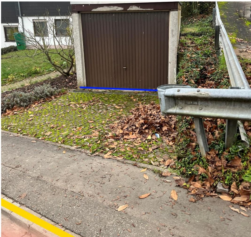
Abbildung 22 - Notfließweg „Im Bangert“ mit Objektschutzmaßnahmen (blau) und Bordanlagen (gelb)
