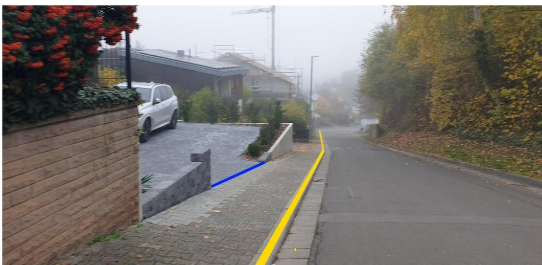
Abbildung 18 - Notfließweg „Im Bangert“ mit Objektschutzmaßnahmen (blau) und Bordanlagen (gelb)
