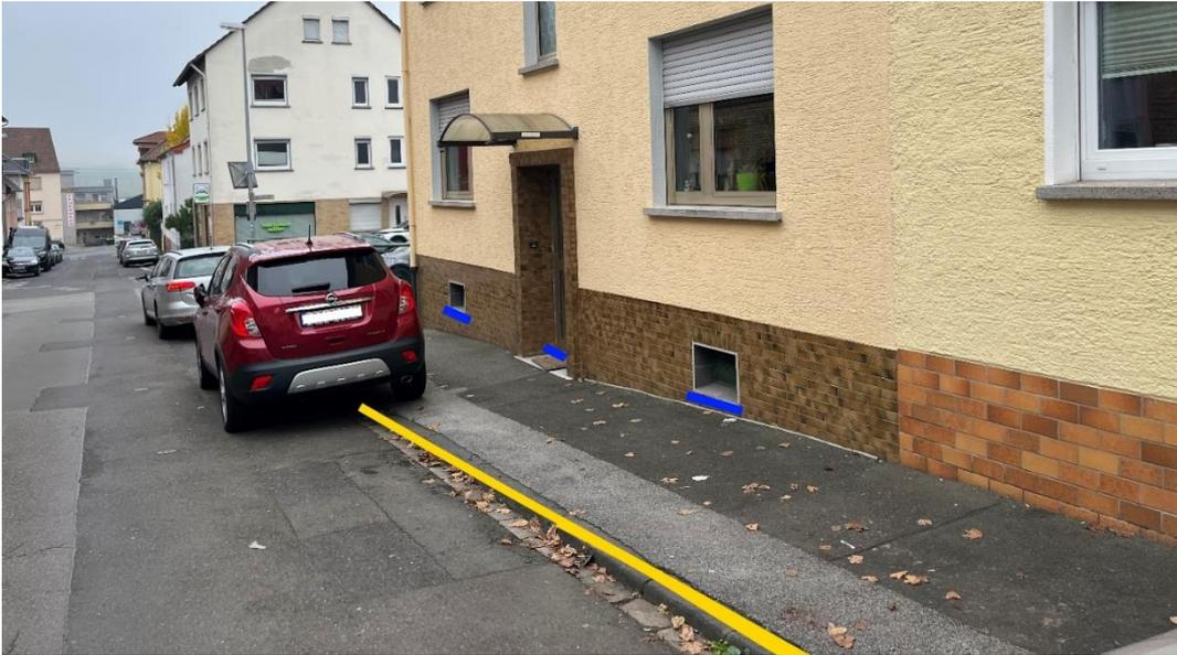
Abbildung 82 - Notfließweg „Schlossstraße“ mit Objektschutzmaßnahmen (blau) und Bordanlagen (gelb)
