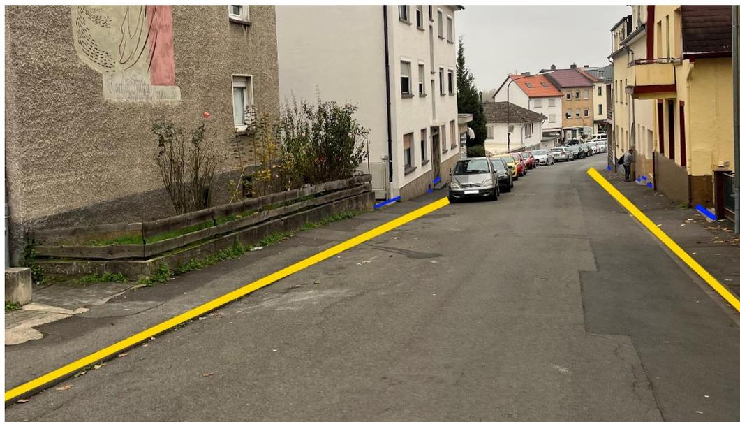
Abbildung 118 - Notfließweg „Prinzenkopfstraße“ mit Objektschutzmaßnahmen (blau) und Bordanlagen (gelb)
