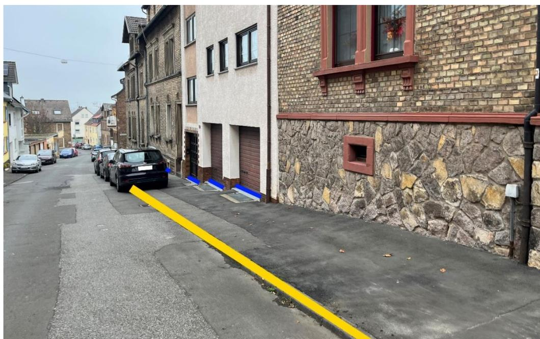
Abbildung 68 - Notfließweg „Schlossstraße“ mit Objektschutzmaßnahmen (blau) und Bordanlagen (gelb)
