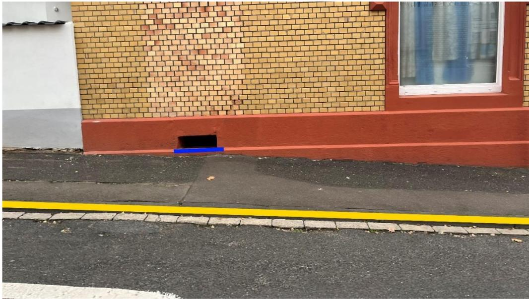
Abbildung 94 - Notfließweg „Schlossstraße“ mit Objektschutzmaßnahmen (blau) und Bordanlagen (gelb)
