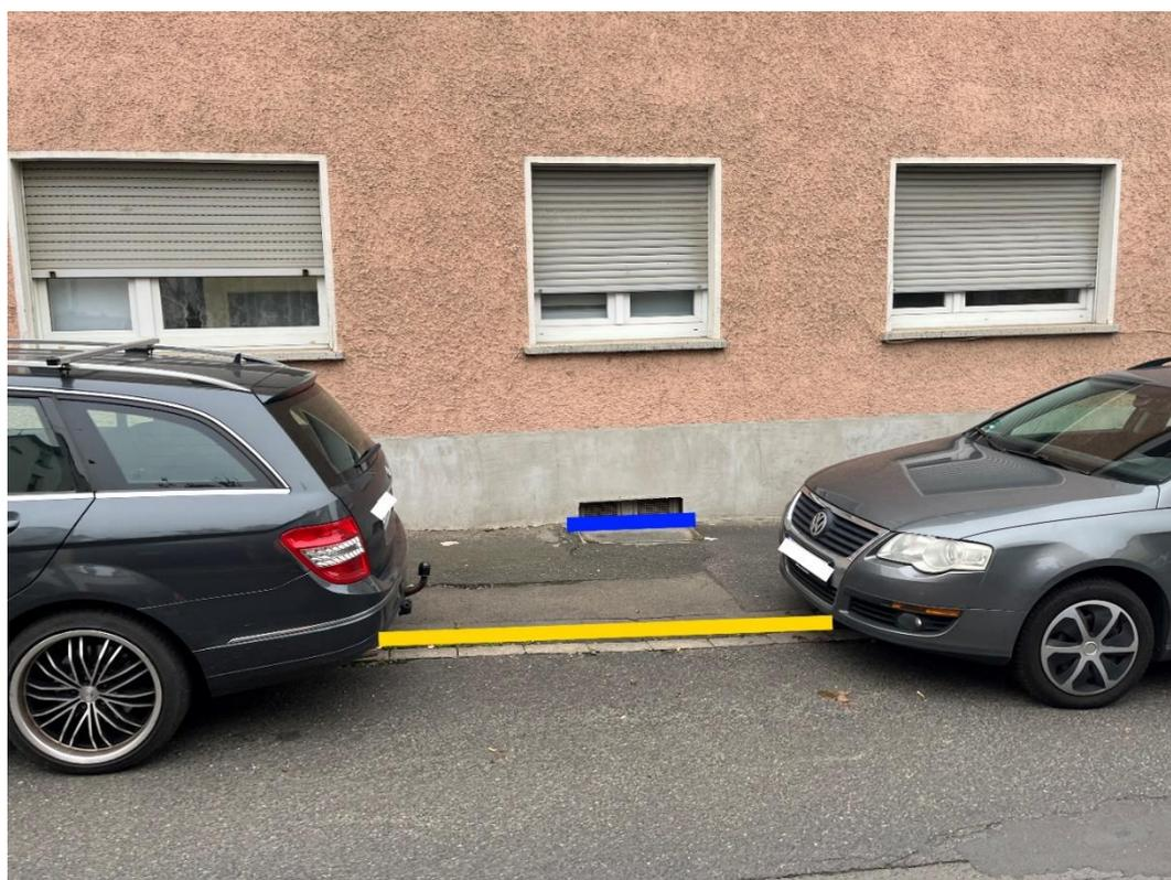
Abbildung 91 - Notfließweg „Schlossstraße“ mit Objektschutzmaßnahmen (blau) und Bordanlagen (gelb)
