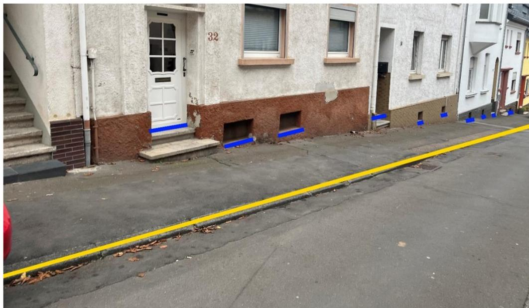
Abbildung 69 - Notfließweg „Schlossstraße“ mit Objektschutzmaßnahmen (blau) und Bordanlagen (gelb)
