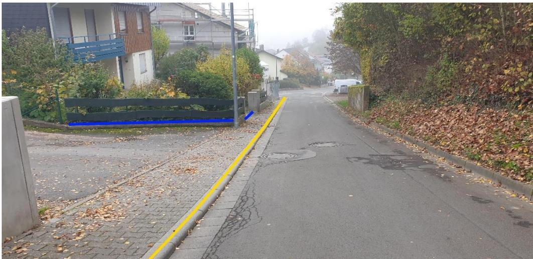
Abbildung 19 - Notfließweg „Im Bangert“ mit Objektschutzmaßnahmen (blau) und Bordanlagen (gelb)
