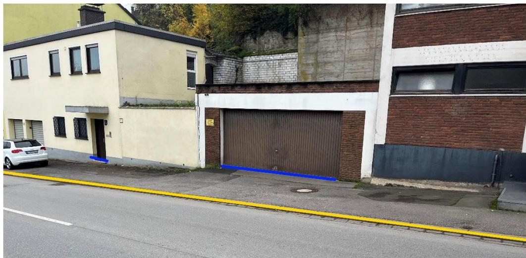
Abbildung 41 - Notfließweg „Stromberger Straße“ mit Objektschutzmaßnahmen (blau) und Bordanlagen (gelb)
