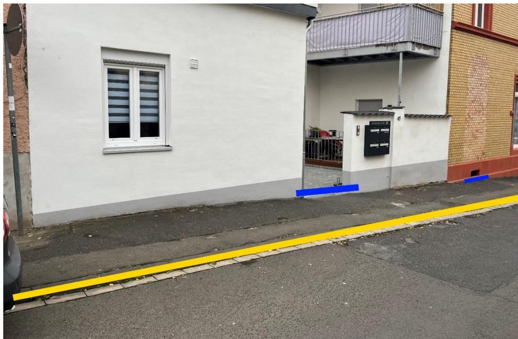
Abbildung 92 - Notfließweg „Schlossstraße“ mit Objektschutzmaßnahmen (blau) und Bordanlagen (gelb)
