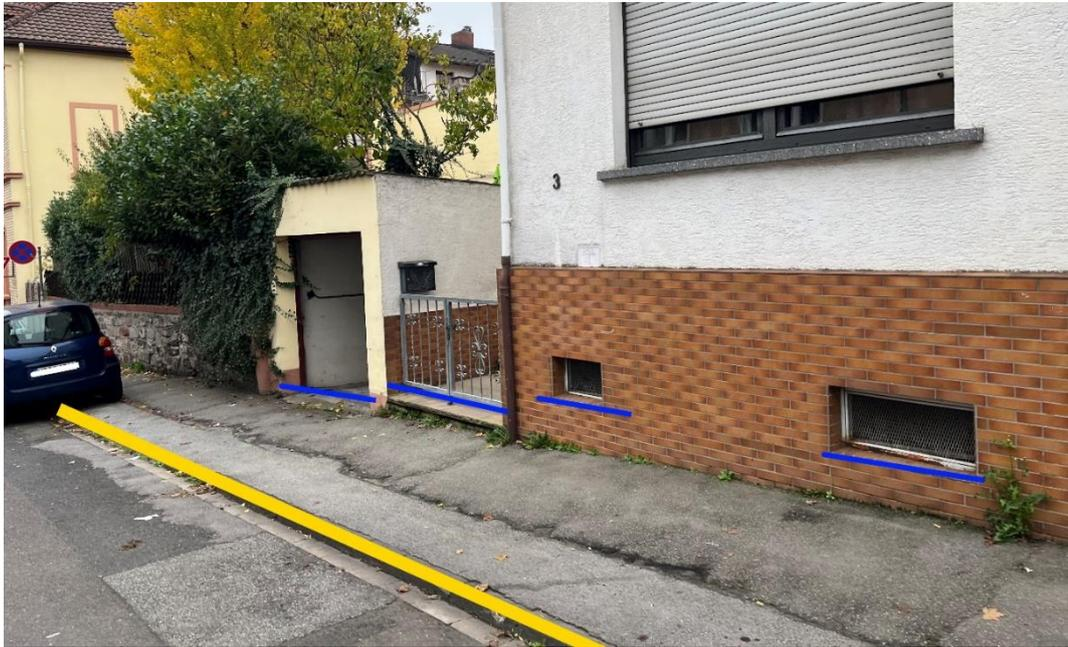
Abbildung 89 - Notfließweg „Schlossstraße“ mit Objektschutzmaßnahmen (blau) und Bordanlagen (gelb)
