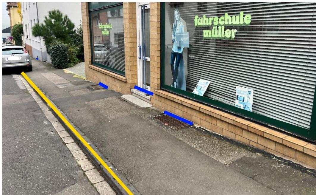
Abbildung 86 - Notfließweg „Schlossstraße“ mit Objektschutzmaßnahmen (blau) und Bordanlagen (gelb)
