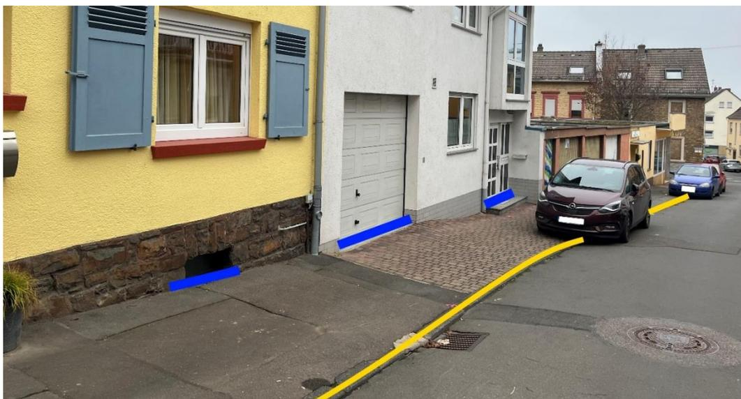
Abbildung 73 - Notfließweg „Schlossstraße“ mit Objektschutzmaßnahmen (blau) und Bordanlagen (gelb)
