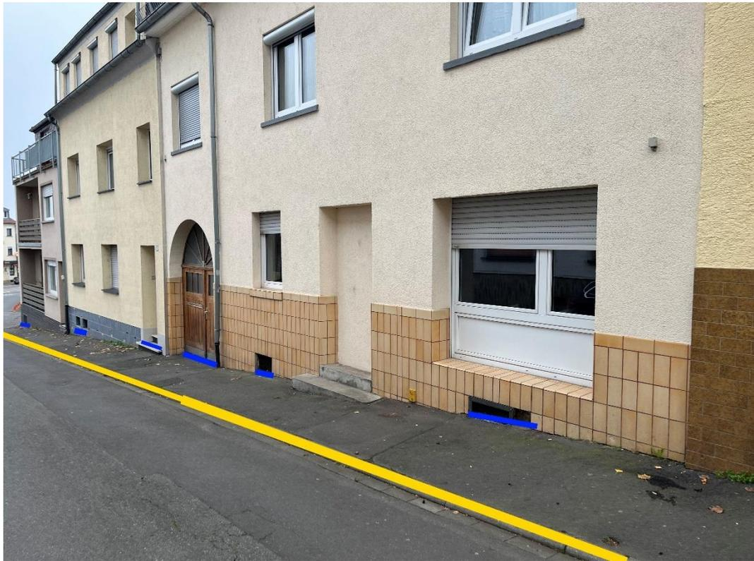
Abbildung 121 - Notfließweg „Prinzenkopfstraße“ mit Objektschutzmaßnahmen (blau) und Bordanlagen (gelb)
