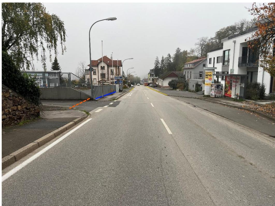
Abbildung 34 - Notfließweg „Stromberger Straße“ mit Objektschutzmaßnahmen (blau), Aufwallung (orange) und Bordanlagen (gelb)
