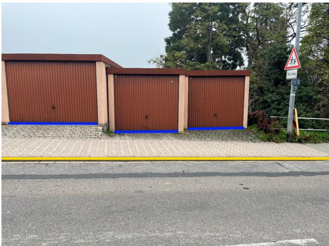
Abbildung 50 - Notfließweg „Stromberger Straße“ mit Objektschutzmaßnahmen (blau) und Bordanlagen (gelb)
