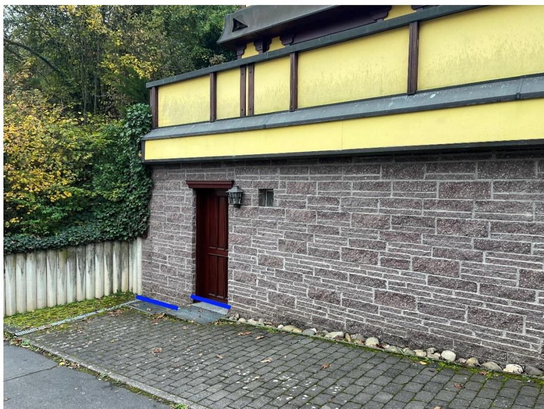
Abbildung 30 - Notfließweg „Im Bangert“ mit Objektschutzmaßnahmen (blau)
