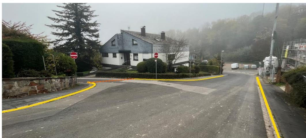
Abbildung 12 - Notfließweg „Im Bangert“ mit Aufwallung (orange) und Bordanlagen (gelb)
