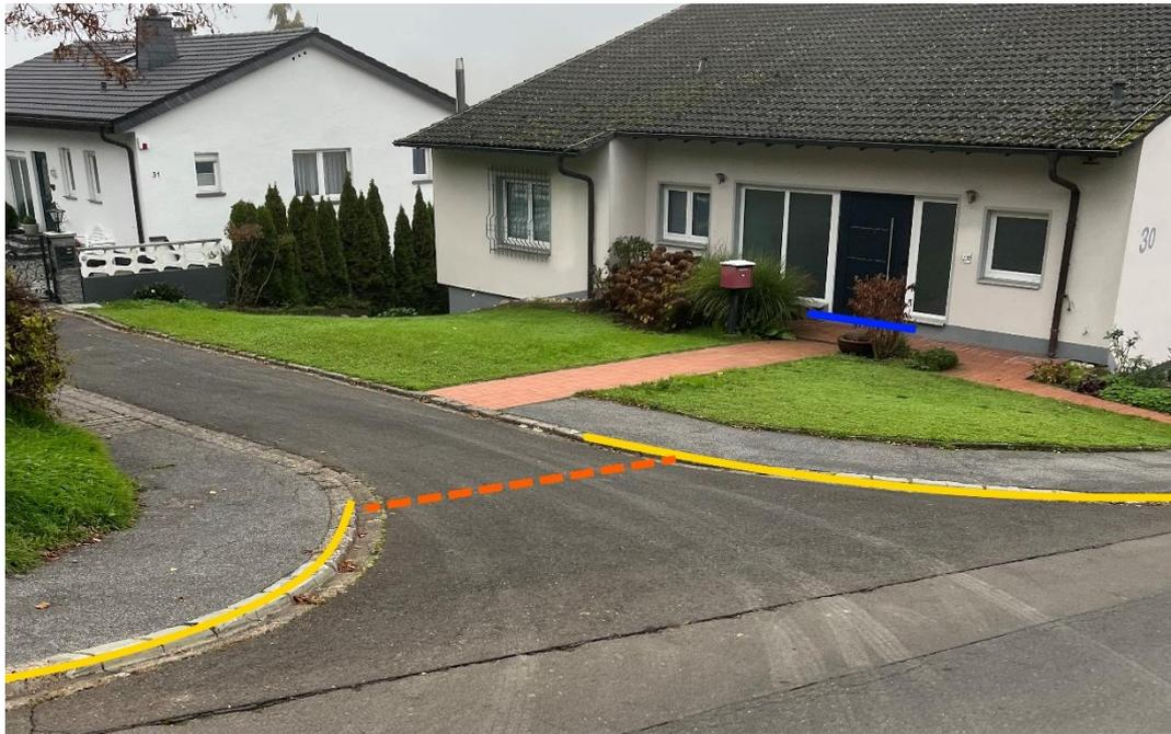
Abbildung 9 - Notfließweg „Im Bangert“ mit Objektschutzmaßnahmen (blau),
