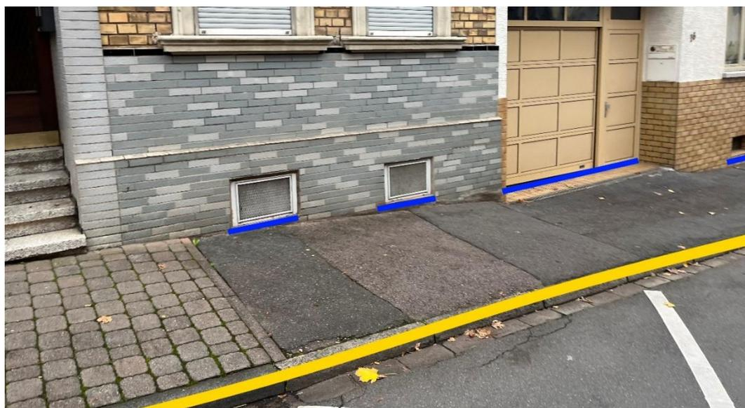
Abbildung 79 - Notfließweg „Schlosstraße“ mit Objektschutzmaßnahmen (blau) und Bordanlagen (gelb)
