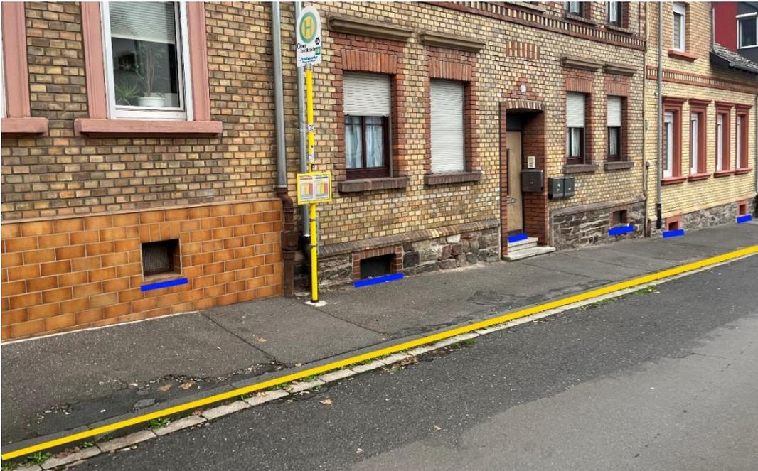
Abbildung 83 - Notfließweg „Schlossstraße“ mit Objektschutzmaßnahmen (blau) und Bordanlagen (gelb)
