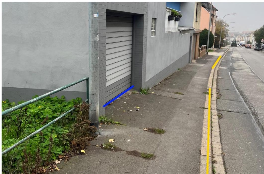
Abbildung 45 - Notfließweg „Stromberger Straße“ mit Objektschutzmaßnahmen (blau) und Bordanlagen (gelb)
