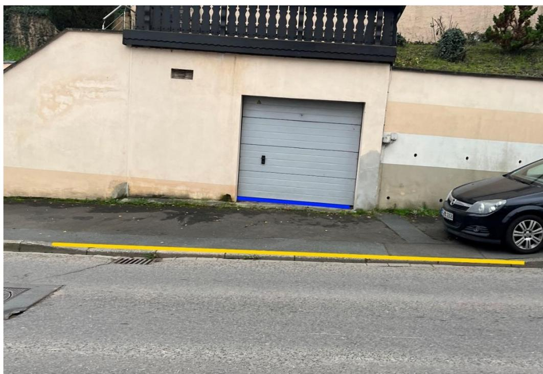
Abbildung 44 - Notfließweg „Stromberger Straße“ mit Objektschutzmaßnahmen (blau) und Bordanlagen (gelb)
