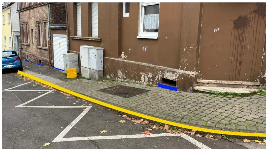
Abbildung 78 - Notfließweg „Schlosstraße“ mit Objektschutzmaßnahmen (blau) und Bordanlagen (gelb)
