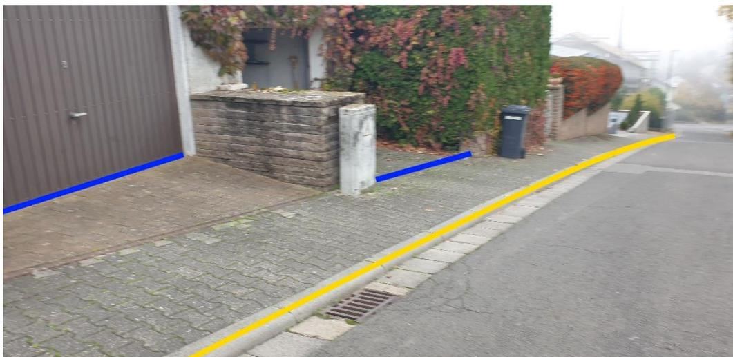
Abbildung 17 - Notfließweg „Im Bangert“ mit Objektschutzmaßnahmen (blau) und Bordanlagen (gelb)
