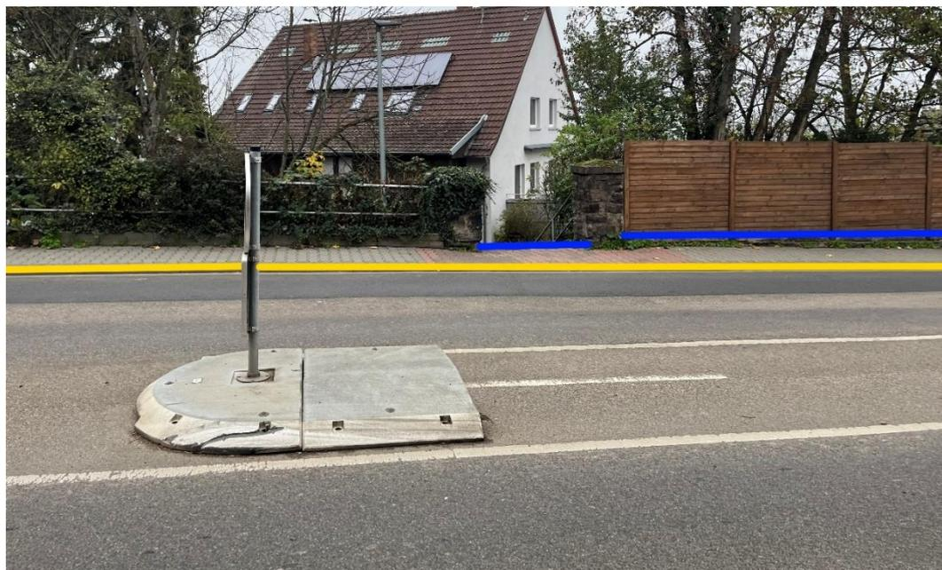
Abbildung 51 - Notfließweg „Stromberger Straße“ mit Objektschutzmaßnahmen (blau) und Bordanlagen (gelb)
