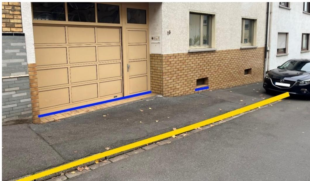
Abbildung 80 - Notfließweg „Schlossstraße“ mit Objektschutzmaßnahmen (blau) und Bordanlagen (gelb)
