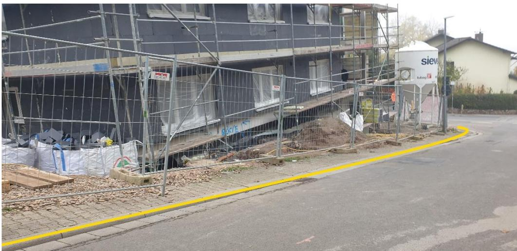
Abbildung 20 - Notfließweg „Im Bangert“ mit Objektschutzmaßnahmen (blau) und Bordanlagen (gelb)
