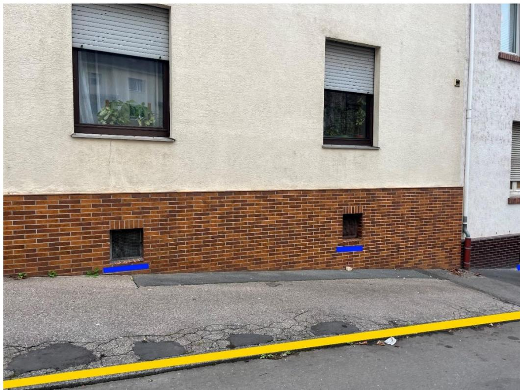
Abbildung 67 - Notfließweg „Schlossstraße“ mit Objektschutzmaßnahmen (blau) und Bordanlagen (gelb)
