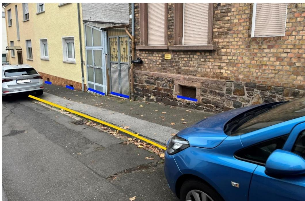
Abbildung 81 - Notfließweg „Schlossstraße“ mit Objektschutzmaßnahmen (blau) und Bordanlagen (gelb)
