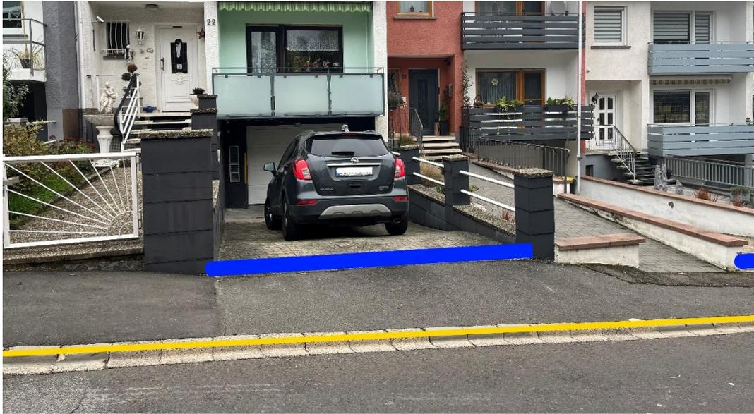
Abbildung 25 - Notfließweg „Im Bangert“ mit Objektschutzmaßnahmen (blau) und Bordanlagen (gelb)
