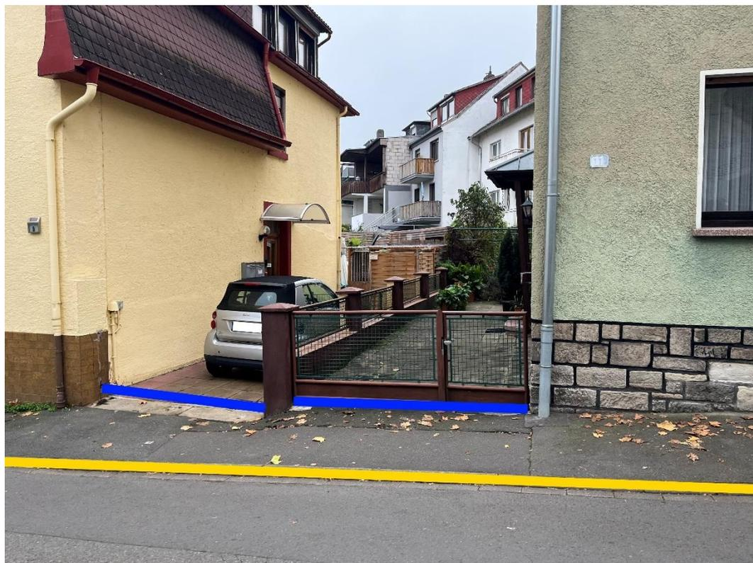
Abbildung 120 - Notfließweg „Prinzenkopfstraße“ mit Objektschutzmaßnahmen (blau) und Bordanlagen (gelb)
