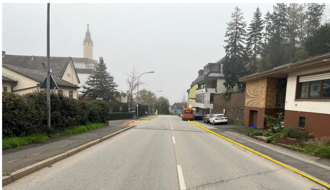
Abbildung 38 - Notfließweg „Stromberger Straße“ mit Objektschutzmaßnahmen (blau), Aufwallung (orange) und Bordanlagen (gelb)
