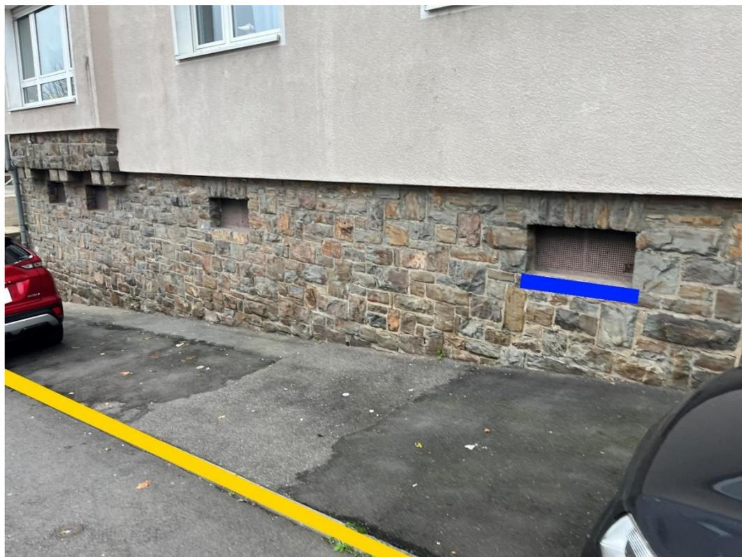
Abbildung 62 - Notfließweg „Schlossstraße“ mit Objektschutzmaßnahmen (blau) und Bordanlagen (gelb)
