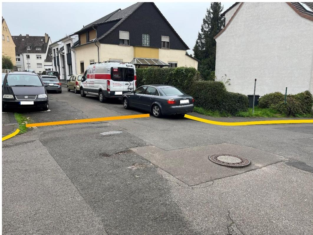
Abbildung 102 - Notfließweg „Elisenstraße“ mit Objektschutzmaßnahmen (blau), Aufwallung (orange) und Bordanlagen (gelb)
