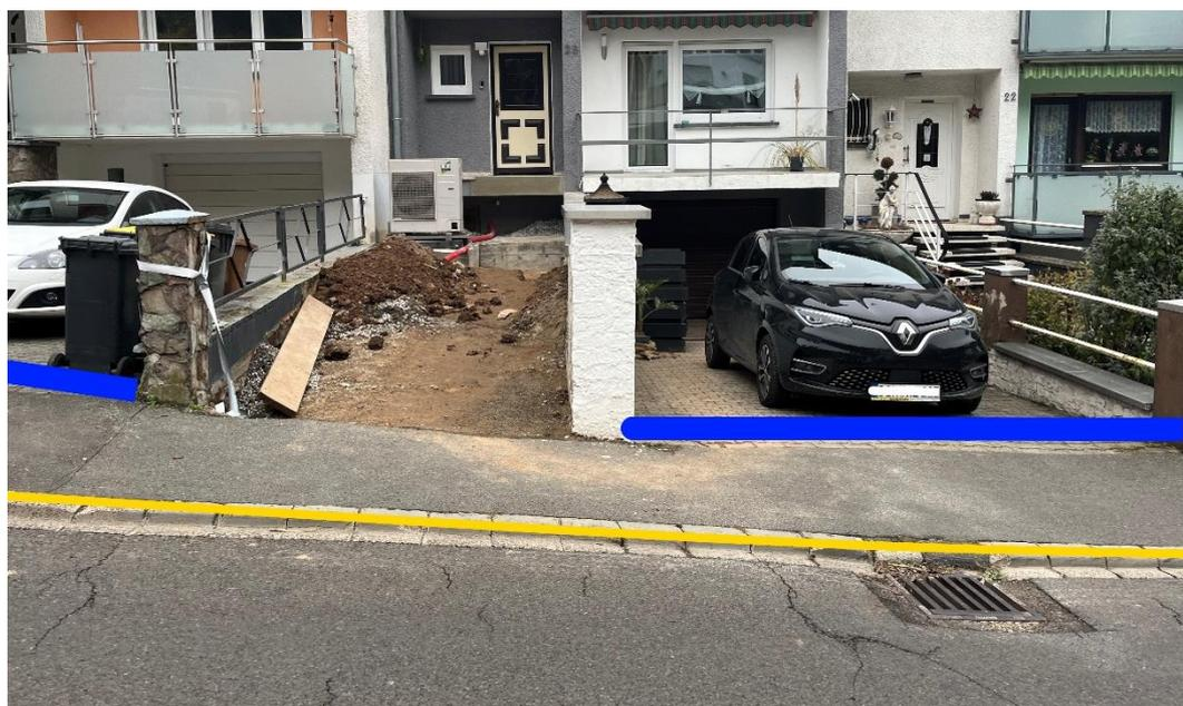
Abbildung 24 - Notfließweg „Im Bangert“ mit Objektschutzmaßnahmen (blau) und Bordanlagen (gelb)
