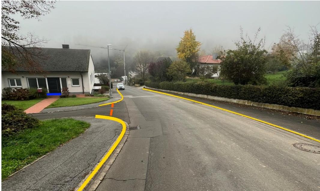
Abbildung 8 -Notfließweg „Im Bangert“ mit Objektschutzmaßnahmen (blau) und Bordanlagen (gelb)
