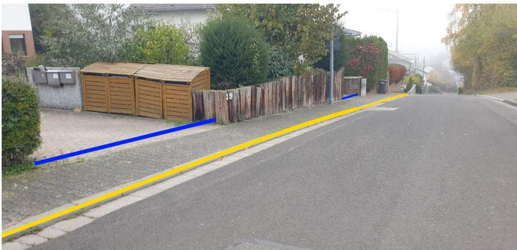
Abbildung 16 - Notfließweg „Im Bangert“ mit Objektschutzmaßnahmen (blau) und Bordanlagen (gelb)
