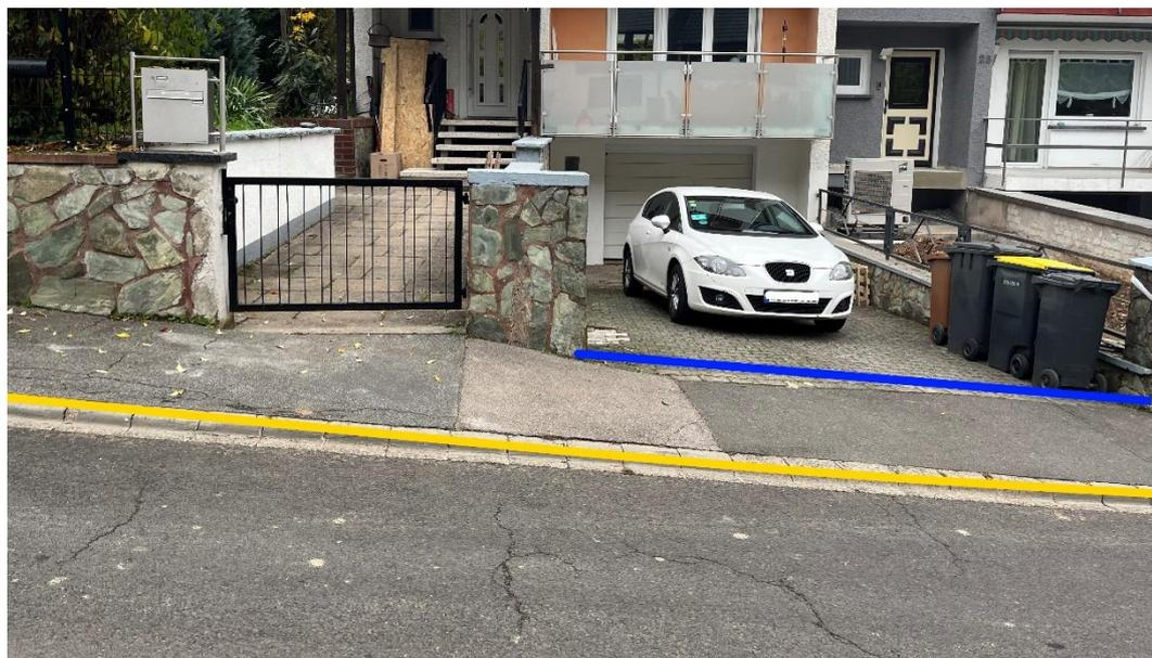
Abbildung 23 - Notfließweg „Im Bangert“ mit Objektschutzmaßnahmen (blau) und Bordanlagen (gelb)
