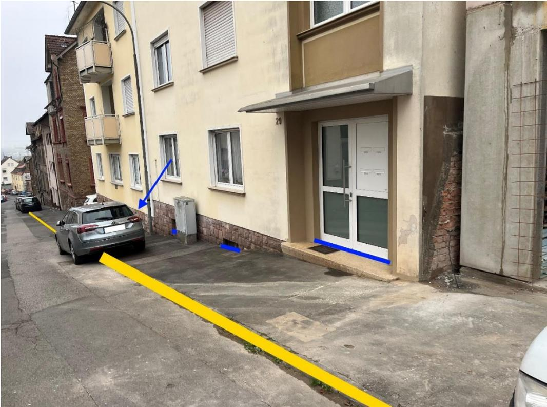
Abbildung 64 - Notfließweg „Schlossstraße“ mit Objektschutzmaßnahmen (blau) und Bordanlagen (gelb)
