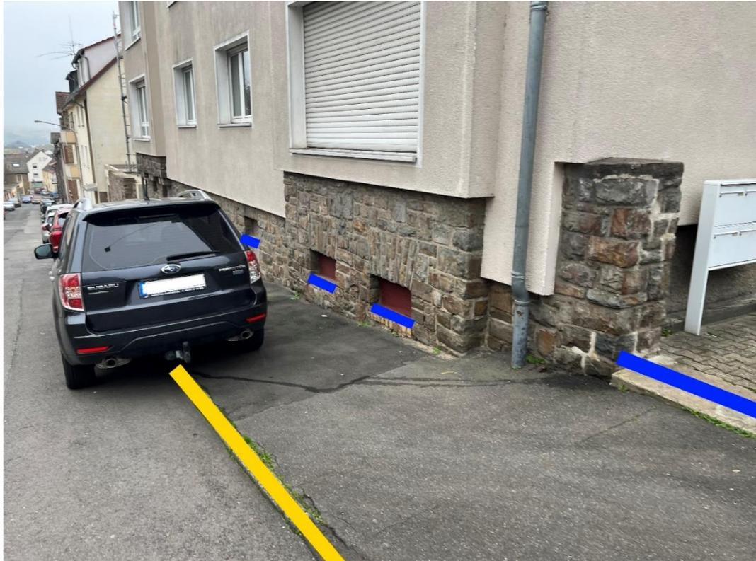
Abbildung 61 - Notfließweg „Schlossstraße“ mit Objektschutzmaßnahmen (blau) und Bordanlagen (gelb)
