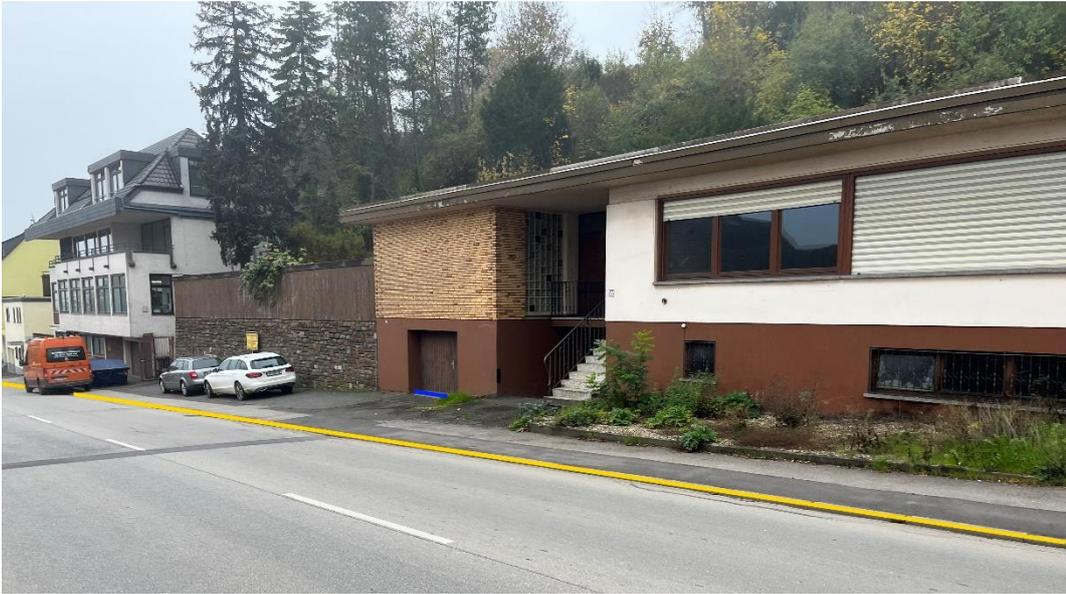
Abbildung 39 - Notfließweg „Stromberger Straße“ mit Objektschutzmaßnahmen (blau) und Bordanlagen (gelb)
