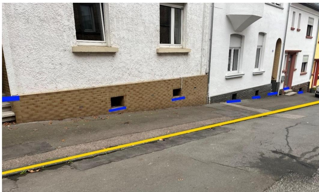
Abbildung 70 - Notfließweg „Schlossstraße“ mit Objektschutzmaßnahmen (blau) und Bordanlagen (gelb)
