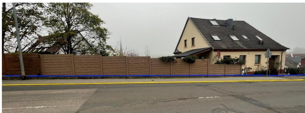
Abbildung 52 - Notfließweg „Stromberger Straße“ mit Objektschutzmaßnahmen (blau) und Bordanlagen (gelb)
