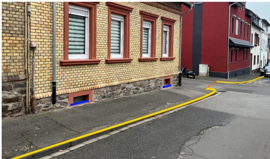
Abbildung 84 - Notfließweg „Schlossstraße“ mit Objektschutzmaßnahmen (blau) und Bordanlagen (gelb)
