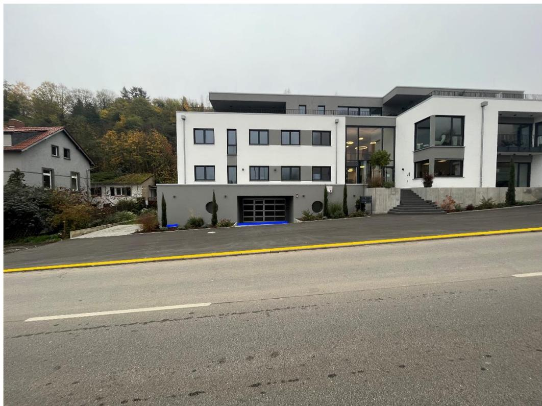
Abbildung 37 - Notfließweg „Stromberger Straße“ mit Objektschutzmaßnahmen (blau) und Bordanlagen (gelb)
