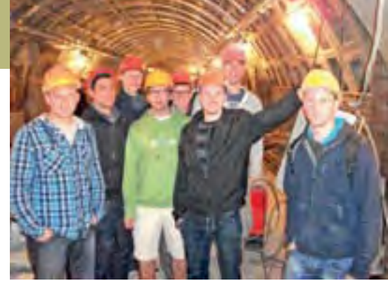
In der Metrobaustelle
