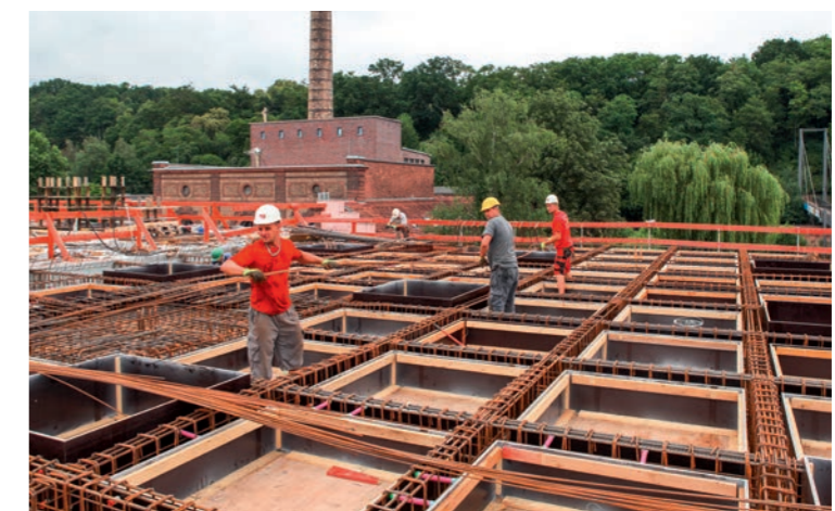
Arbeiter ziehen den Bewehrungsstahl für die Kassettendecke der Mensa ein
