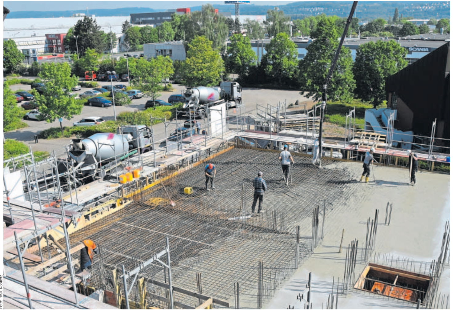
Auf dem Gelände der HwK in der Koblenzer August-Horch-Straße wird bereits am Neubau der Mensa gearbeitet. Hier soll auch (im linken Bereich des Bildes) das neue Verwaltungsgebäude der Handwerkskammer entstehen. Der Architektenwettbewerb dazu ist jüngst gestartet.
