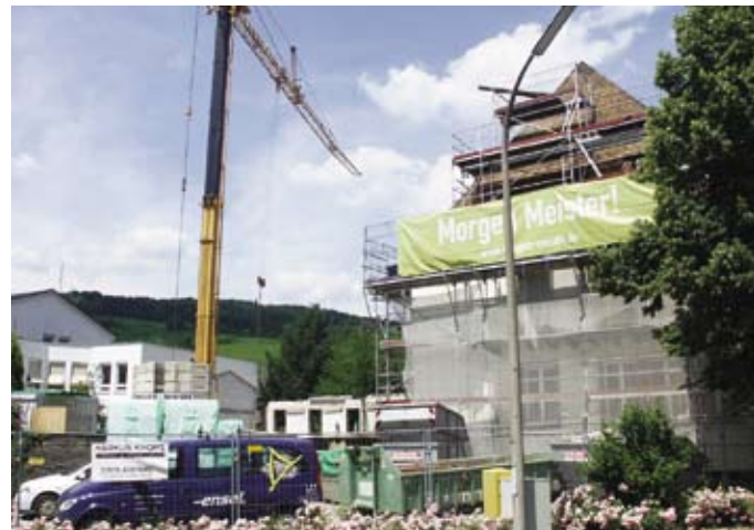
Es geht voran auf der Baustelle der Ahr-Akademie. Foto: Diester
