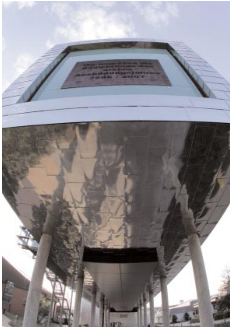
Das Gebäude des HwK-Kompetenzzentrums für Gestaltung, Fertigung und Kommunikation spiegelt seine innovative Bestimmung wider. Fotos (3): Piel
