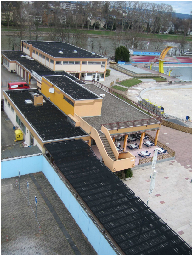
Schwimmbad Oberwerth mit den auf den Dächern verlegten Solarabsorbern
