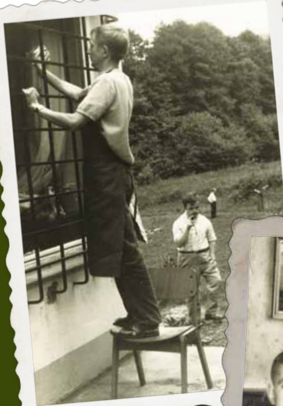
Hans-Dieter Thalhäuser beim Fensterputzen auf dem Niederreidenbacher Hof
