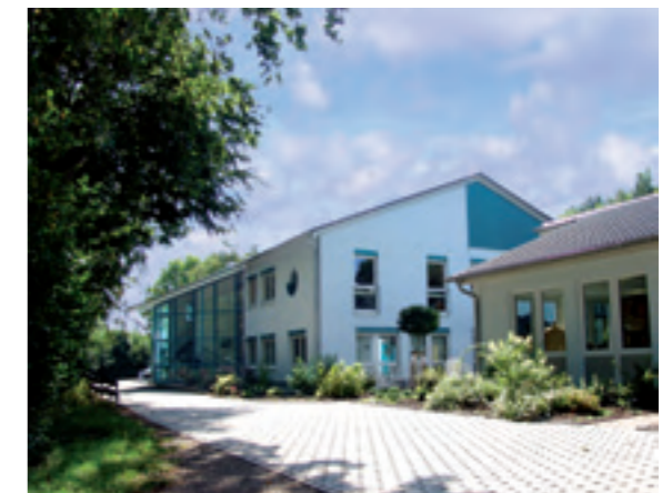
Die Werkstatt in Asbacher Hütte
