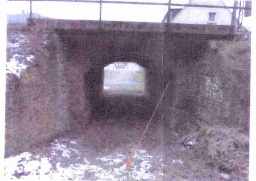
Ansatzpunkt Bohrung / DPH 3
