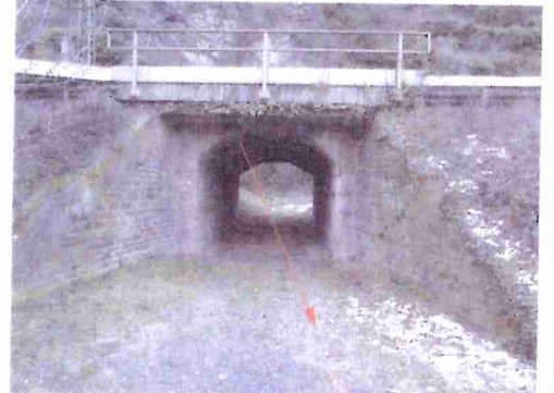
Ansatzpunkt Bohrung / DPH 4
