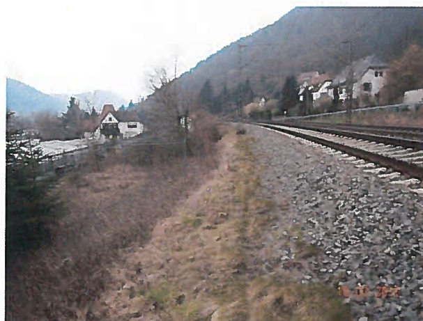
Abb. 2: Blick entlang der Trasse nach Westen
