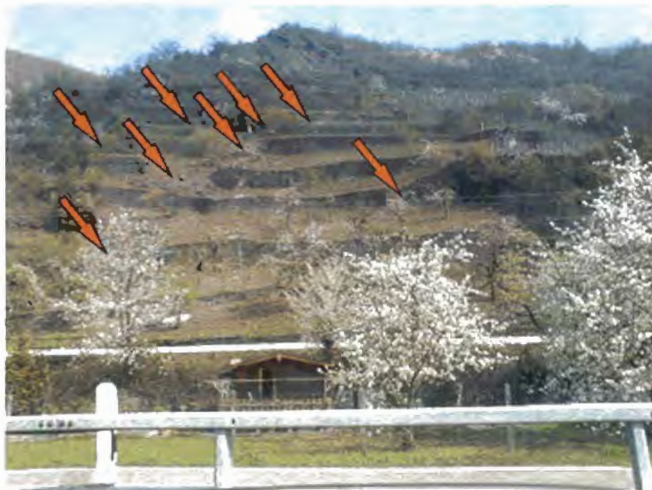
Abbildung 2: Kompensationsfläche „Heiligenhäuschen“, Gemarkung Wellmich, bei St. Goarshausen vor den Trockenmauersanierungen
