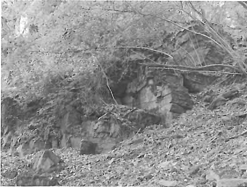
Abbildung 5: Aufschlüsse im Wald oberhalb des geplanten Fangzauns 2 (bei ca. km 128,060, in einer Höhe von ca. 142 m NN), der Gesteinsverband ist stark aufgelockert und entfestigt. Blöcke von bis zu ca. 1m 3 Volumen sind aus dem Gesteinsverband gelöst.
