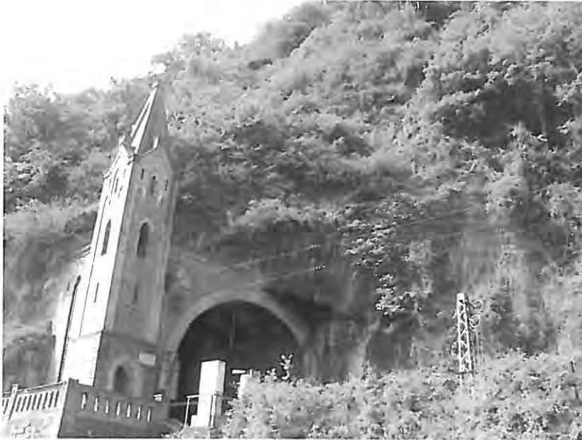
Abbildung 10: Nordportal Kammereck bei km 128,231, im Hang oberhalb des Portals ist die Installation des Fangzauns 5 geplant.
