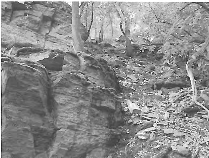
Abbildung 6: Aufschlüsse und ausgedehnte Schuttfelder auf sehr steilen Hängen oberhalb des geplanten Fangzauns 2 (bei ca. km 128,060, in einer Höhe von ca. 142 m NN), der Gesteinsverband ist stark aufgelockert und entfestigt.
