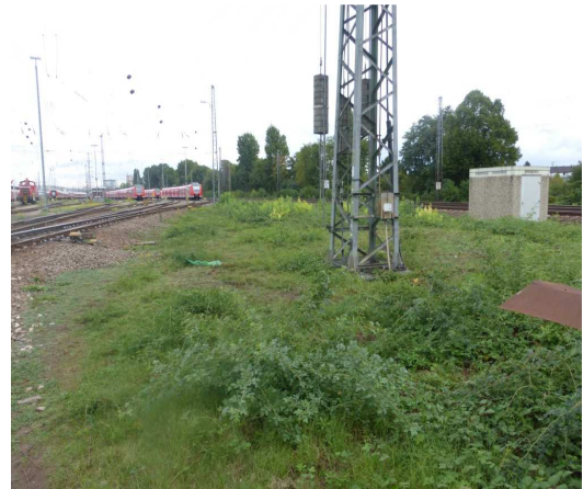
Abbildung 6: Blick Richtung Norden auf die CEF-Fläche mit einer Gesamtgröße von ca. 1379 m 2
