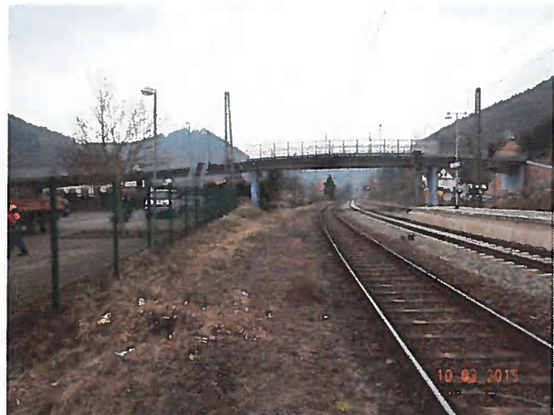
Abb. 2: Brücke im Zuge der Sommerbergstraße über die DB-Strecke am Bahnhof Lambrecht
