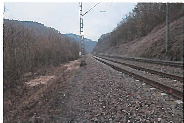
Abb. 2: Blick entlang der Trasse nach Nordwesten
