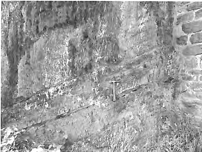
Abbildung 1: An der Felswand zwischen der Straße B9 und dem Tunnelportal Kammereck bei ca. km 128,231 stehen Tonschiefern und Quarzite in engem Wechsel an. Die flach relativ einfallende Schichtung (S1) und die Steil stehende Schieferung (Sfr) sind in dem Aufschluss deutlich erkennbar.
