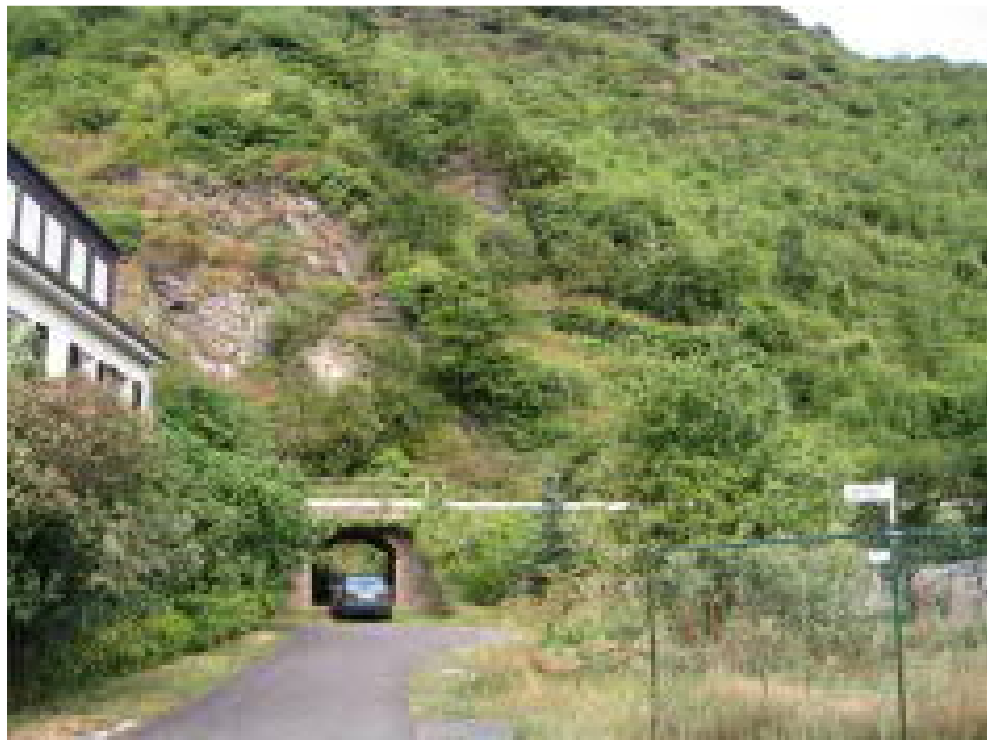
Abbildung 2: Baufeld von der Bundesstraße aus
