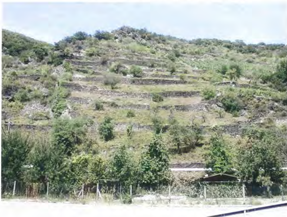
Abbildung 3: Kompensationsfläche „Heiligenhäuschen“, Gemarkung Wellmich, bei St. Goarshausen vor den Trockenmauersanierungen
