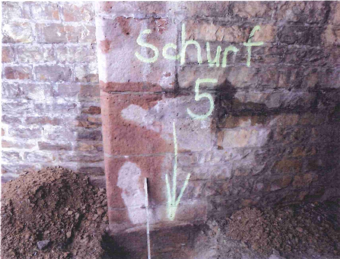
Bild 9: Ansatzpunkt Gründungsschurf 5
