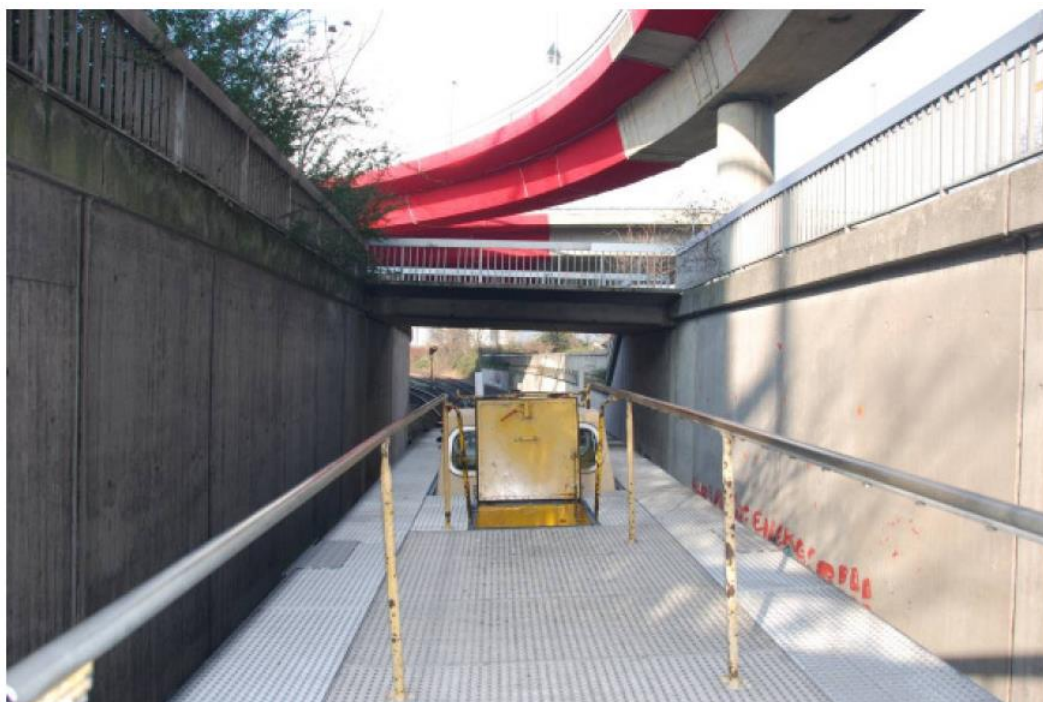
Bereich Rampe Nord
