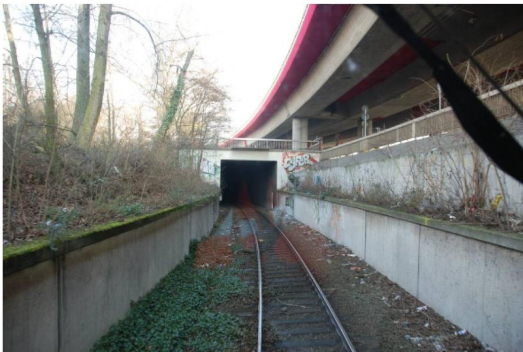
Bereich Rampe Süd
