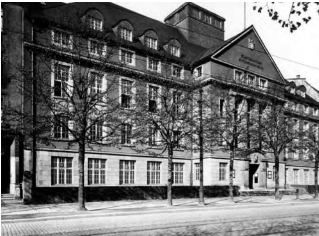
Der Bibliotheksbau vor 1945. Auf dem Foto ist noch der Turm zu sehen, der bei den Luftangriffen im Zweiten Weltkrieg zerstört wurde. Foto: Stadtarchiv Mainz (bps5436a)
