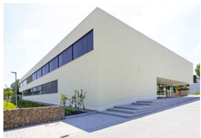
Das neue Mensagebäude, in dem sich die Schulbibliothek und das Kreismedienzentrum befinden.
