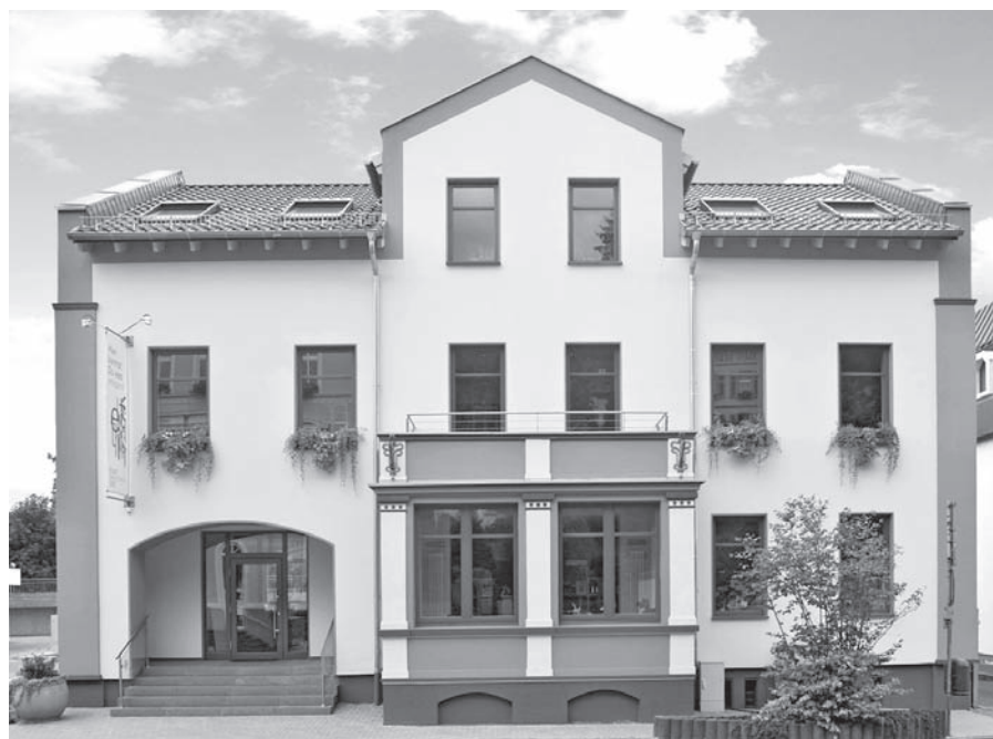
Die beispielhafte Sanierung der Stadtbibliothek Diez wurde mit dem „Energie Effizienz Award 2009“ ausgezeichnet: Energiesparende Fenster, Vollwärmeschutz auf der Fassade, ein gedämmter Dachstuhl, eine Gas-Brennwert-Heizung und energiesparende Beleuchtung tragen zur Energieeffizienz bei, optische und funktionale Elemente sind attraktiv umgesetzt. Foto: Gerhard Resch
