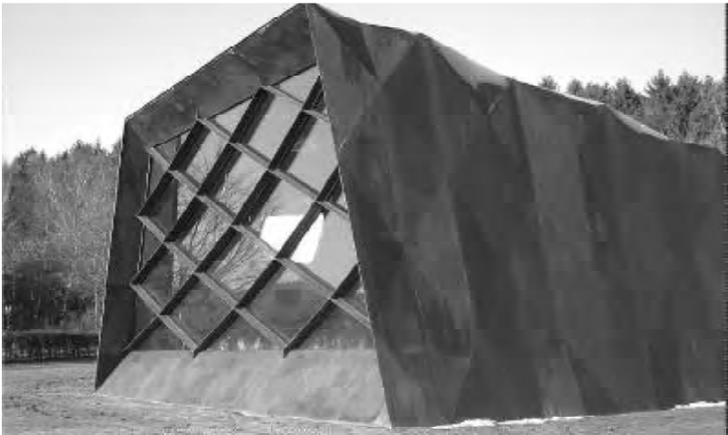
Blick auf die Vorderseite des neuen Dokumentationszentrums
