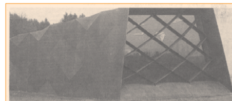
Dem „roströten Störfeld“ ist ein Extraheft der „neuen Architektenführer gewidmet worden. TV-Foto: Archiv/Axel Munsteiner
