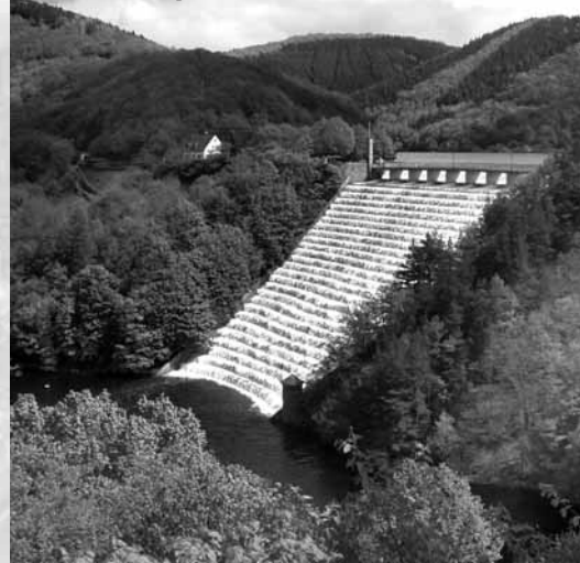
Die Urftstauwand im Nationalpark Eifel Foto: Nationalparkforstamt Eifel
