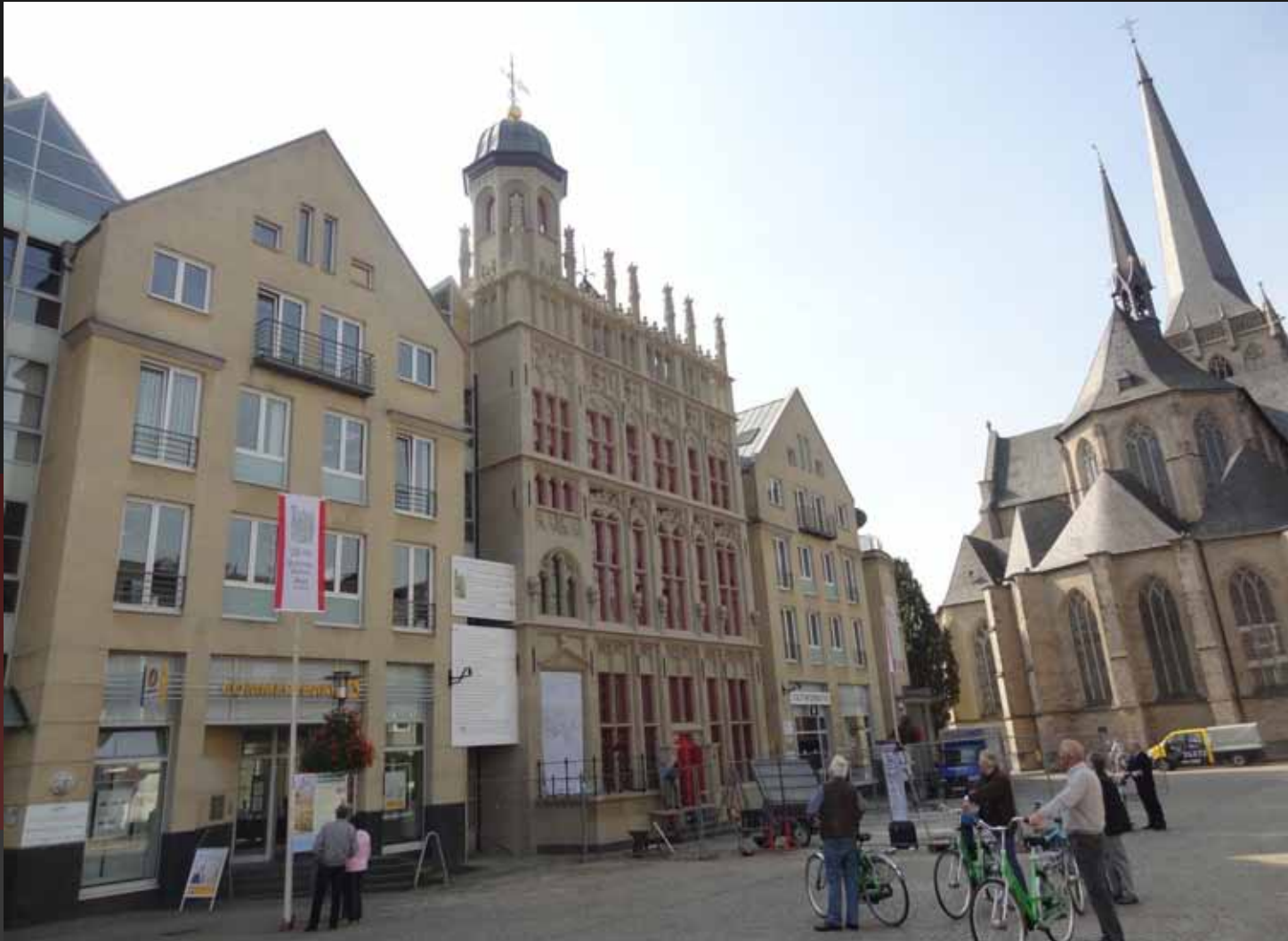
Rekonstruktion der Rathaus- Fassade in Wesel 2011
