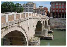
Beispiel Römerbrücke mit steinerner Brüstung
