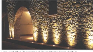
Herausarbeiten der antiken Steinstrukturen durch Strahler
