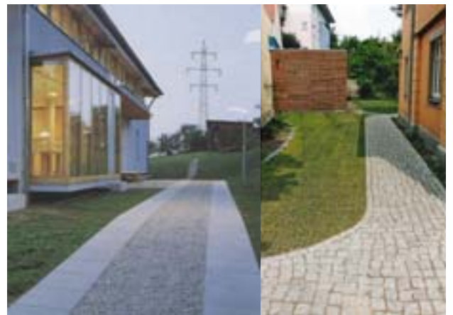
Wassergebundene Decke mit Betonplatten eingefasst
