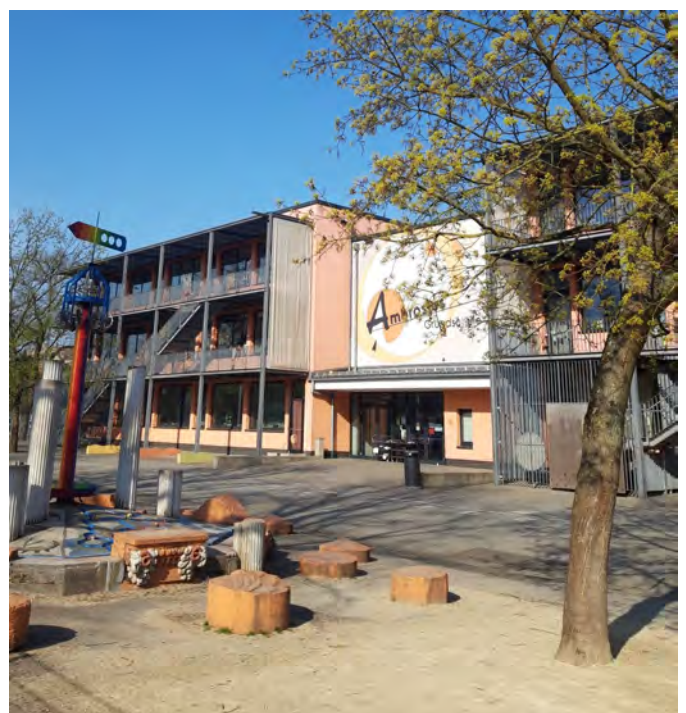
Schulgebäude Grundschule Ambrosius
