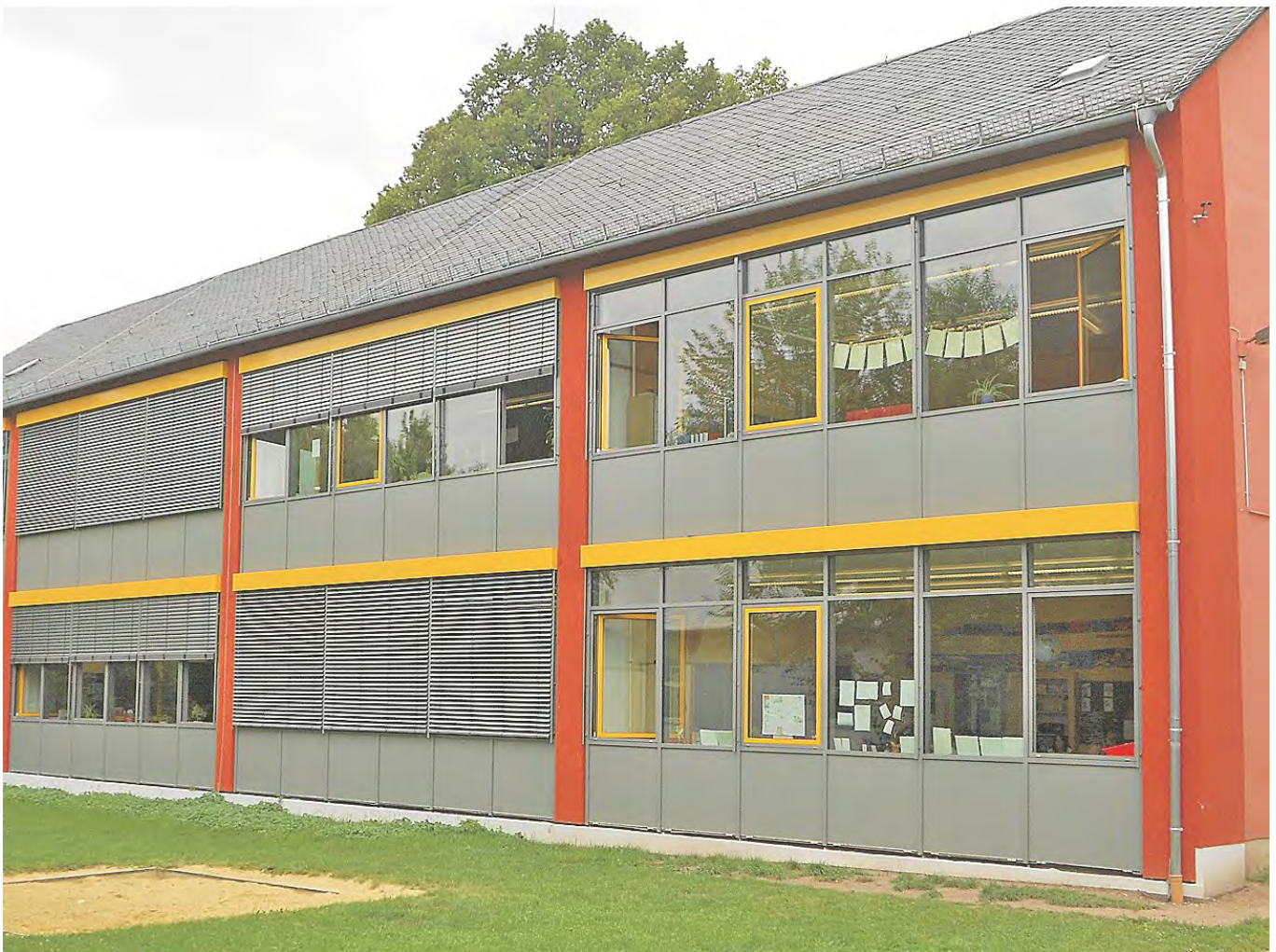
Schulgebäude Grundschule Heiligkreuz
