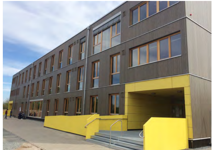
MobiSchool—Schulgebäude in Modulbauweise an der IGS
