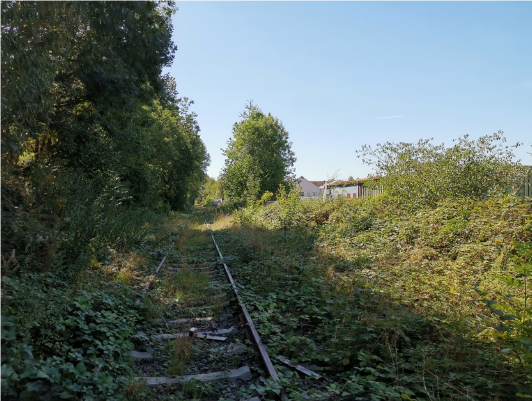
Abb. 2: Westlich des Abfangbereichs gelegener Trassenabschnitt, der aufgrund starker Beschattung unbesiedelt ist.
