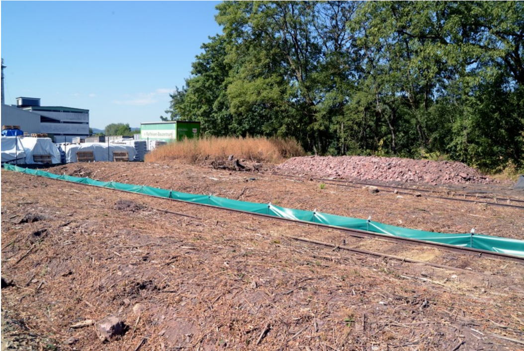
Abb. 4: Blick auf den ersten fertig gestellten Steinwall und die Einzäunung der Fläche.
