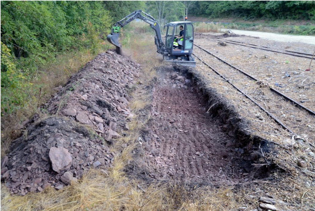
Abb. 3: Auskoffnung der Fläche für den ersten Steinwall im hinteren Bereich der Ausgleichsfläche.
