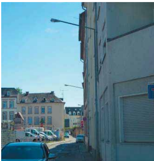
Gervasiusstraße: Einseitige Anordnung mit überdimensioniertem Ausleger
