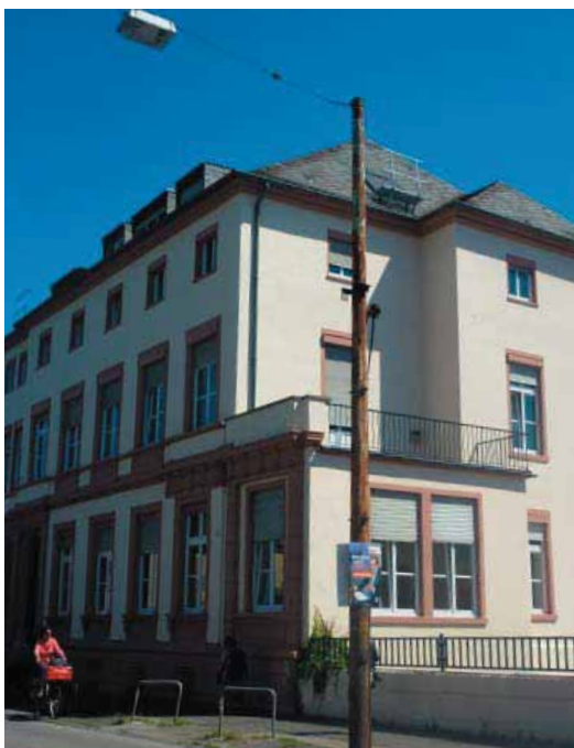
Bsp. stark korrodierter Leuchtenmast Hindenburgstr.
