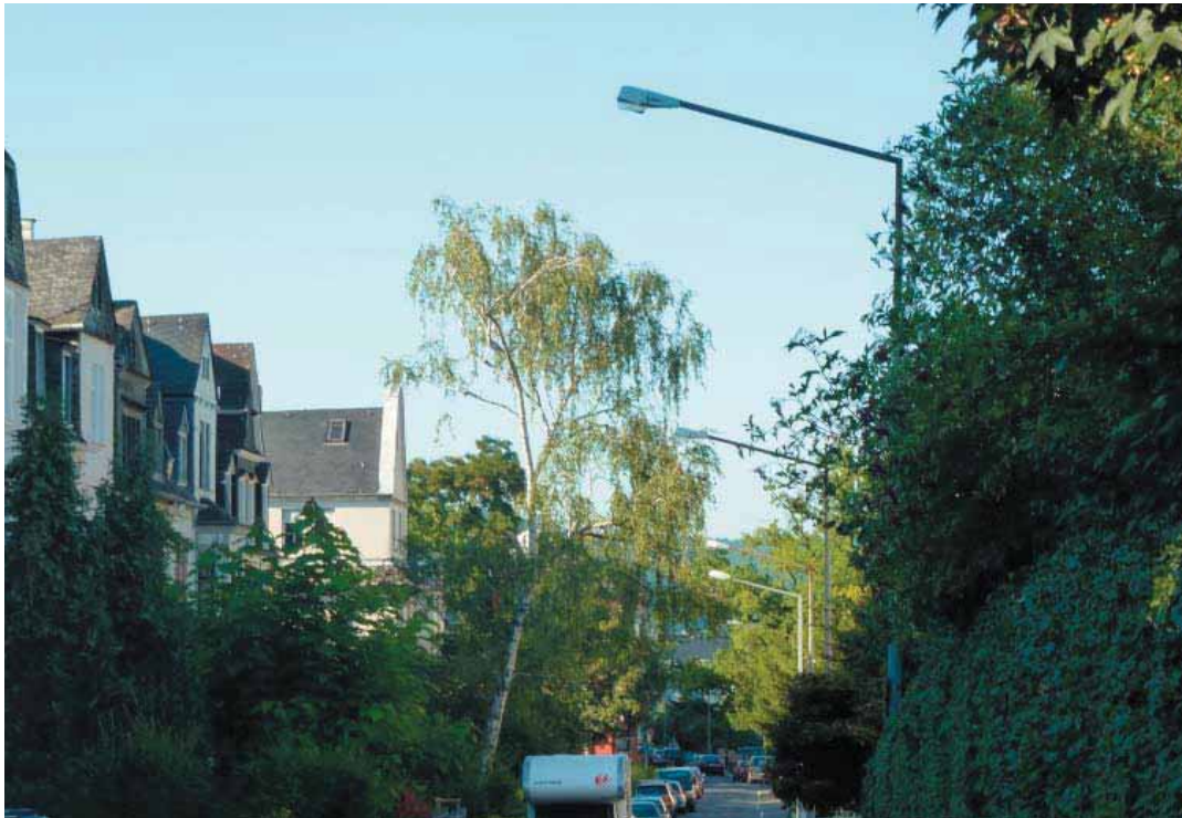
Kurfürstenstraße: Überdimensionierter Ausleger
