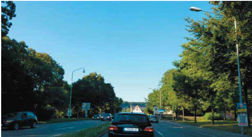
Krahnenufer: Beidseitig versetzt, verschiedene Leuchtentypen
