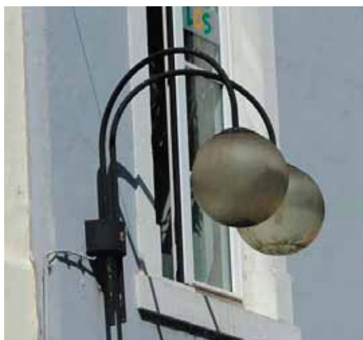
Beispiel stark verschmutzte Kugelleuchte Brotstraße
