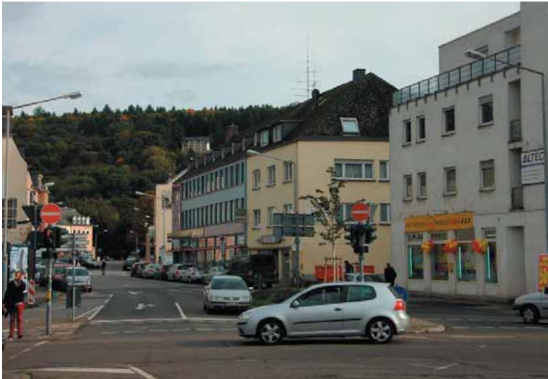
Gartenfeldstraße: Kofferleuchten an Mast mit Standardausleger
