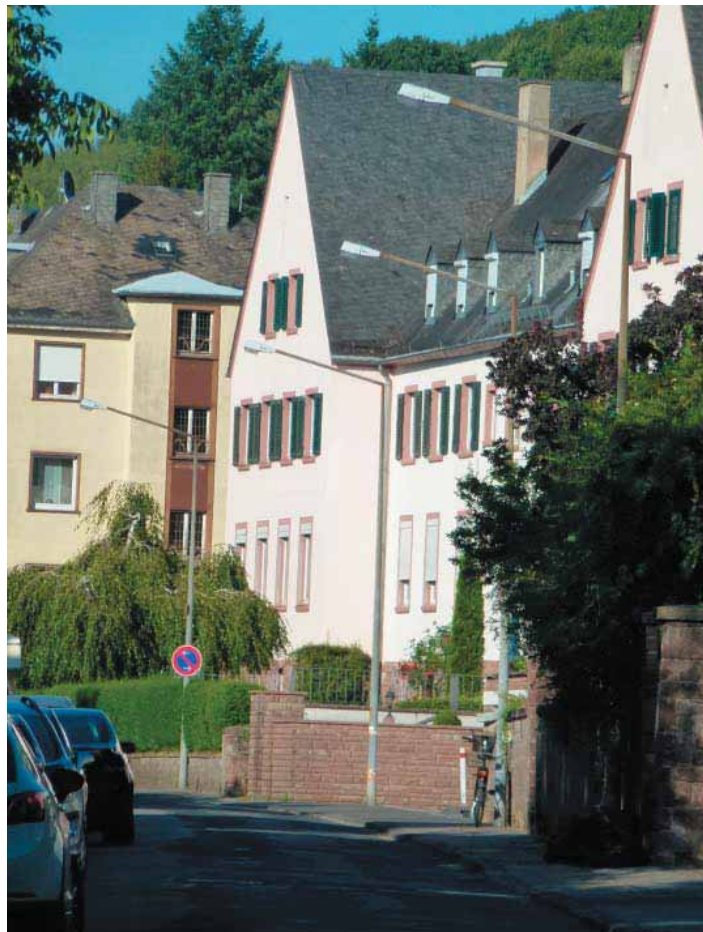
Kurfürstenstraße: Überdimensionierter Ausleger
