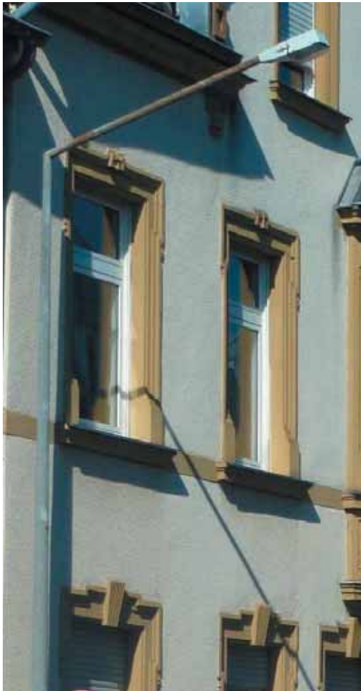
Beispiel stark korrodierter Leuchtenmast
