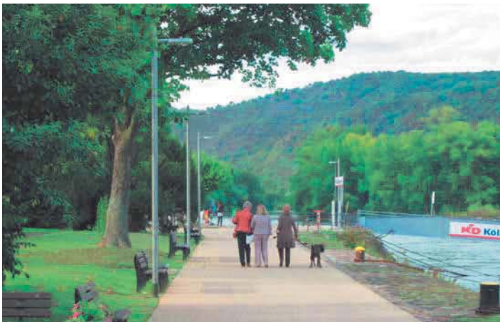
Mastleuchten im Hochwasserbereich (Rheinvorland Bacharach)
