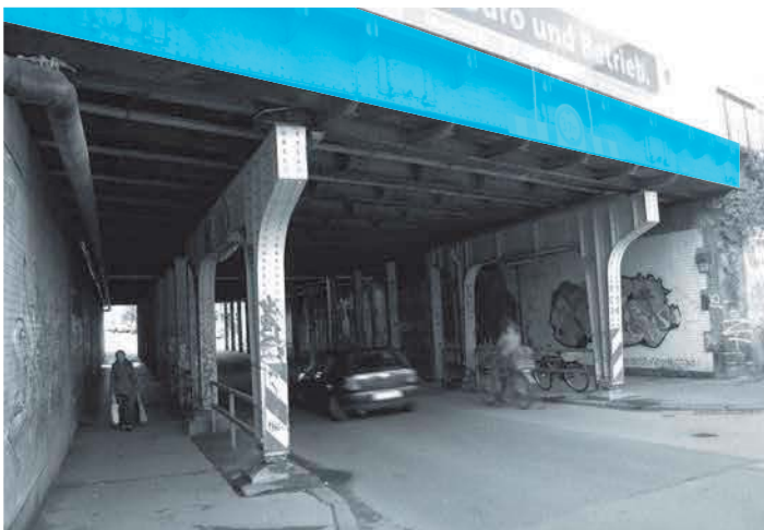
Markierung über Beleuchtung der Ein- und Ausgänge der Unterführungen als Portale
