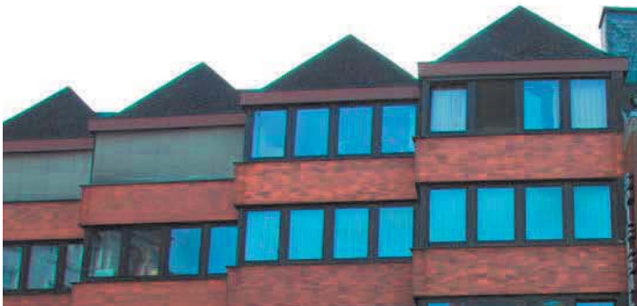
Strahlermontage an westliche Bebauung (Giebel) gut realisierbar
