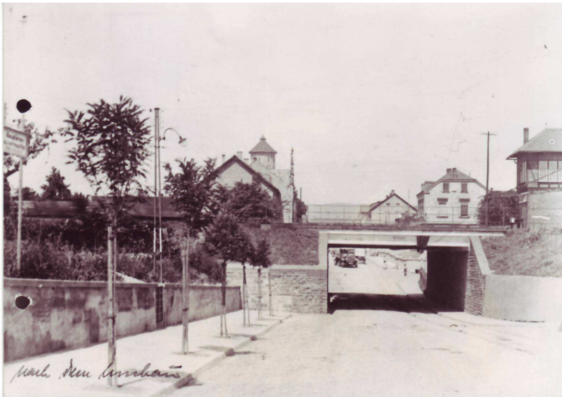
Stellwerk Engers-Nord vermutlich vor 1930
