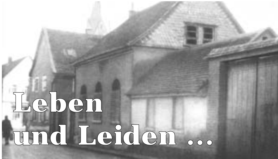
Die ehemalige jüdische Synagoge in der heutigen Kirchbornstraße.
