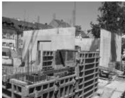
16.07.2007 Die Verschalung der Mikwe
