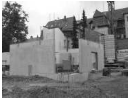
08.07.2007 der Neubau wächst in die Höhe
