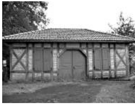
Taharahalle in Bödigheim. Sie wurde Anfang der 80iger Jahre restauriert
