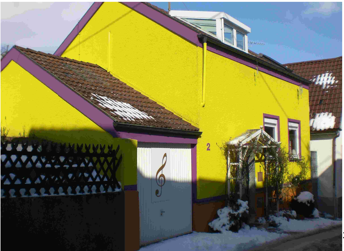
Das Wohnhaus auf dem Grundstück der ehemaligen Synagoge (heute)
