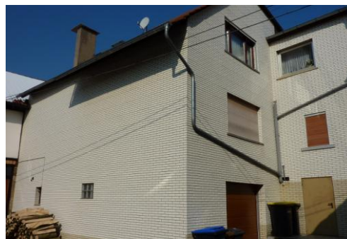
Rückseite von HN 68, ehemaliges Nebengebäude
