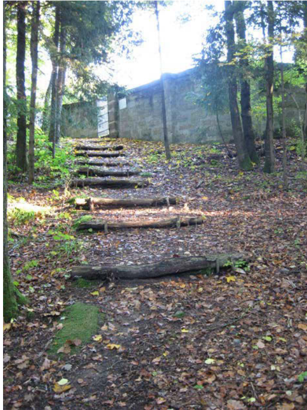
Abb. 40: Das Foto zeigt die heutige Zugangssituation: Ein Pfad mit aus Holzbalken gebildeten Stufen führt vom tiefer gelegenen Wirtschaftsweg zum Friedhof hinauf. Foto: Nicole Grom (Oktober 2011).
