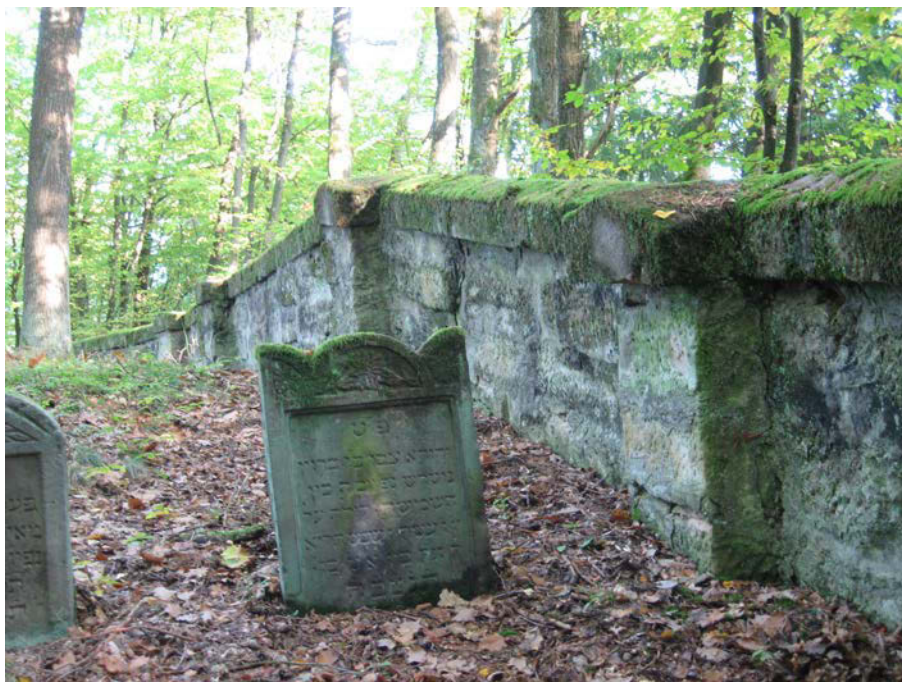
Abb. 43: Vorlagen im westlichen Bereich der Südmauer (sichtbare Grabsteine: Nrn. 199 und 200). Gut zu erkennen die durch leicht auskragende Abdeckplatten gebildete Mauerkrone. Foto: Nicole Grom (Oktober 2011).
