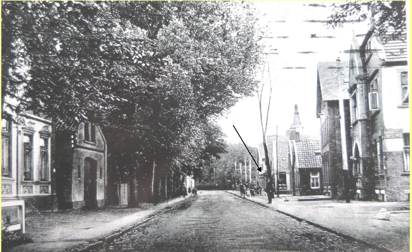
Neue Straße Weener (der Pfeil zeigt die Schlachtereier van der Zyl)
